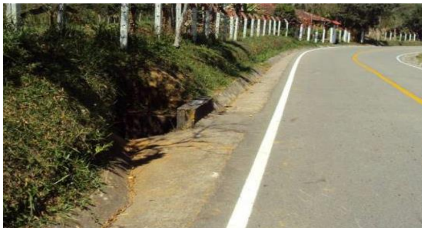
Ilustración 49. Suministro e instalación de estructuras hidráulicas
