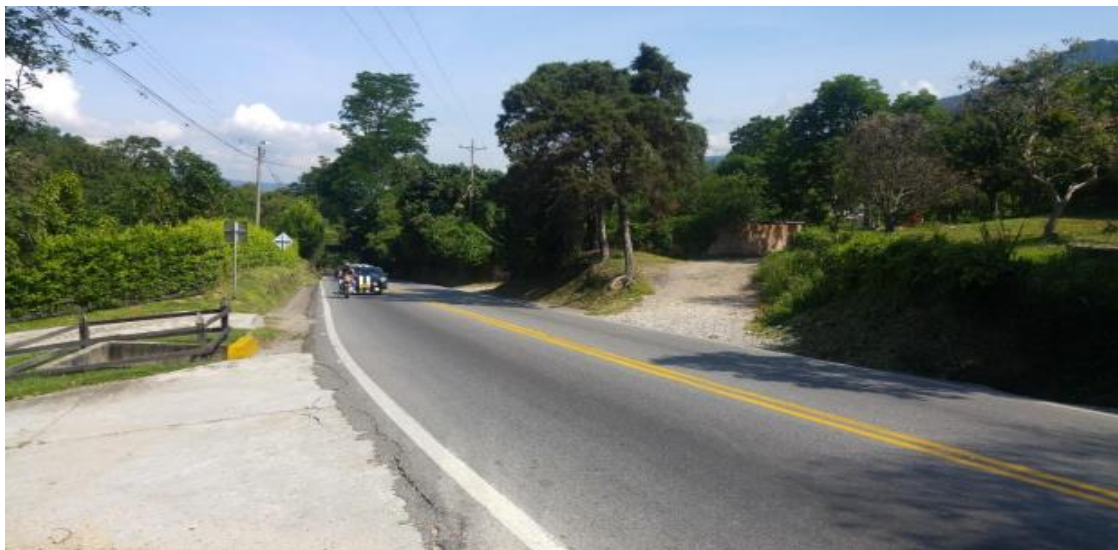
Ilustración 21. Estado de la vía Piedecuesta – Curos (punto Casa Bas)
