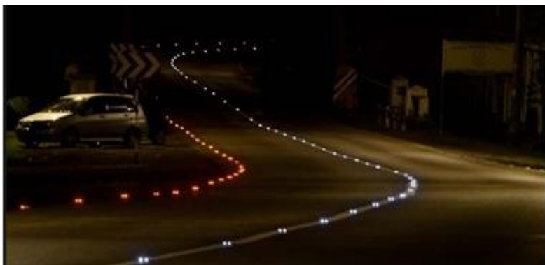
Ilustración 43. Suministro e instalación de tacha reflectiva
