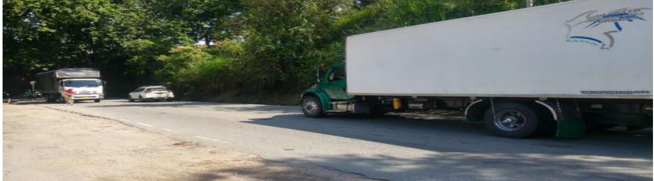
Ilustración 22. Estado de la vía Piedecuesta – Curos (punto Quijanos)
