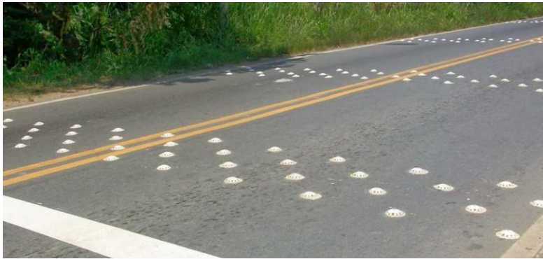
Ilustración 45. Suministro e instalación de estoperoles
