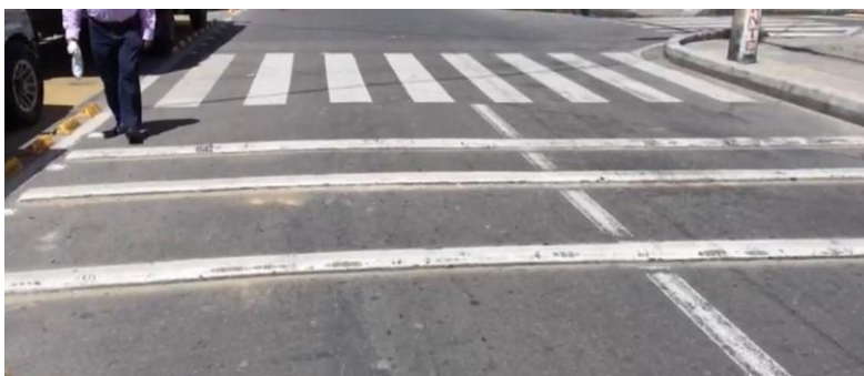
Ilustración 44. Instalación de bandas sonoras – reductoras de velocidad
