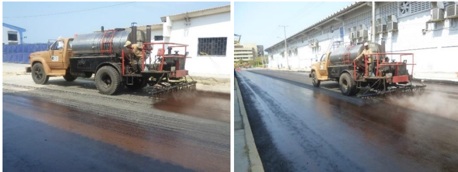
Fig. 17 Sello con emulsión asfáltica con polimeros. Fuente Propia
