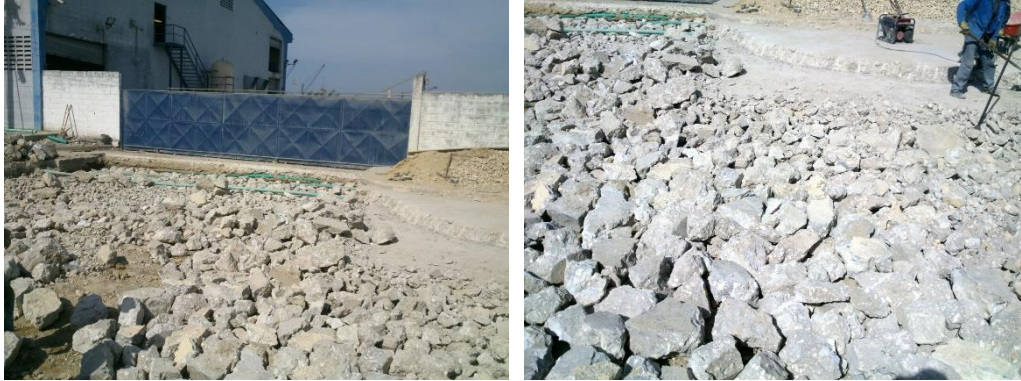
Fig. 37 Losas demolidas. Fuente propia
