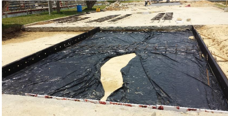
Fig. 53 Adecuación de la formaleta y del impermeable. Fuente Propia
