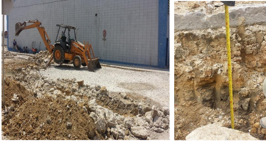
Fig. 28 Demolición y excavación mecánica. Entrega de corte. Fuente Propia.
