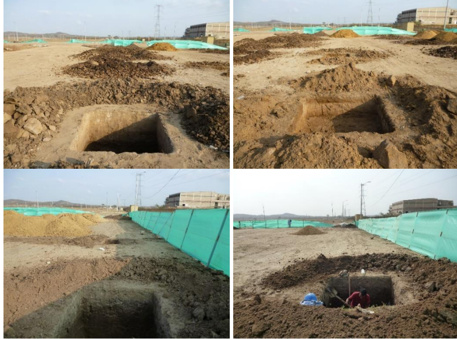
Fig. 83 Excavaciones para zapatas. Fuente Propia.
