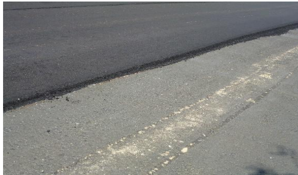
Fig. 13 Nivelación con asfalto y primera capa. Fuente Propia.
