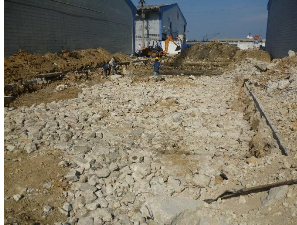
Fig. 29 Relleno con piedra de concreto. Fuente Propia.
