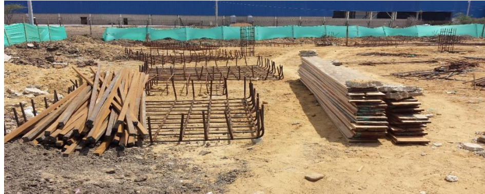
Fig. 84 Parrilla para Zapata. Fuente. Propia
