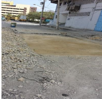
Fig. 8 Estabilización de pavimento con material. Fuente Propia
