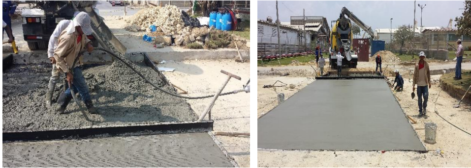
Fig. 55 Concreto, vibración. Fuente Propia
