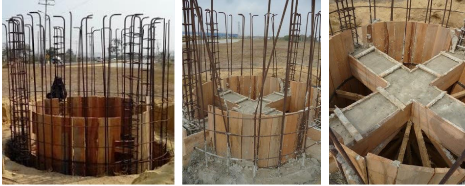
Fig. 72 Formaleta muro, Viga superior Fuente Propia
