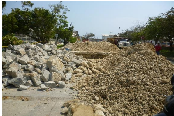
Fig. 47 Acopio de material. Fuente Propia
