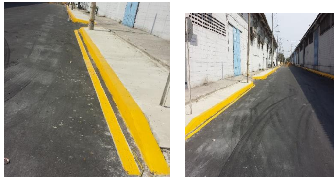
Fig. 24 Demarcación horizontal con pintura específica. Fuente: Propia.
