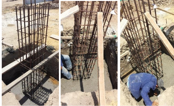
Fig. 86 Fundida de zapatas. Fuente Propia.
