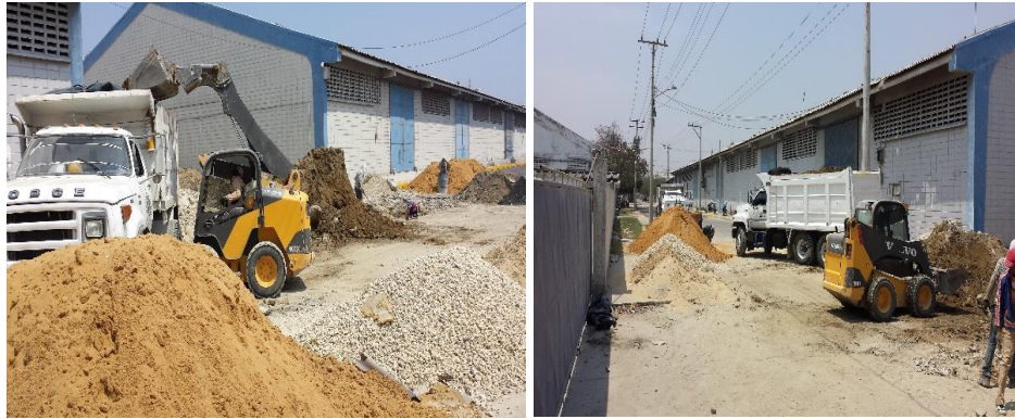
Fig. 33 Retiro de escombros, limpieza del área. Fuente Propia
