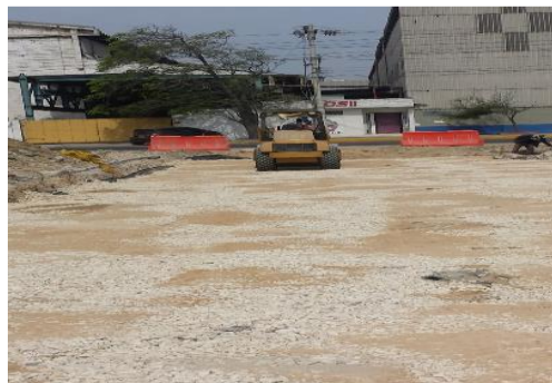
Fig. 36 Compactación mecánica. Fuente Propia
