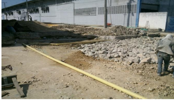
Fig. 38 Tuberías rehabilitadas. Fuente Arq. Jennifer Barros
