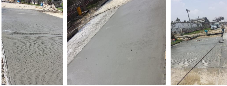
Fig. 56 Texturizado, fundida 16 abril, curado. Fuente Propia
