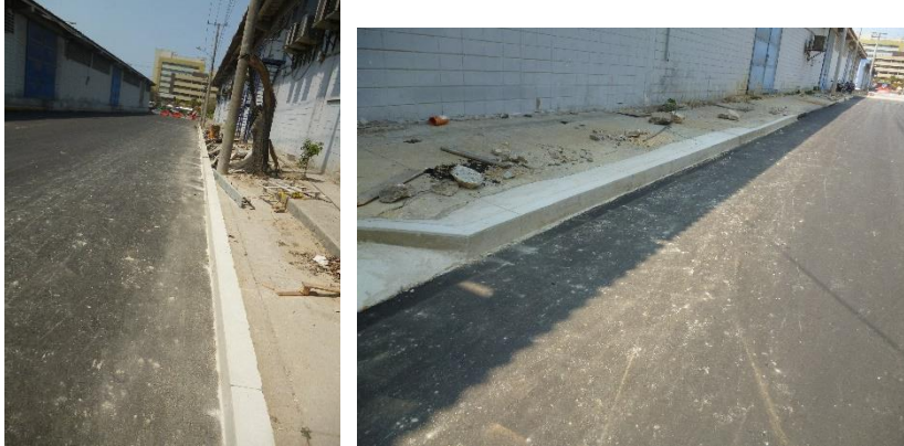
Fig. 21 Bordillos en concreto. Fuente Propia
