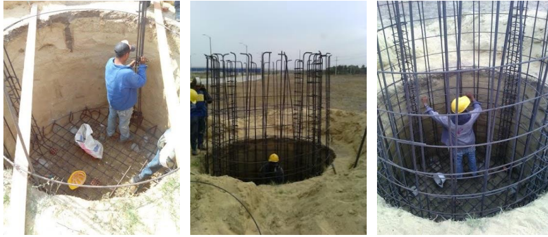
Fig. 70 Armado del acero estructural. Fuente Propia
