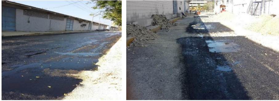
Fig. 9 Imprimación con emulsión asfáltica. Fuente Propia
