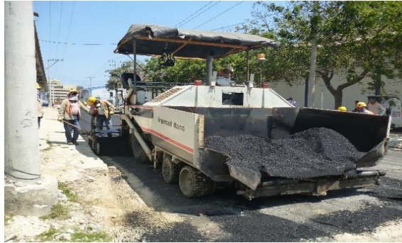
Fig. 12 Finisher en obra. Fuente Propia
