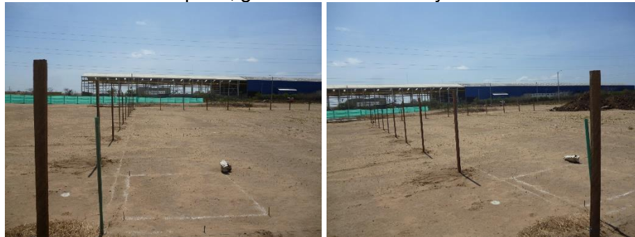
Fig. 82 Trazado de zapatas. Fuente. Topografía
