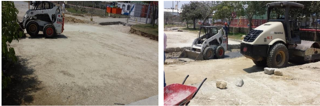
Fig. 50 Extensión y compactación del suelo cemento. Fuente Propia
