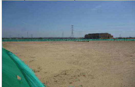
Fig. 81 Cerramiento en malla verde. Fuente ARQ Tatiana Yaguna
