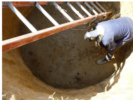
Fig. 69 Solado de zapata. Fuente Arq. Tatiana Yaguna
