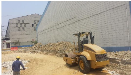
Fig. 31 Compactación relleno con arena. Fuente Propia
