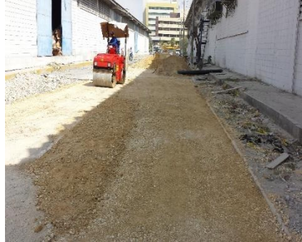
Fig. 7 Compactación mecánica de la Base granular. Fuente Propia
