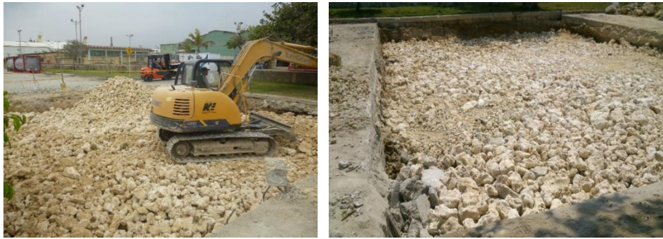
Fig. 48 Relleno con piedra ciclopea. Fuente propia
