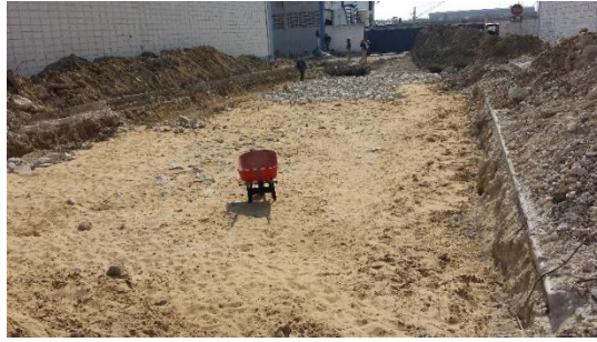
Fig. 30 Relleno con arena, cama para geotextil. Fuente Propia.
