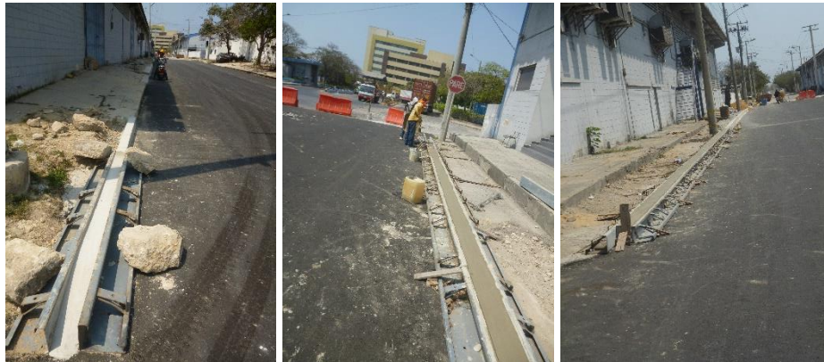
Fig. 20 Fundida de Bordillos. Fuente Propia
