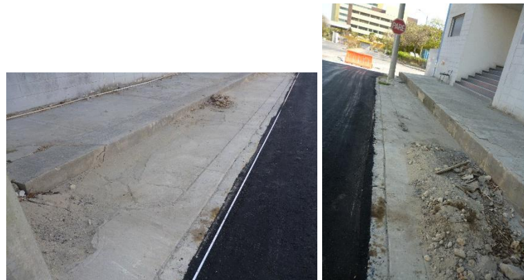
Fig. 19 Andenesy bordillos sobre el nivel de vía. Fuente Propia
