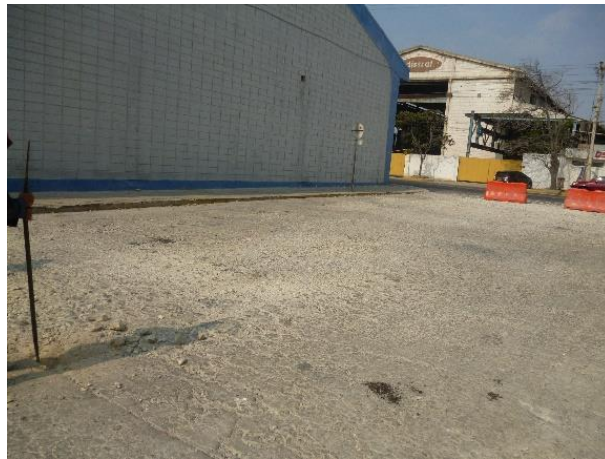
Fig. 25 Vía antes de intervención civil. Fuente Propia
