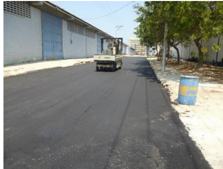
Fig. 15 Compactación con neumático. Fuente Propia.
