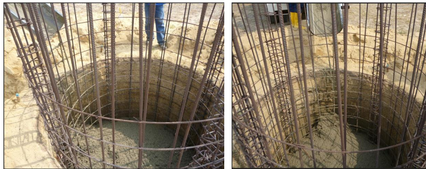
Fig. 71 Fundida de zapata. Fuente Propia
