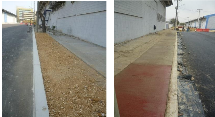
Fig. 22 Relleno con Subbase. Fuente Propia
