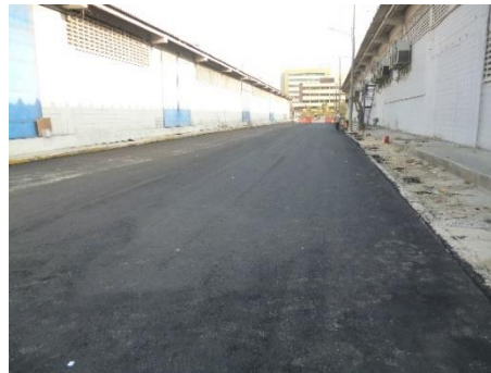
Fig. 16 Pavimento Flexible terminado. Fuente Propia
