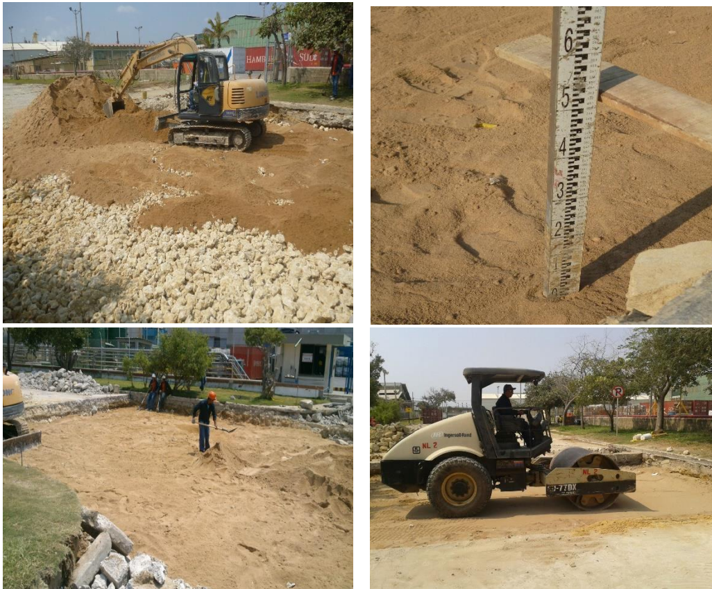
Fig. 49 Relleno con arena. Fuente Propia
