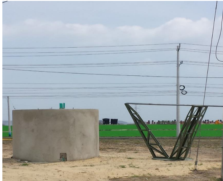
Fig. 74 Estructuras de soporte del globo. Fuente Propia.
