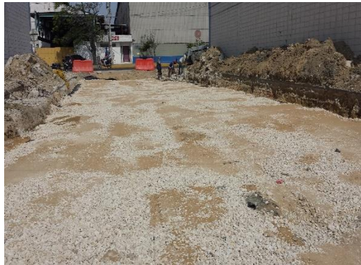
Fig. 35 Subbase Granular. Fuente Propia
