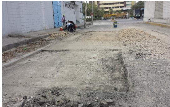
Fig. 6 Demolición de placas y Excavación inicial para reparcheos. Fuente Propia
