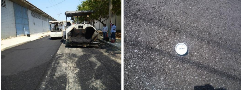
Fig. 14 Compactación con rodillo / Termómetro. Fuente Propia
