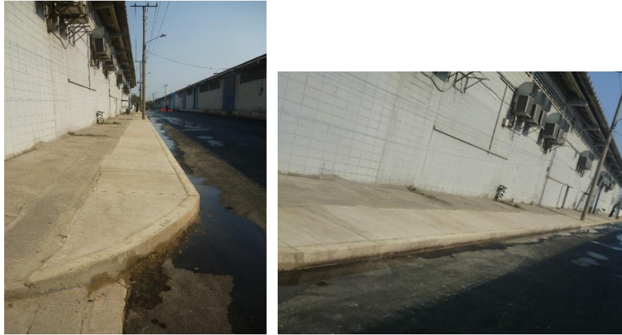
Fig. 23 Andenes en concreto. Fuente Propia
