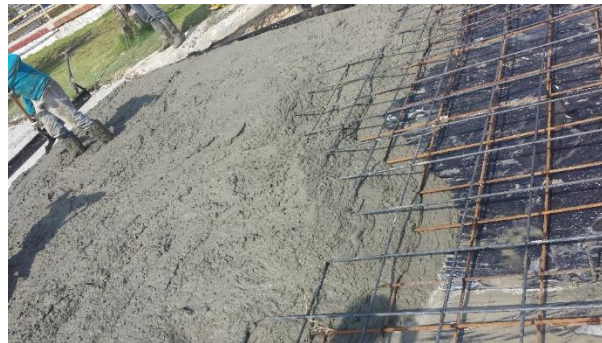
Fig. 58 Acero de refuerzo. Fuente Propia
