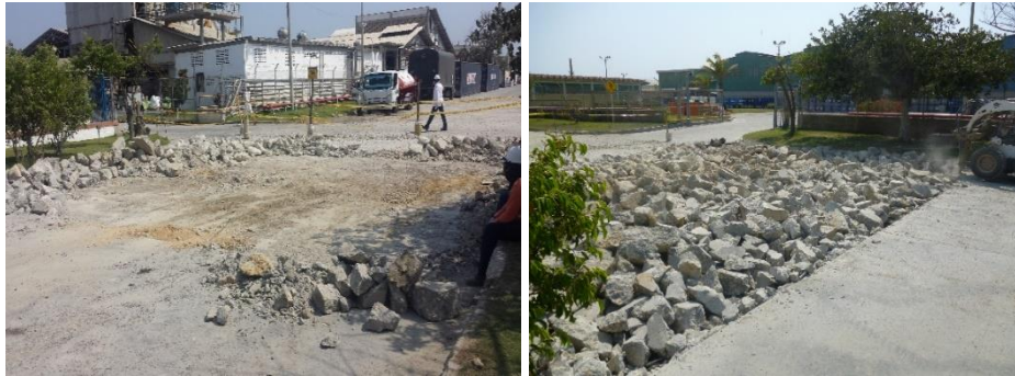
Fig. 44 Demolicion de placas. Fuente Propia
