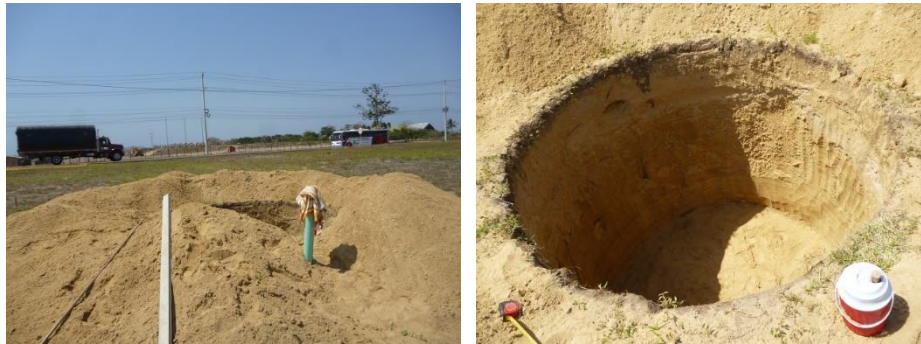
Fig. 68 Excavación para zapata. Fuente Arq. Tatiana Yaguna
