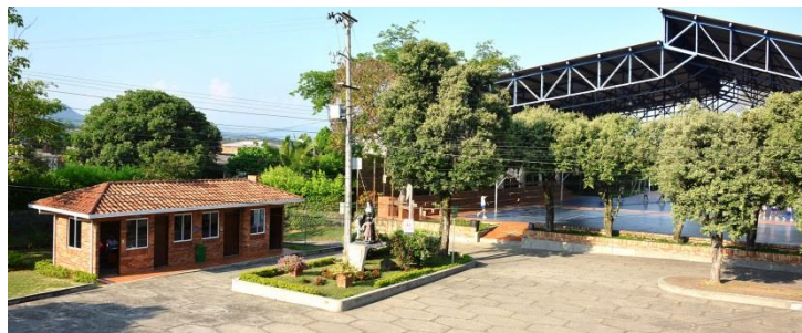
Fachada de la institución
