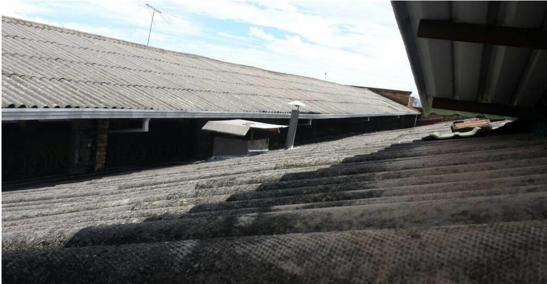
Fotografía 3. Punto de descarga del ducto de evacuación de gases de la cámara de pintura.
