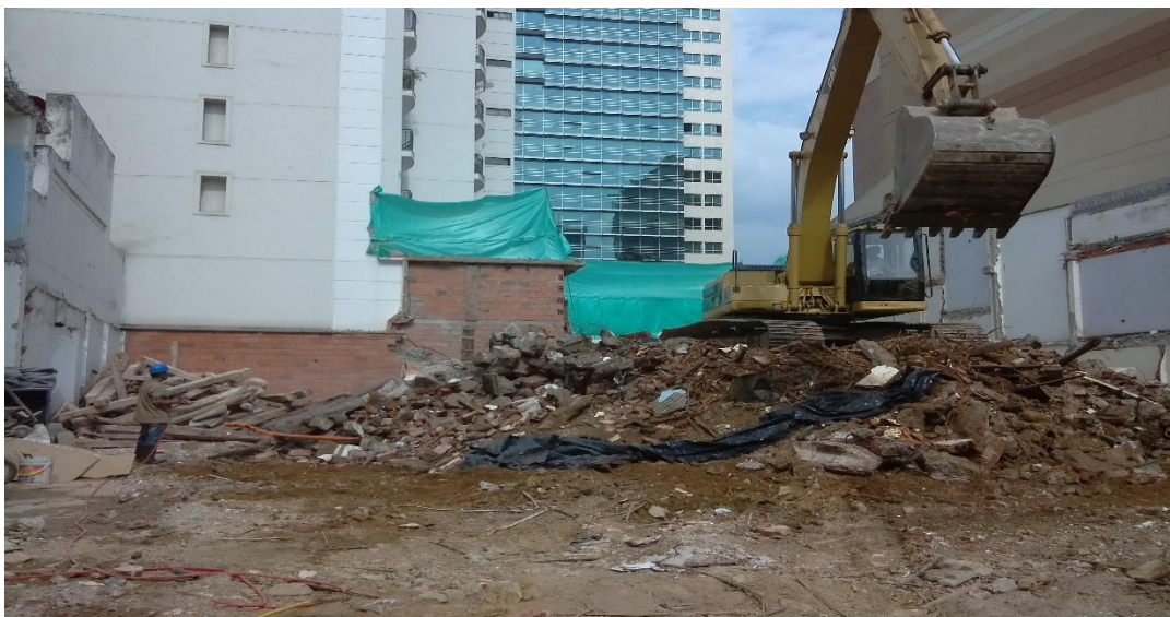
Fotografía 1. Instalación de mallas polisombra en obra privada.
