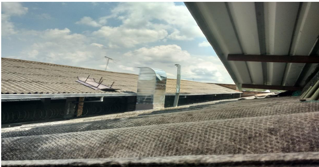
Fotografía 7. Adecuaciones al punto de descarga del ducto de conducción y evacuación de gases de cámara de pintura.
