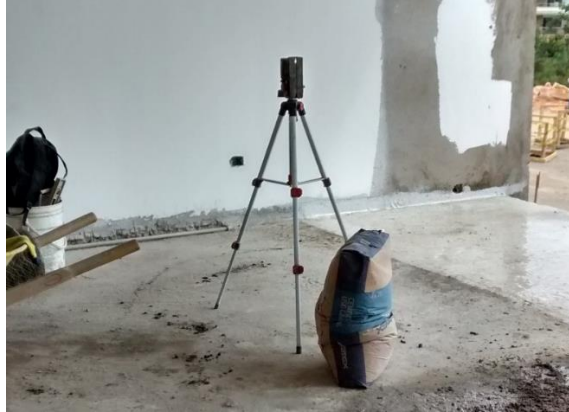
Figura 37. Equipo utilizado para demarcación de niveles con láser
