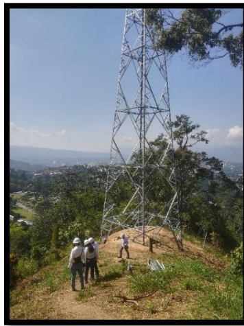
6 Fuente Propia, Infraestructura torre de alta tensión.
