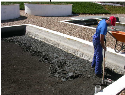
Imagen 16. Retirada de la costra por medio de rastrillado
