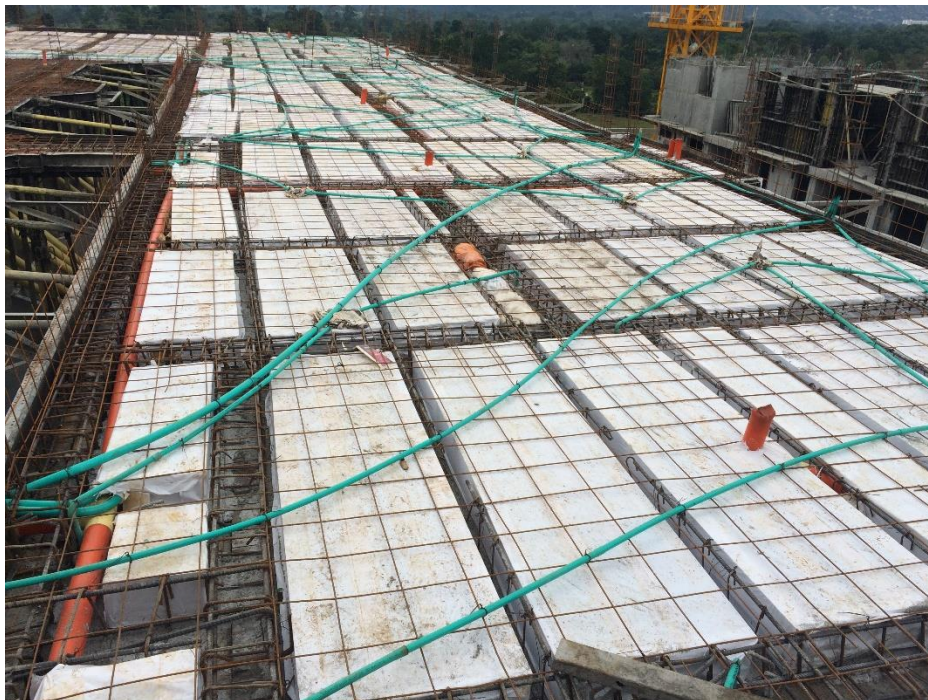
Figura 10. Placa con instalacion de las redes electricas y sanitarias.
