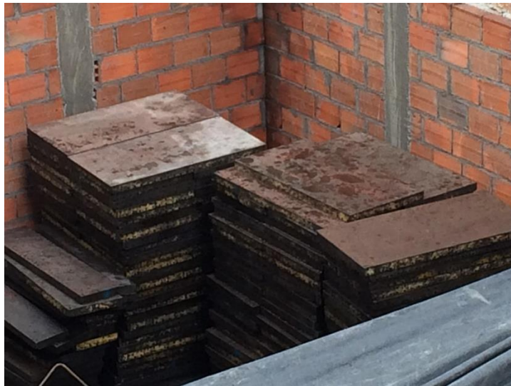
Figura 21. Acopio de formaleta en obra
