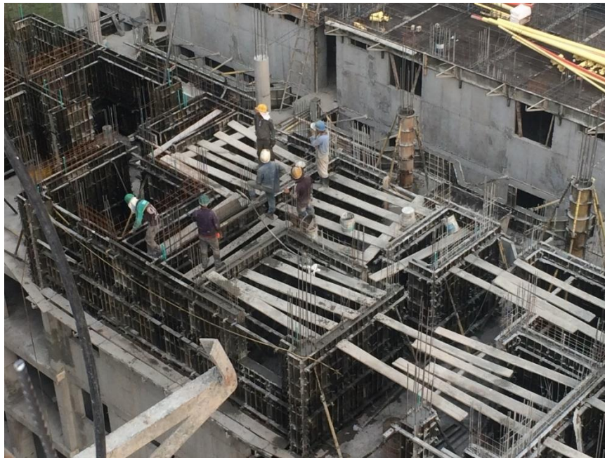
Figura 23. Formaleta para muros con entablado para el desplazamiento de los obreros
