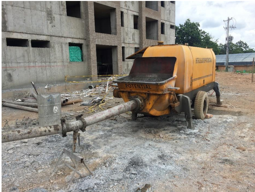
Figura 11. Bomba de concreto.
