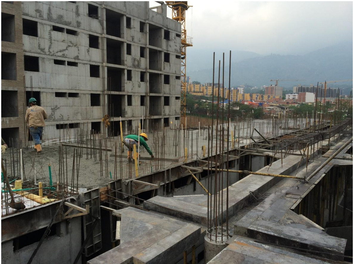
Figura 13. Fundida y corte de placa en proceso
