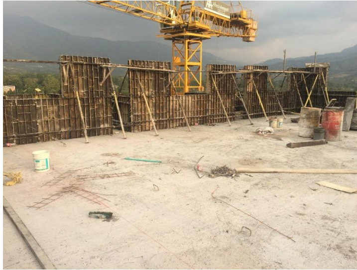
Figura 22. Encofrado de formaleta para antepechos
