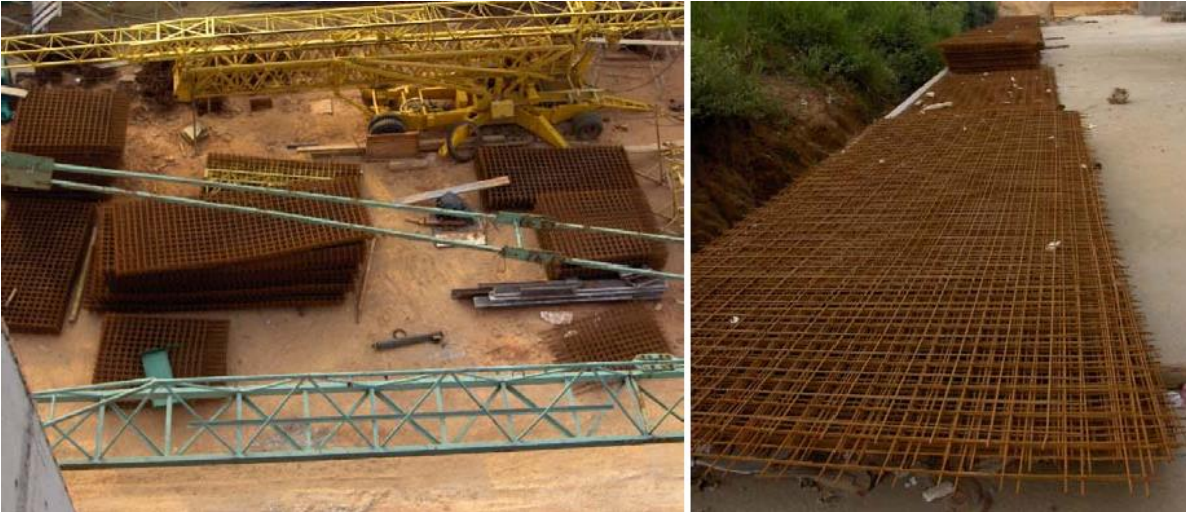
Figura 7. Malla electrosoldada en obra
