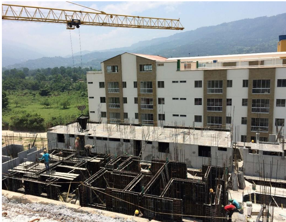
Figura 19. Fundida de muros en proceso (izquierda) siguiente módulo a la espera de ser fundido (derecha)
