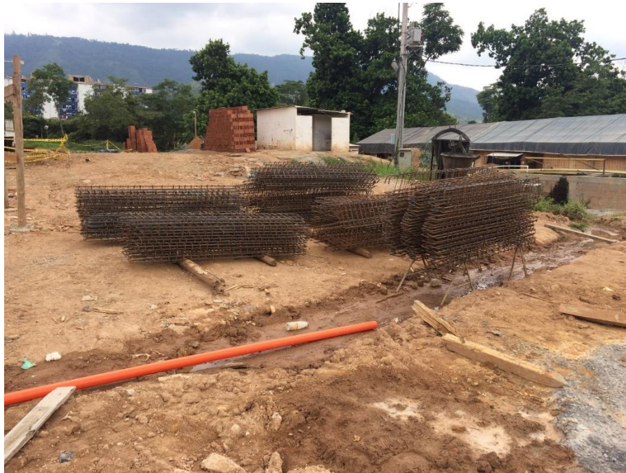
Figura 20. Acero de refuerzo de los elementos verticales de los muros
