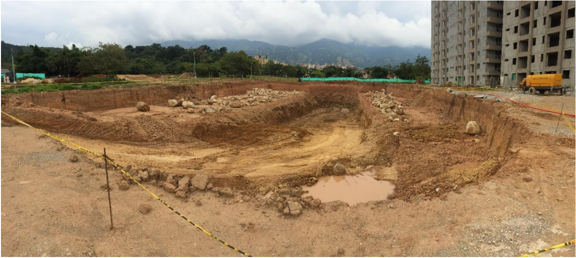
Figura 5. Panorámica de la excavación realizada
