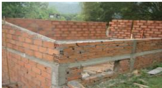
Imagen 56, 57 y 58. Detalles de la fundición de placa, cubierta y mampostería. Fuente del autor
