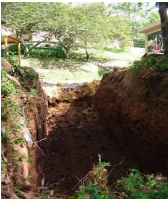
Imagen 44 y 45. Excavación del descargue del filtro y detalle del riego de cemento. Fuente del autor
