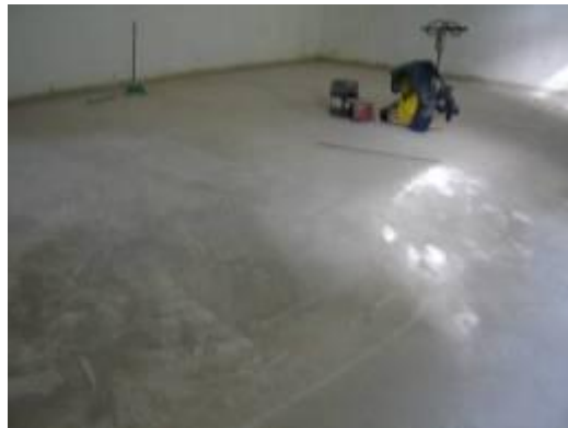
Imagen 7: Terminación del piso pulido. Fuente del autor
