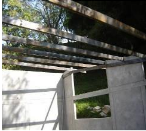
Imagen 2: Estructura metálica de la cubierta. Fuente del autor
