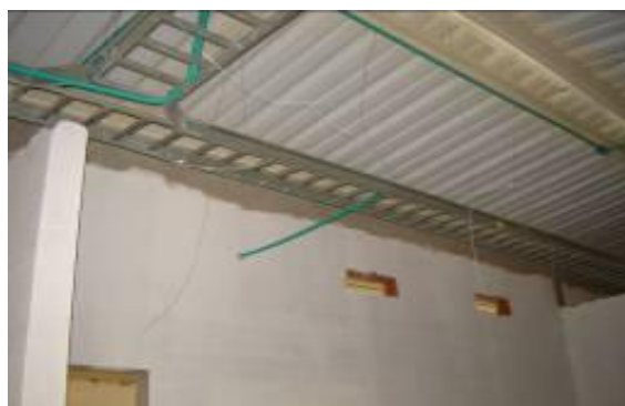
Imagen 9 y 10: Armado del cielo Raso. Fuente del autor
