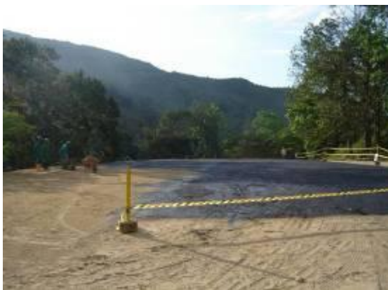
Imágenes 25, 26, 27 y 28: Aplicación de Emulsión Asfáltica en los parqueaderos. Fuente del autor
