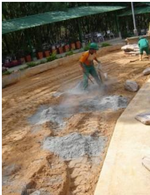
Imagen 44 y 45. Excavación del descargue del filtro y detalle del riego de cemento. Fuente del autor
