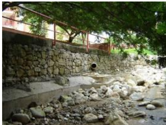
Imagen 65, 66, 67 y 68. Detalle Gavión, _esarenadotes, y andenes. Fuente del autor
