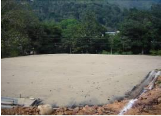
Imágenes 29 y 30: Aplicación de emulsión asfáltica en los parqueaderos. Fuente del autor
