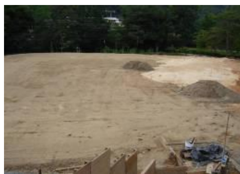
Imágenes 21 y 22: Riego de la Emulsión Asfáltica en Terraza y extensión de recebo en estudiantes. Fuente del autor
