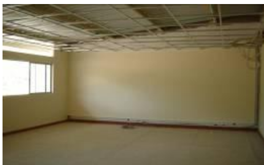
Imagen 11: Instalaciones Eléctricas y pintura interior de piso y paredes, además del guardaescobas. Fuente del autor
