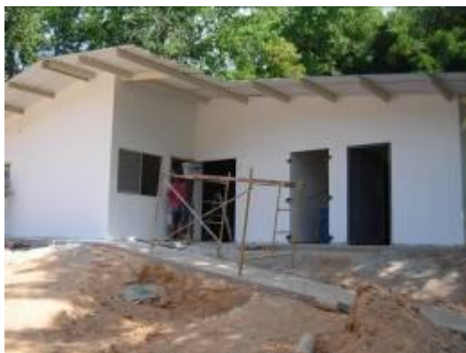
Imagen 8: Aplicación de la capa de estuco. Fuente del autor
