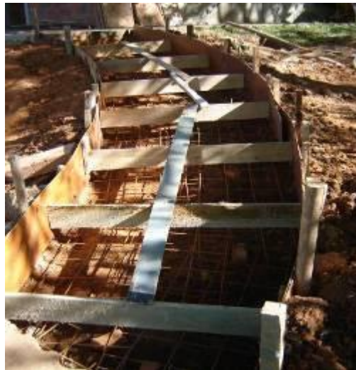
Imagen 3: Escalera de acceso a las Aulas A. Fuente del autor
