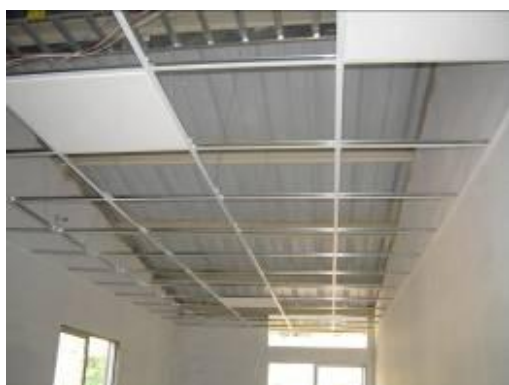
Imagen 9 y 10: Armado del cielo Raso. Fuente del autor
