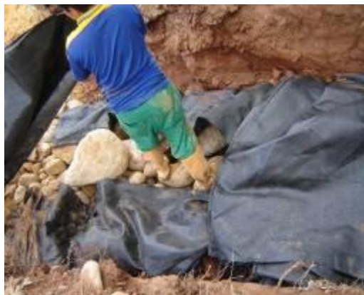
Imagen 46 y 47. Problemas de aguas y Filtro de descargue. Fuente del autor
