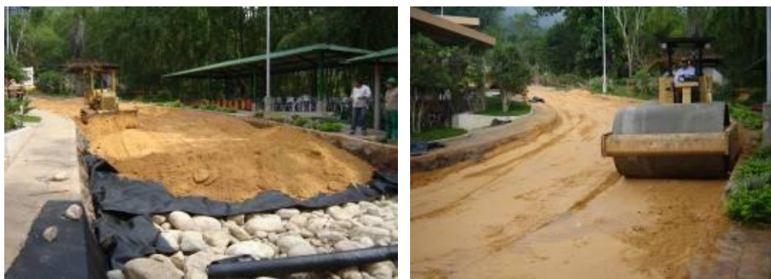
Imagen 40, 41, 42 y 43. Compactación del material del K con espesor de 30cm al 2%. Fuente del autor
