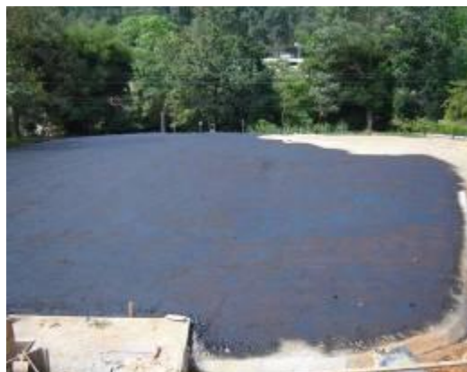
Imágenes 25, 26, 27 y 28: Aplicación de Emulsión Asfáltica en los parqueaderos. Fuente del autor
