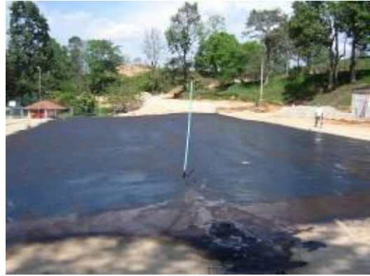
Imágenes 29 y 30: Aplicación de emulsión asfáltica en los parqueaderos. Fuente del autor
