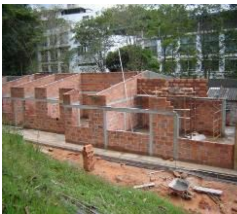
Imagen 1: Levantamiento de la mampostería. Fuente del autor
