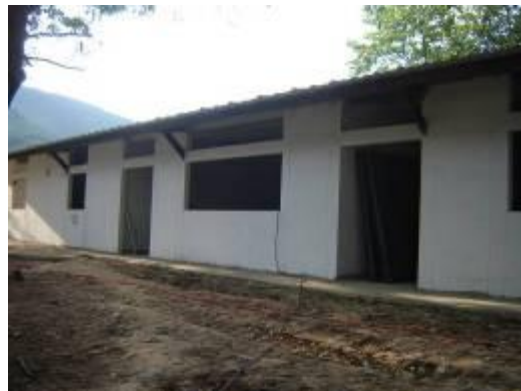
Imagen 4: Aplicación de estuco y armado de la cubierta. Fuente del autor
