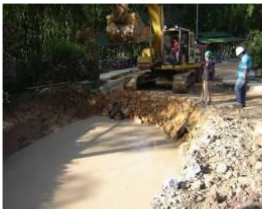
Imagen 46 y 47. Problemas de aguas y Filtro de descargue. Fuente del autor
