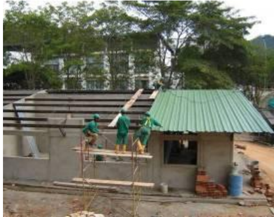
Imagen 5: Instalación cubierta termo-acústica. Fuente del autor
