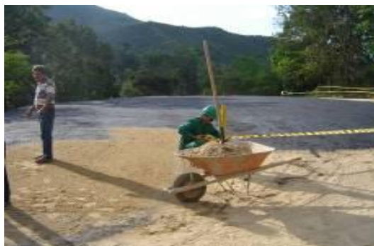
Imágenes 21 y 22: Riego de la Emulsión Asfáltica en Terraza y extensión de recebo en estudiantes. Fuente del autor
