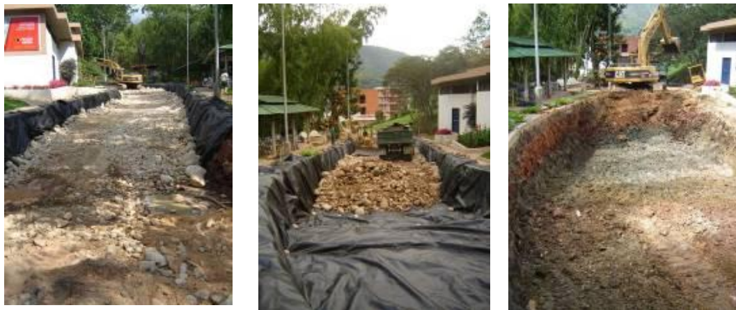
Imagen 39. Excavación del Terreno, colocación del Geotextil y descargue de Grava. Fuente del autor
