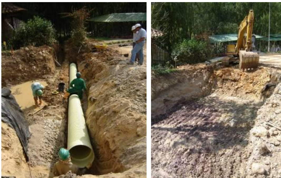
Imagen 48 y 49. Instalación de tubería de aguas lluvias del K. Fuente del autor
