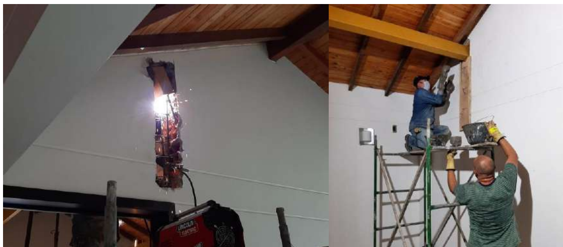
Ilustración 76 – Soldado y fundido de perfiles
