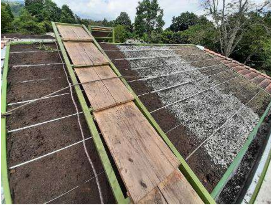
Ilustración 49 - Adición del sustrato en toda la cubierta
