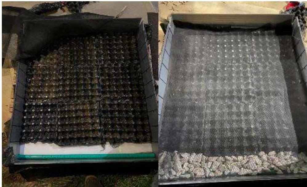
Ilustración 35 - Instalación tubo para desagüe y malla de angeo como filtrante
