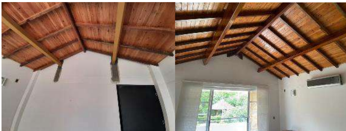
Ilustración 41 – Culminación labores de refuerzo
