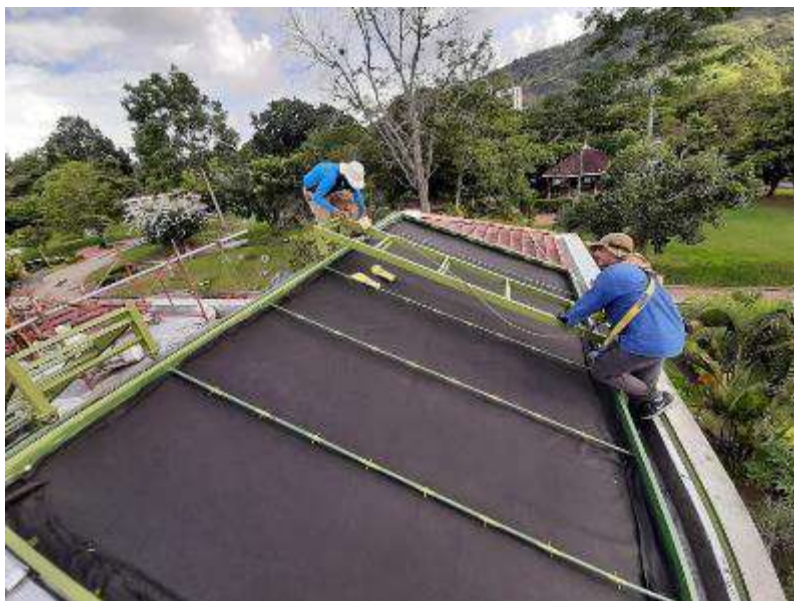
Ilustración 48 - Instalación de plástico negro, lámina drenante y geotextil filtrante
