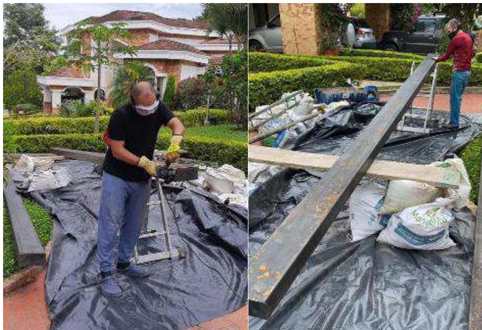
Ilustración 38 - Adecuación de perfiles in situ previos al montaje
