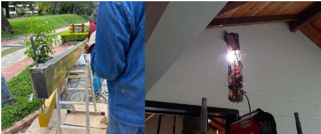
Ilustración 74 – Pintura y soldadura de perfiles
