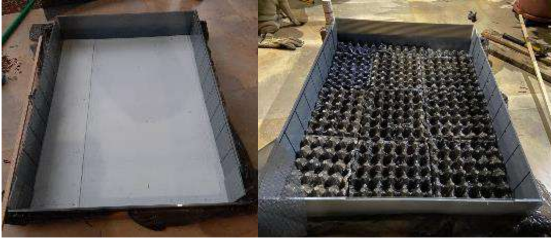
Ilustración 34 - Base forrada con cartón plastificado y cartón de huevos como drenante
