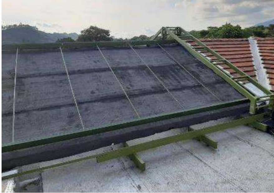
Ilustración 47 - Instalación de marcos para anclajes y plataforma de la cubierta verde
