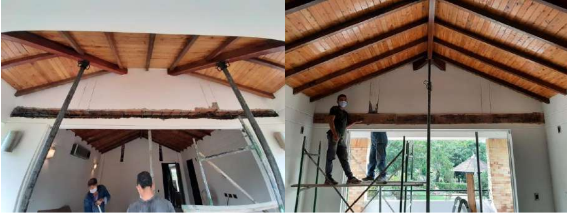
Ilustración 73 – Instalación y fundida de viga adicional
