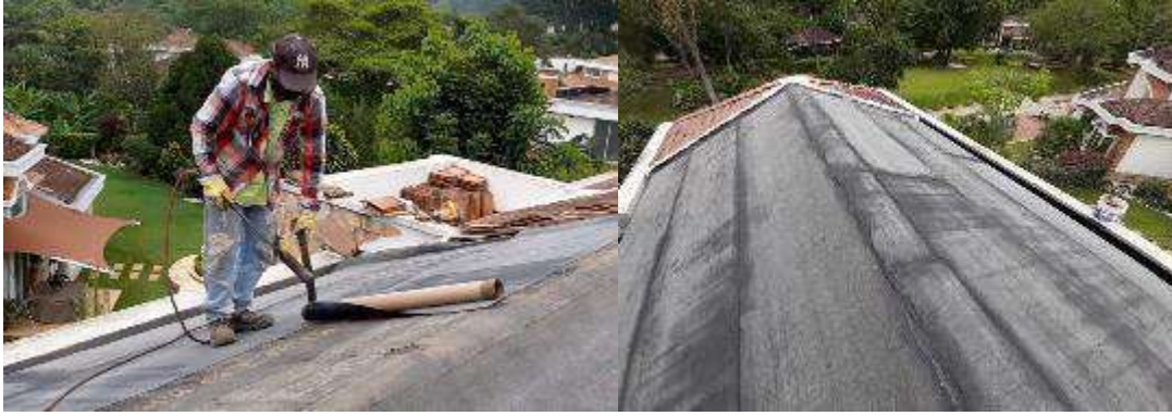
Ilustración 45 – Aplicación de manto asfáltico con soplete de calor
