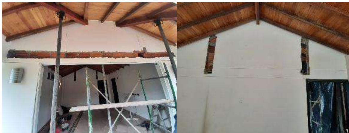
Ilustración 39 - Corte de muros para fundida de perfiles
