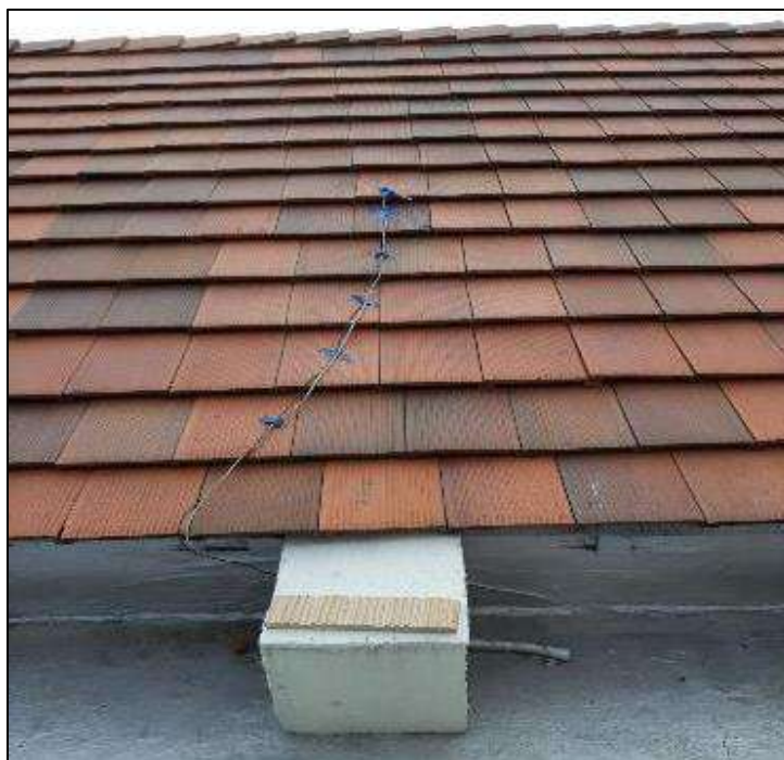
Ilustración 20 – Instalación termómetro en el techo de la habitación
