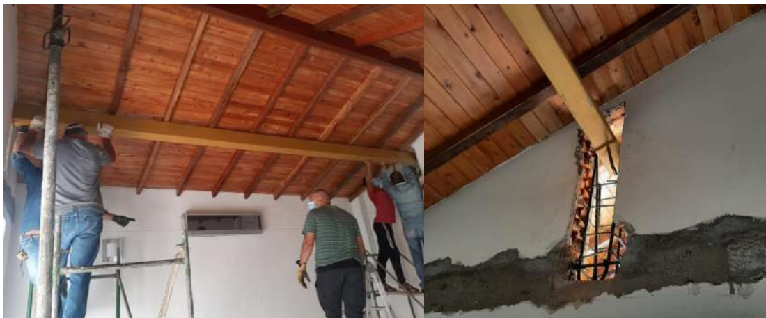
Ilustración 75 – Instalación y conexión de perfil de refuerzo
