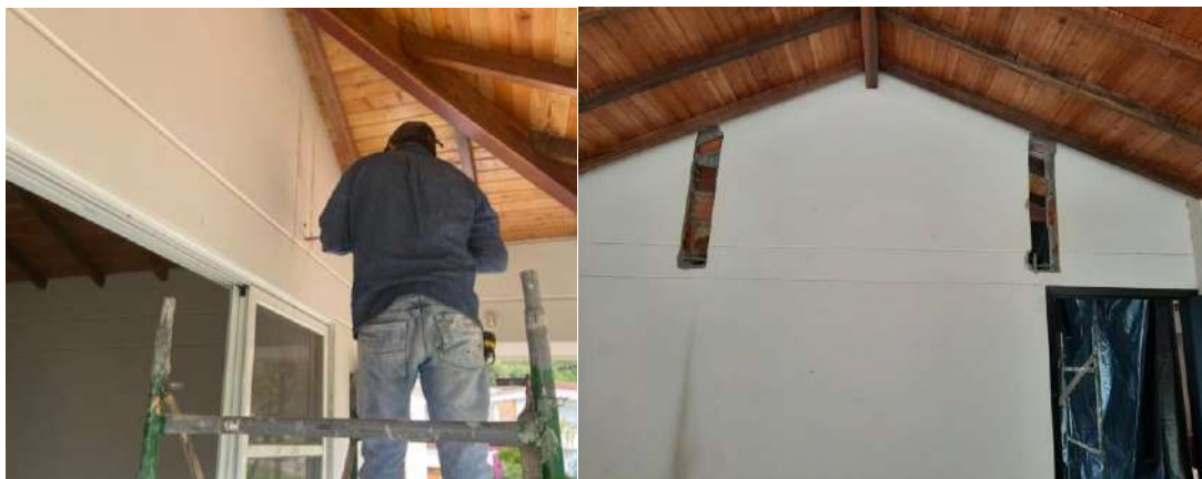
Ilustración 72 – Proceso de demolición para conexión entre perfil y viga
