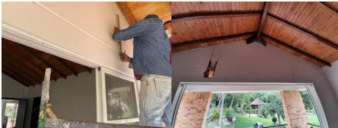
Ilustración 71 – Demarcación para demolición de la pared
