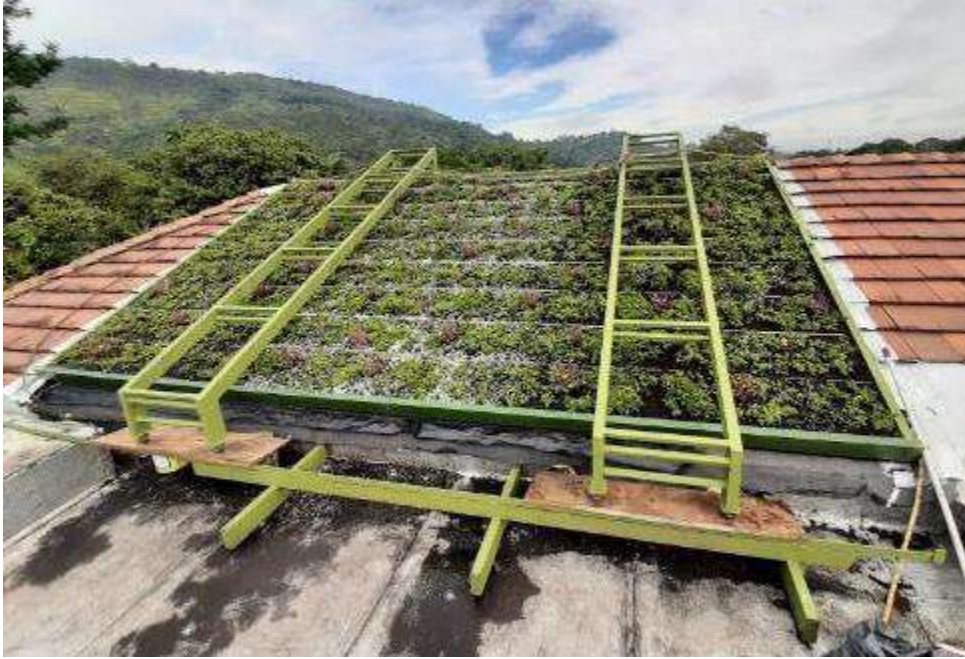
Ilustración 50 - Instalación de plantas y terminación cubierta verde
