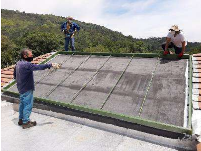
Ilustración 46 - Montaje del marco de protección contra el deslizamiento del sustrato
