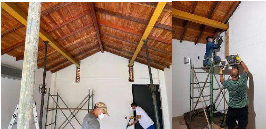
Ilustración 40 - Instalación y fundida de perfiles
