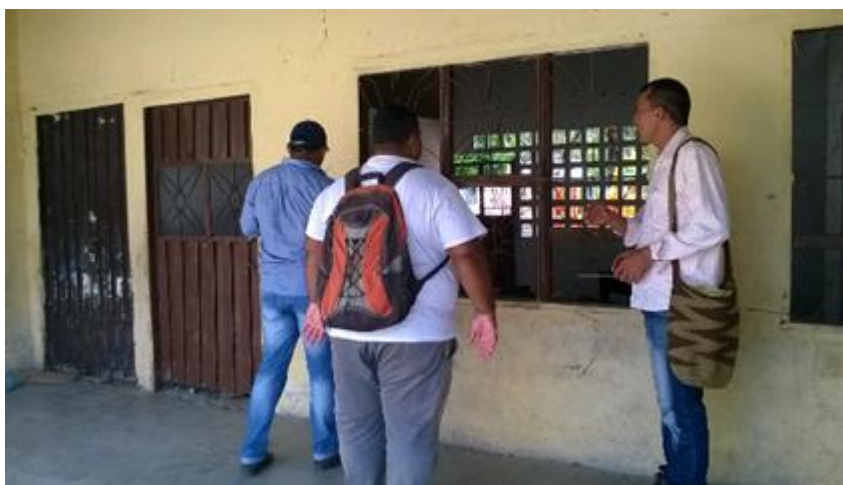
Figura 13. Instalación de puertas de madera
