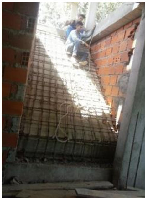
Figura 7. Armado estructural de escalera principal
