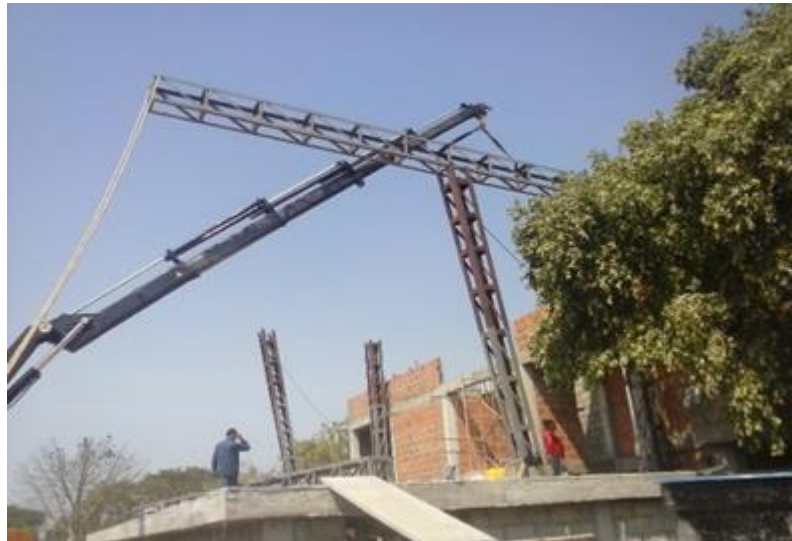
Figura 10. Instalación de vigas de acero para cubierta
