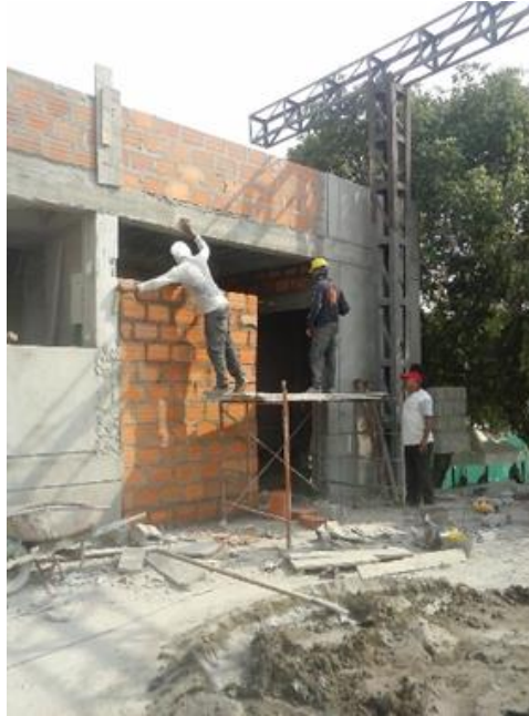
Figura 9. Mampostería parte superior frente de la tarima
