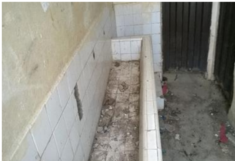
Figura 16. Adecuación salón de baños
