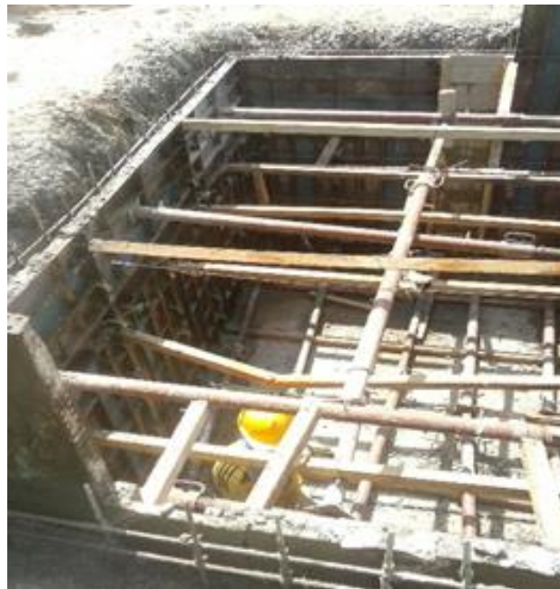
Figura 6. Armado y fundida paredes tanque de 2000 PSI
