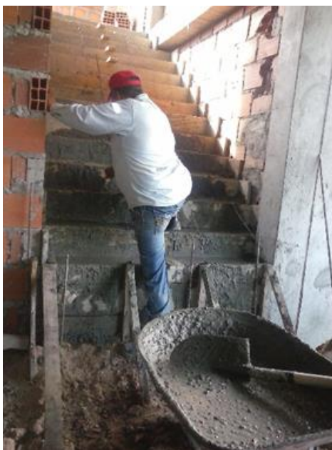
Figura 8. Vaseado de concreto de 3000 PSI para escalera principal
