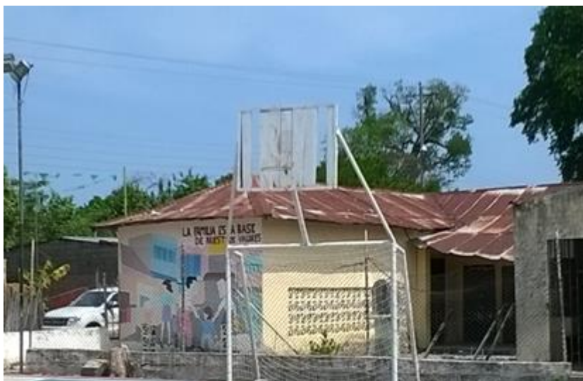
Figura 12. Malla de cerramiento de la cancha
