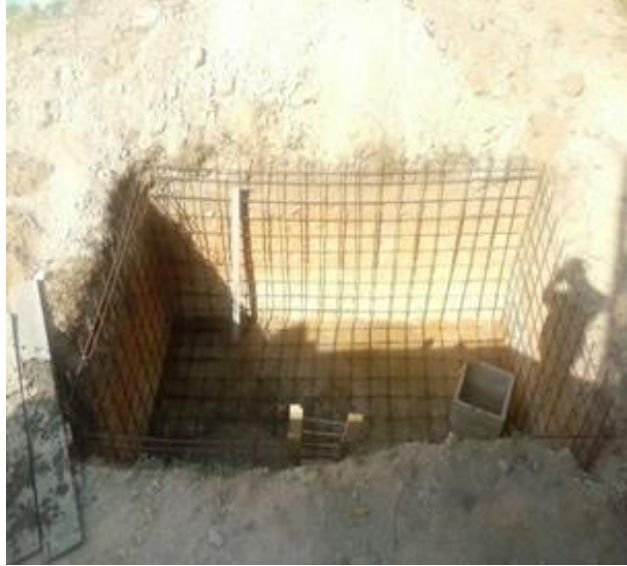
Figura 5. Colocación de acero para tanque de equilibrio
