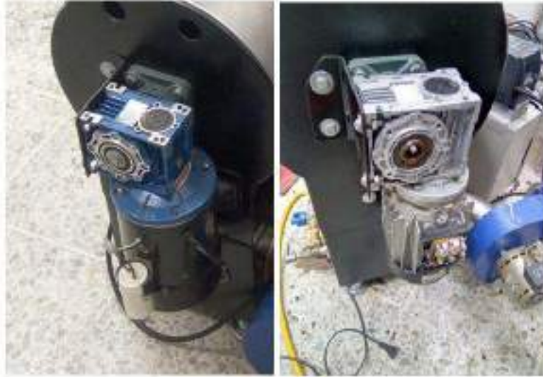
Ilustración 14: evidencia Cambio de motor con Motorreductor
