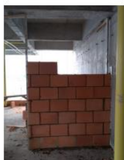
Figura 33. Proceso mortero de pega – Obra 3 Fuente: Autor
