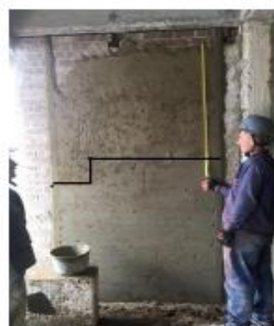
Parte superior: mortero hecho en obra
