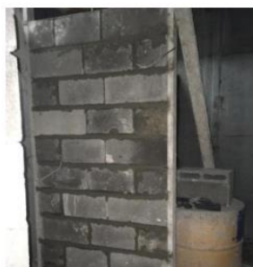
Figura 29. Proceso mortero de pega – Obra 1 Fuente: Autor
