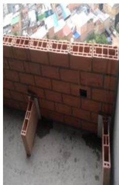
Figura 32. Proceso mortero grout – Obra 2 Fuente: Autor
