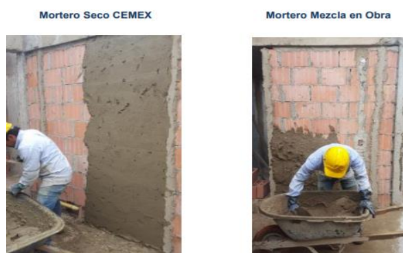
Figura 27. Proceso mortero pañete – Obra 1 Fuente: Autor
