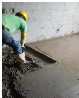
Figura 28. Proceso mortero nivelación de pisos – Obra 1 Fuente: Autor
