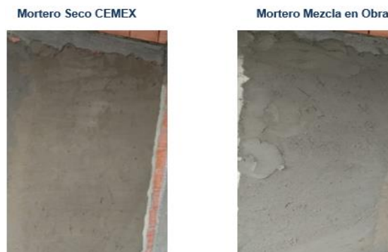
Figura 30. Proceso mortero pañete – Obra 2 Fuente: Autor
