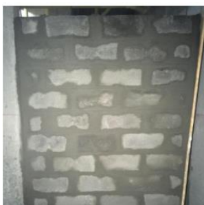
Figura 29. Proceso mortero de pega – Obra 1 Fuente: Autor
