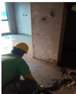
Figura 28. Proceso mortero nivelación de pisos – Obra 1 Fuente: Autor
