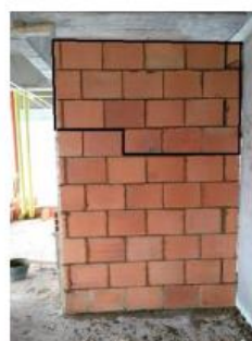
Figura 33. Proceso mortero de pega – Obra 3 Fuente: Autor
