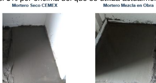
Figura 31. Proceso mortero nivelación de pisos – Obra 2 Fuente: Autor
