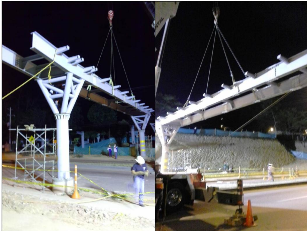
Figura 52. Instalación de la estructura en los apoyos 2 y 3
