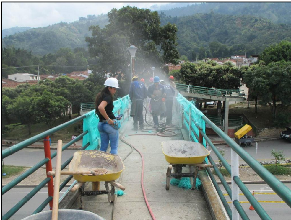
Figura 40. Demolición concreto del tablero principal
