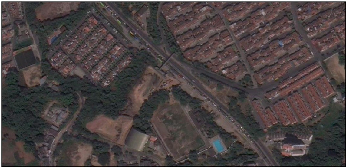
Figura 6. Vista área proyecto Intercambiador Vial San Francisco
