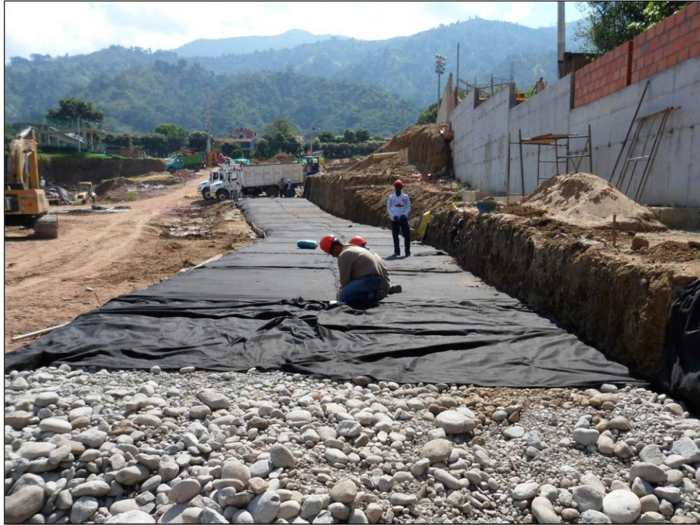
Figura 95. Colchón drenante eje 4
