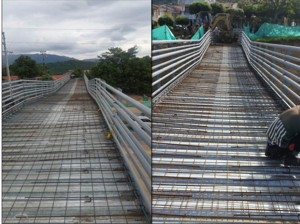
Figura 59. Colocación de acero tablero principal
