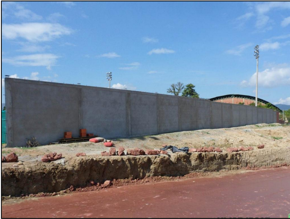
Figura 12. Terminación de friso parte externa muro norte de la cancha
