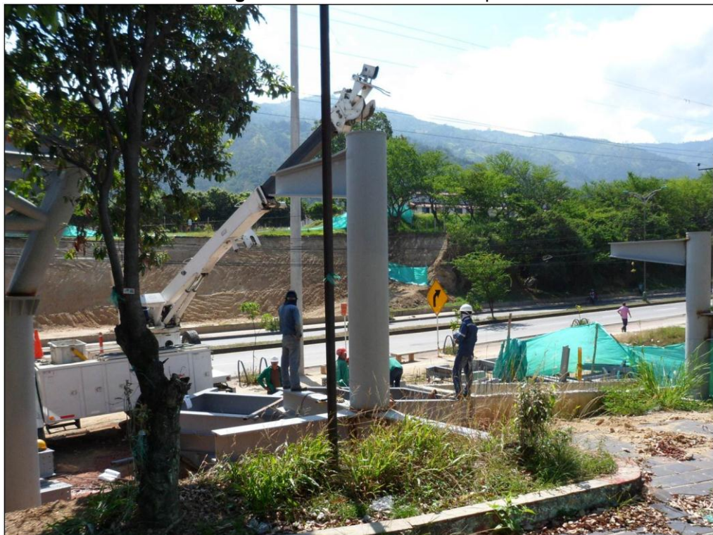
Figura 56. Instalación de la rampa
