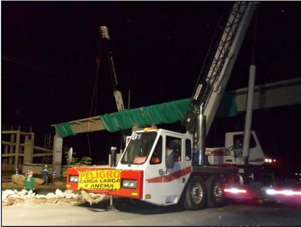
Figura 43. Grúa LINK-BELT 70 Toneladas
