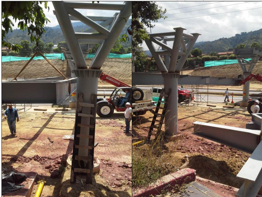
Figura 54. Instalación de la estructura apoyos 3 y 4
