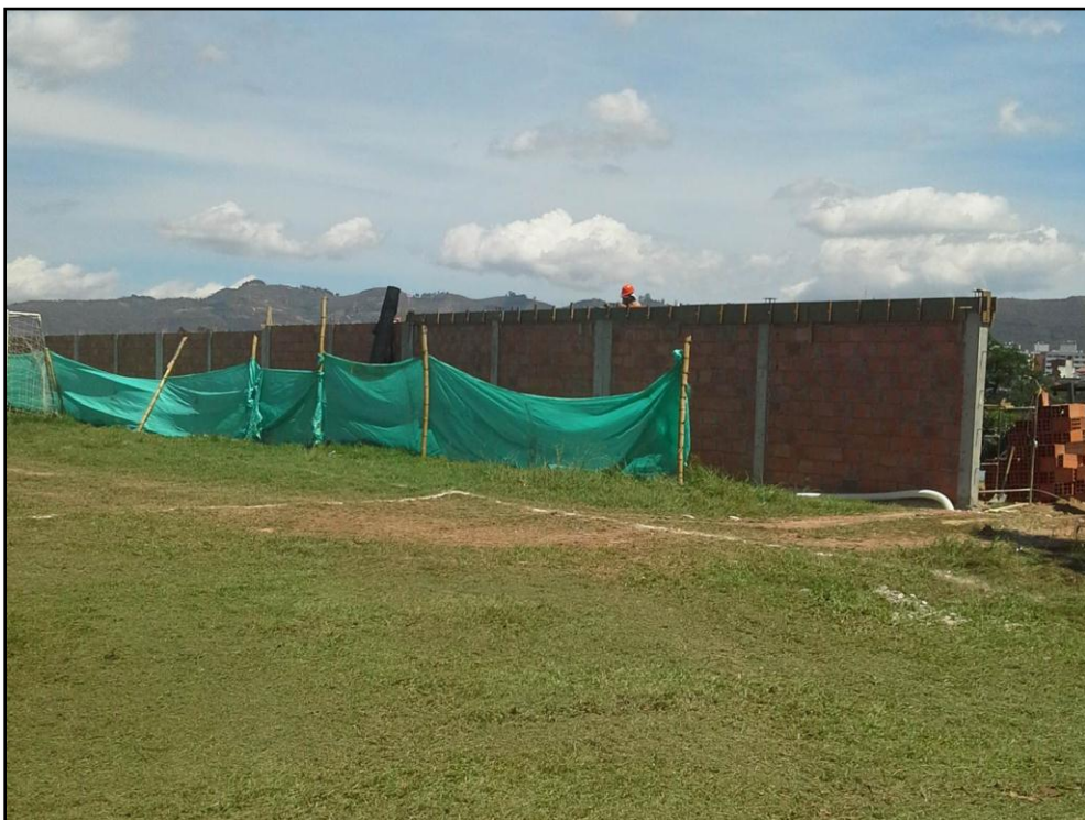
Figura 9. Fundida viga cinta e instalación de platinas muro norte de la cancha
