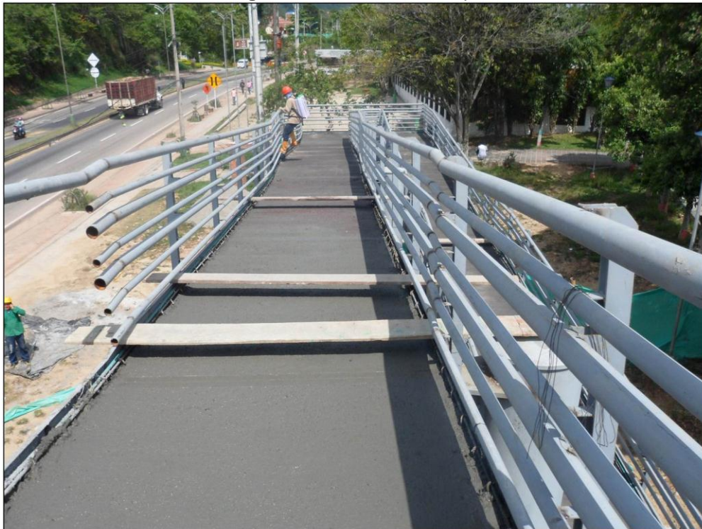
Figura 66. Acabado de rampa
