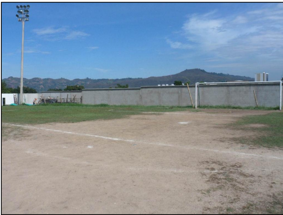
Figura 15. Terminación alfajía muro norte de la cancha
