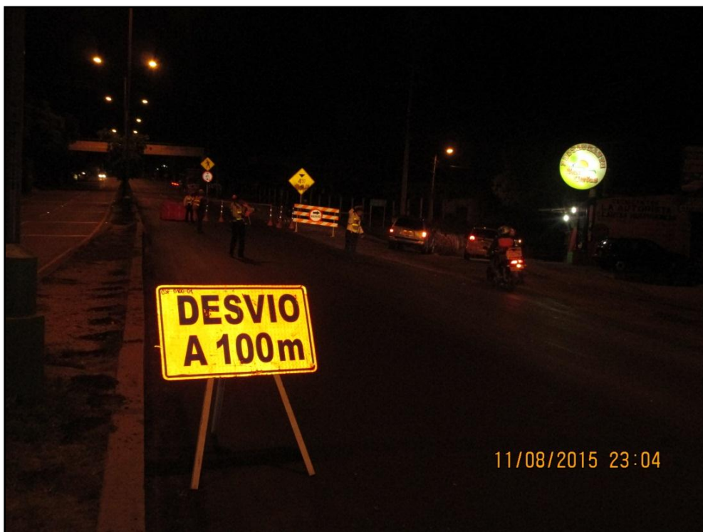
Figura 23. PMT implementado cierre de la autopista desviando por la carretera antigua
