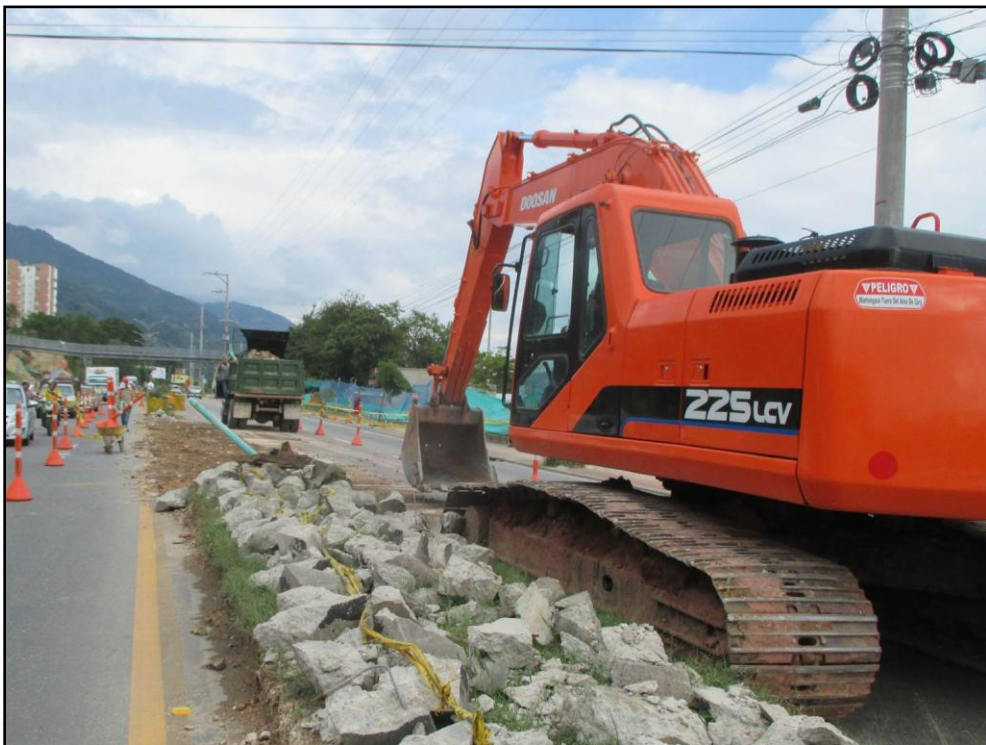
Figura 32. Recolección de escombros del separador central
