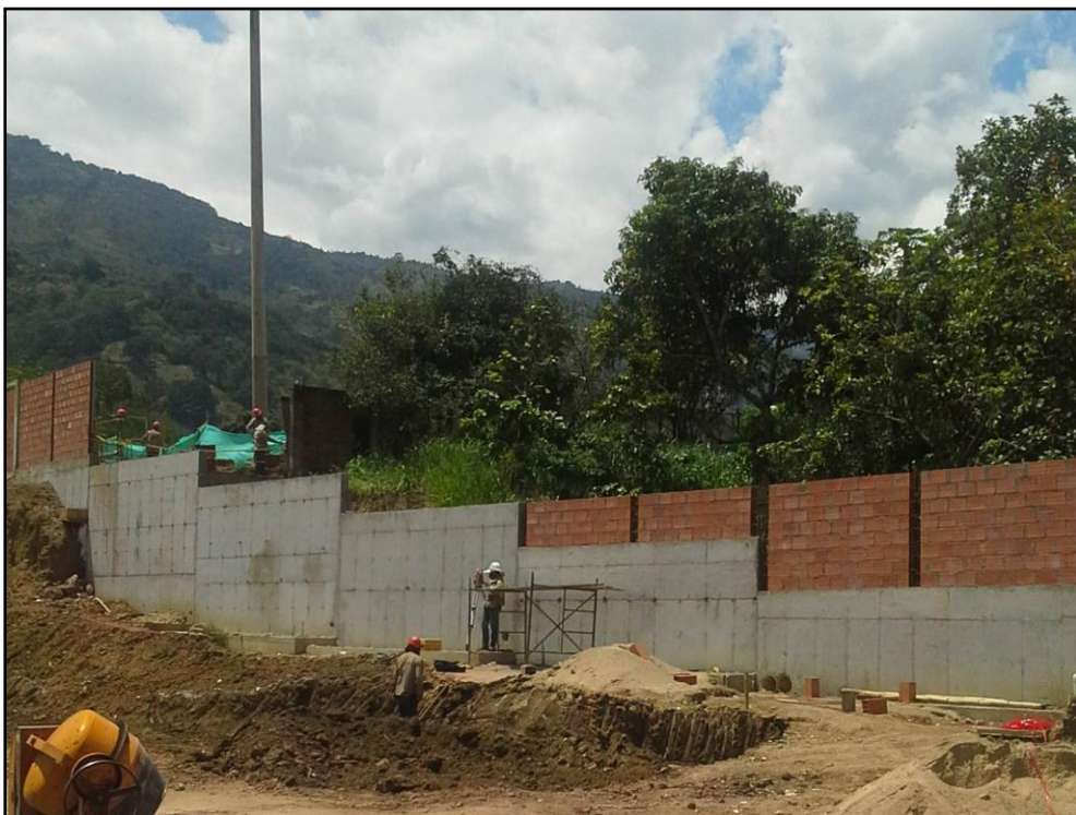
Figura 11. Inicio de mampostería lado norte del coliseo
