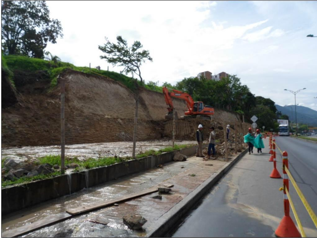
Figura 76. Nivel de corte del talud
