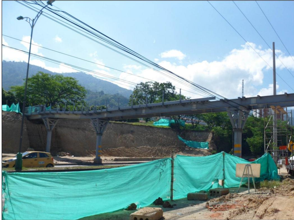
Figura 55. Inicio de instalación de baranda costado oriental
