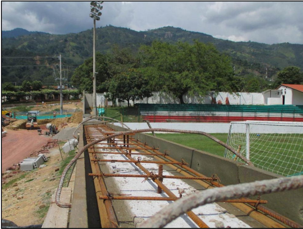
Figura 14. Aceros alfajía muro norte de la cancha
