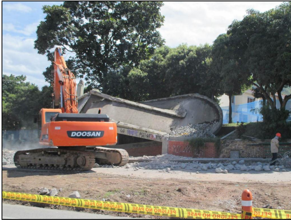
Figura 48. Demolición rampa oriental
