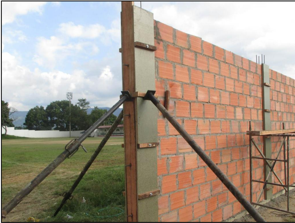
Figura 8. Fundida columnas muro norte de la cancha
