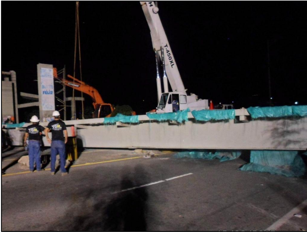
Figura 45. Viga metálica sobre la vía nacional
