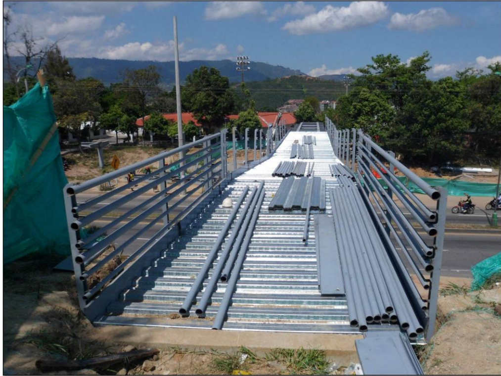
Figura 57. Instalación del metaldeck y baranda
