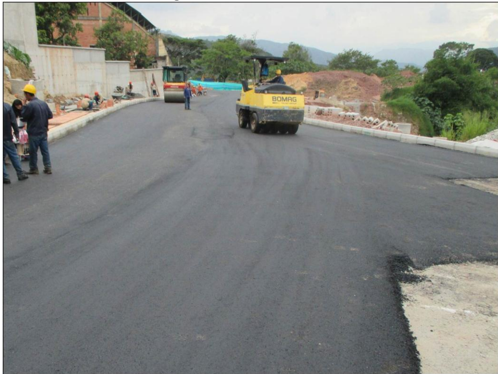
Figura 100. Sellado con llantas
