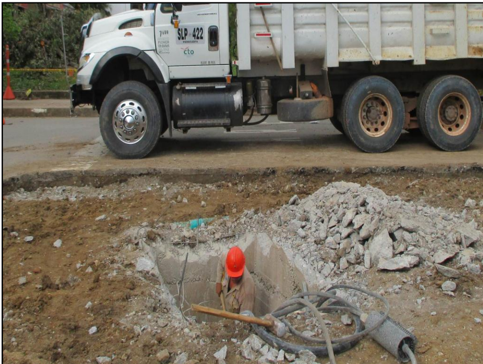
Figura 30. Demolición de la tapa y adecuación de la caja de inspección al diseño geométrico
