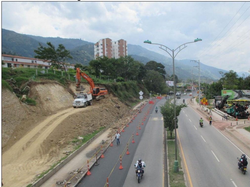
Figura 75. Continuidad corte del talud
