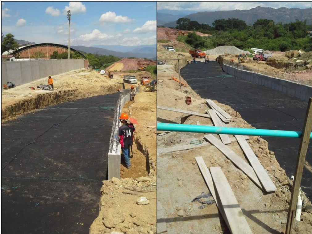
Figura 90. Colchón drenante cocido
