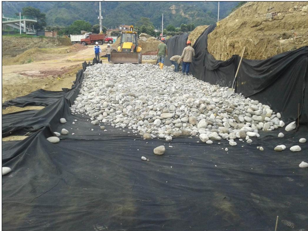
Figura 92. Colchón drenante eje 4
