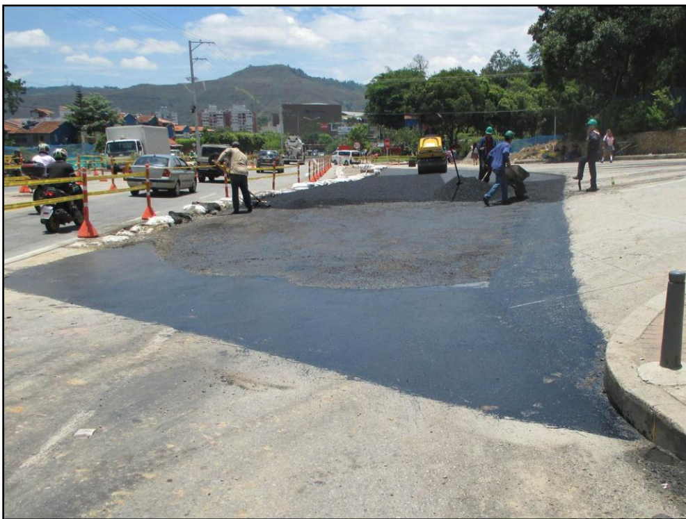
Figura 34. Pavimentación de la variante
