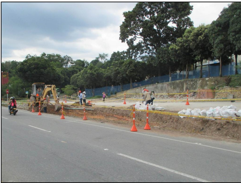
Figura 28. Construcción de la variante
