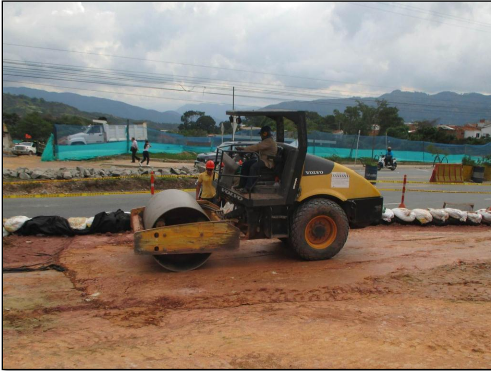
Figura 31. Compactación rasante de la variante
