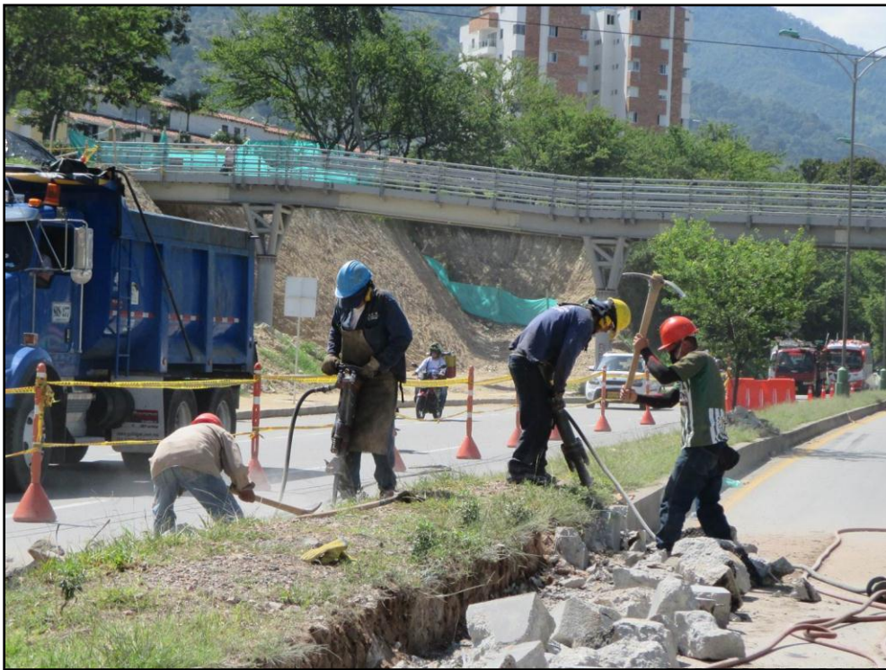
Figura 26. Demolición separador central sur
