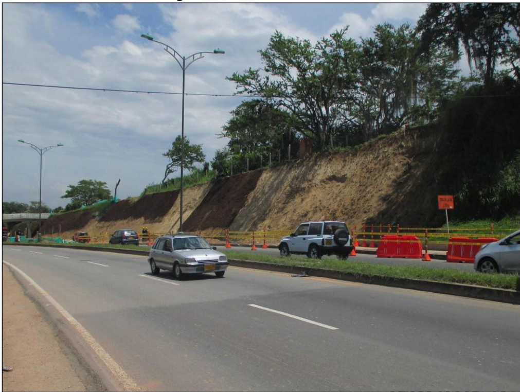
Figura 77. Fin del corte del talud
