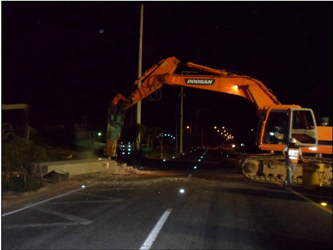
Figura 47. Demolición de columna
