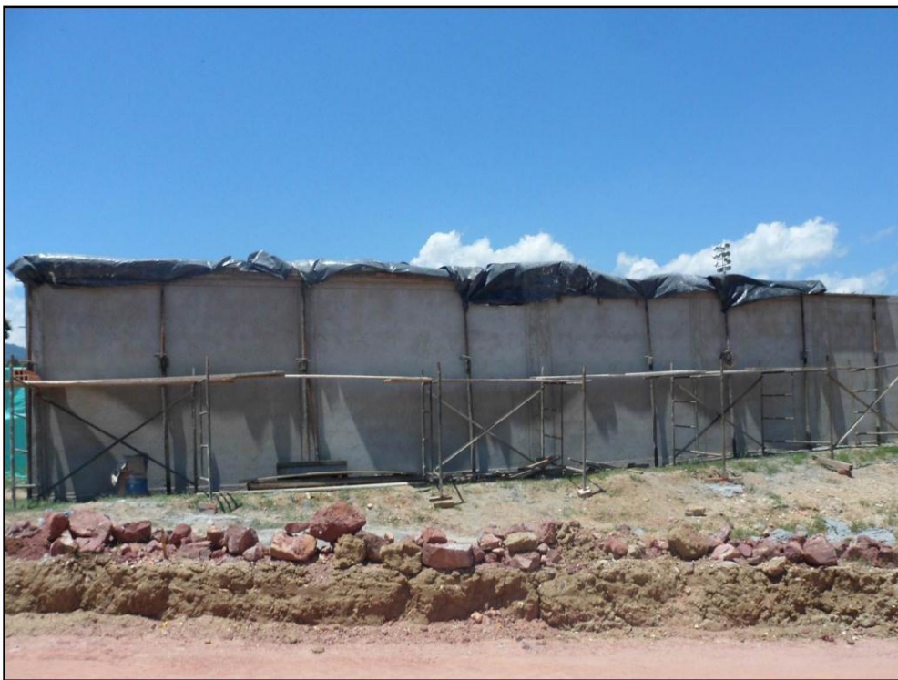
Figura 13. Inicio de alfajía muro norte de la cancha
