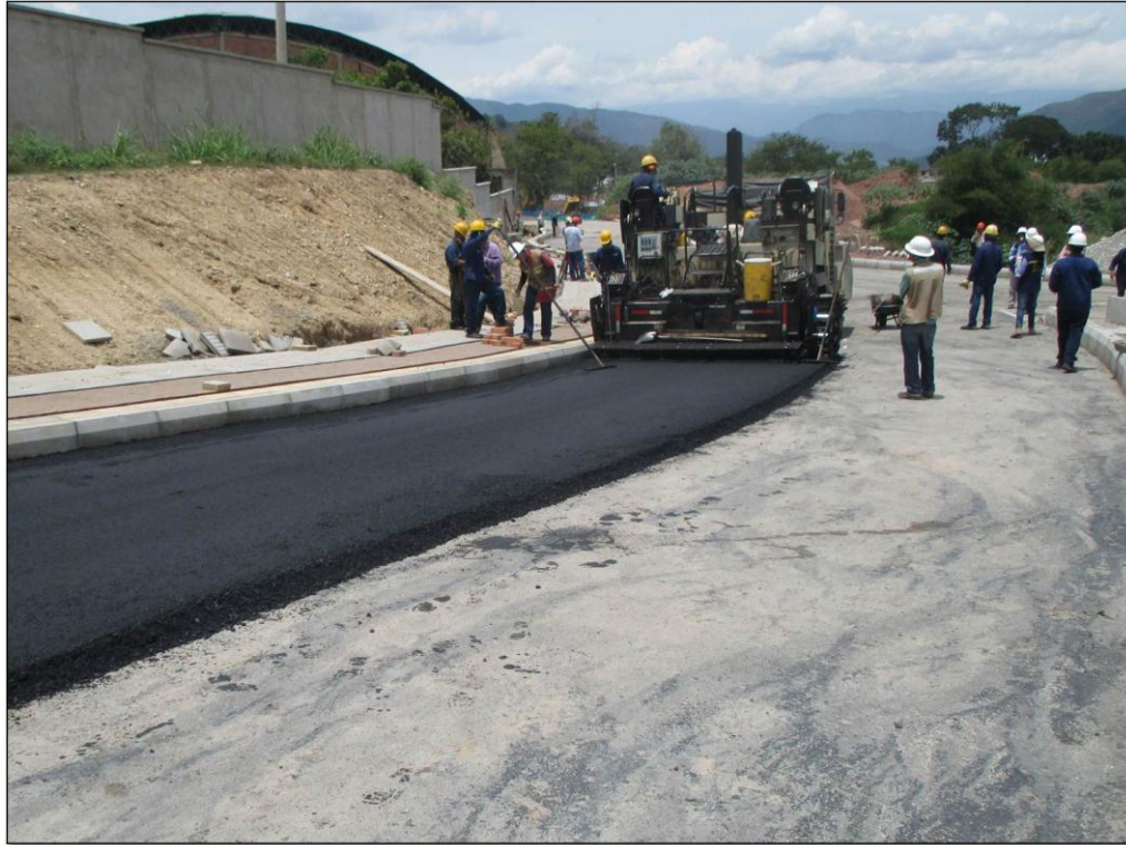
Figura 99. Pavimentación ejes 4 y 9
