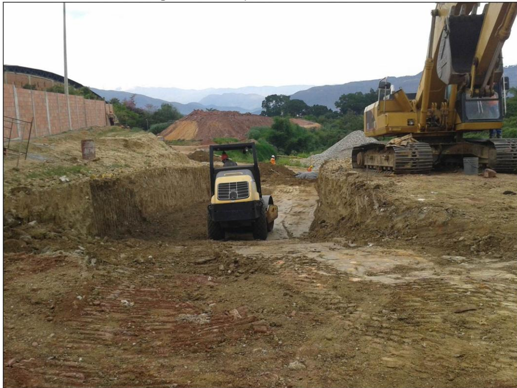
Figura 84. Compactación sub-rasante
