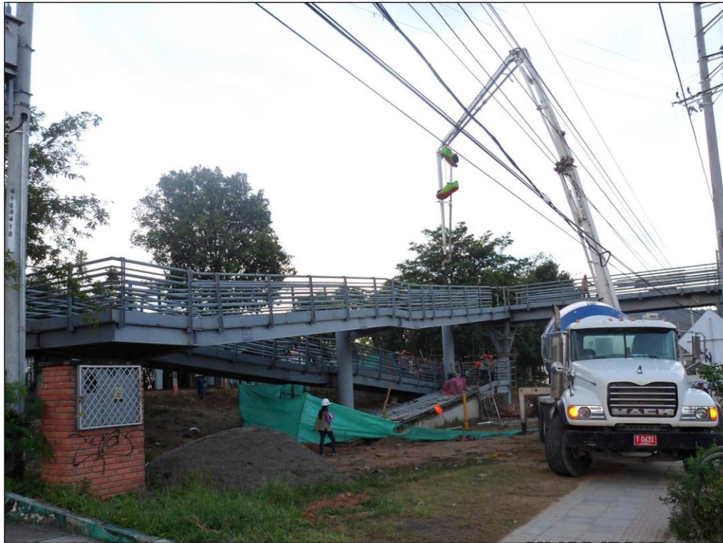
Figura 65. Fundida de rampa
