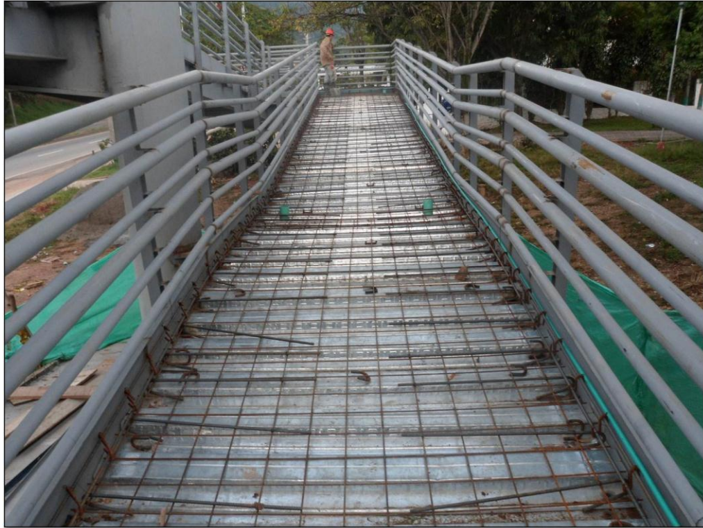
Figura 63. Acero de la rampa
