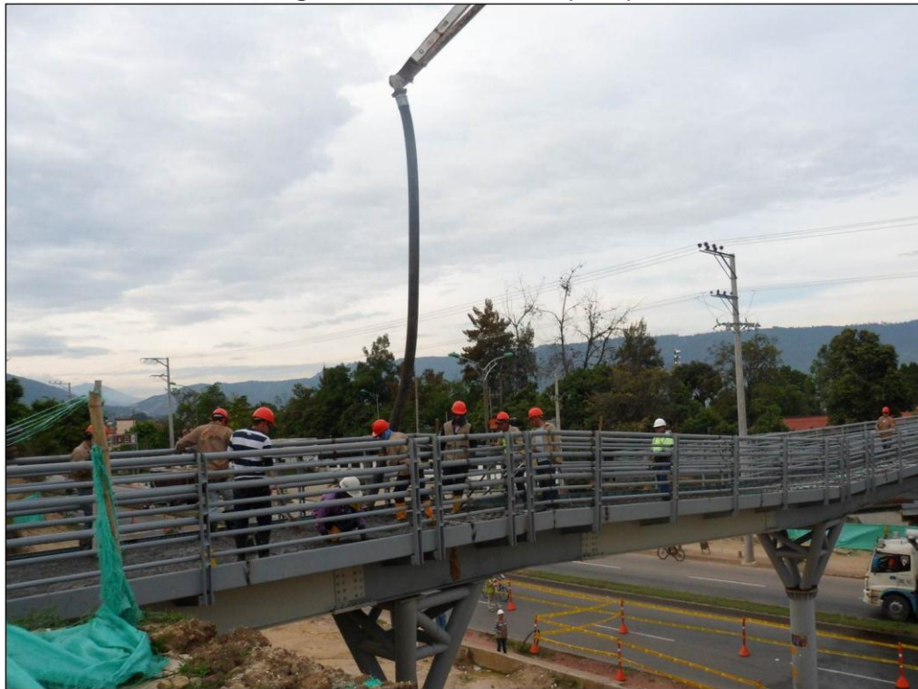
Figura 60. Fundida tablero principal
