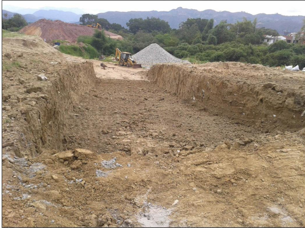
Figura 83. Cajeo de eje 9
