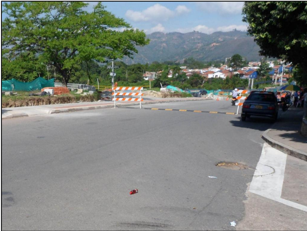
Figura 36. Reductores de velocidad en el acceso oriental del nuevo puente peatonal
