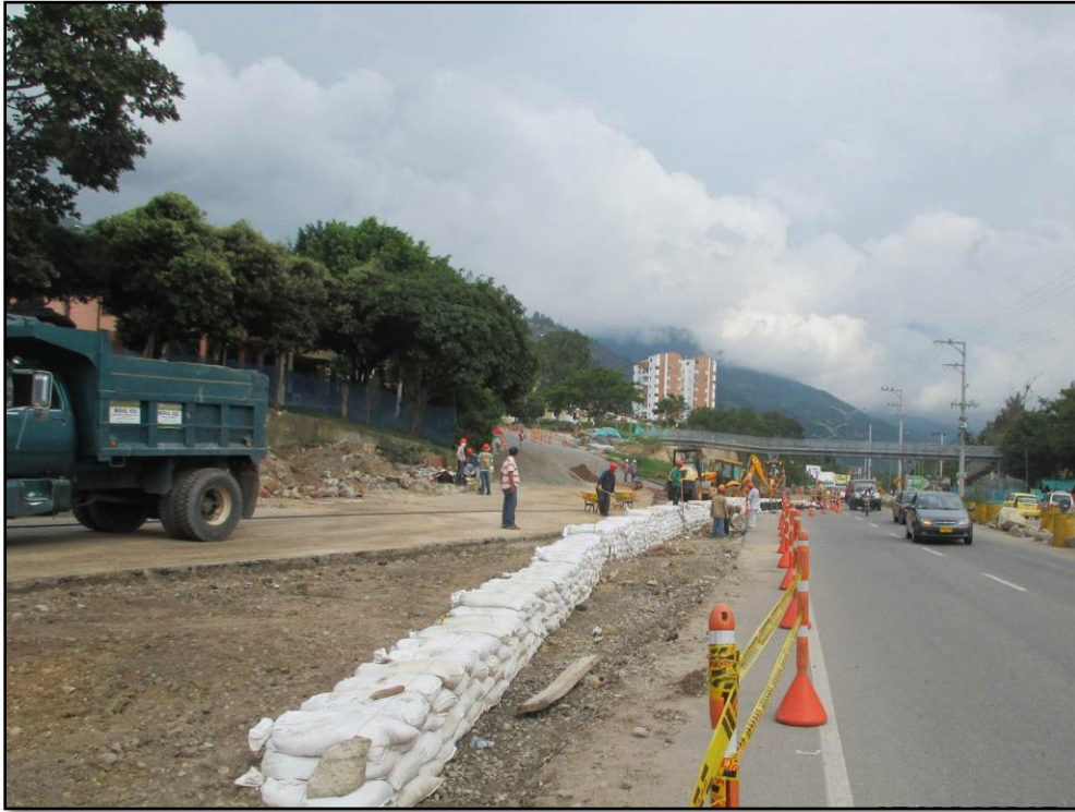
Figura 29. Construcción de muro de contención en sacos con tierra
