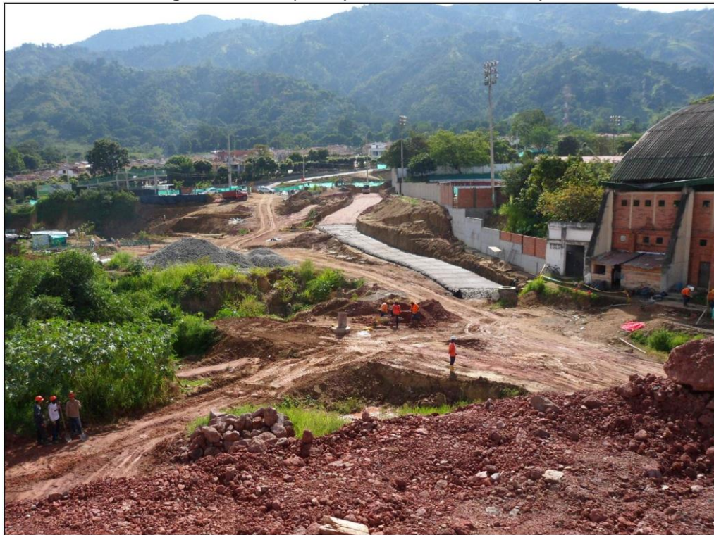
Figura 96. Terraplén eje 9 colchón drenante eje 4
