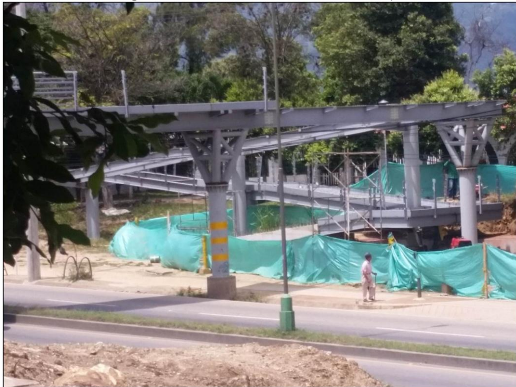
Figura 58. Terminación de estructura de rampa
