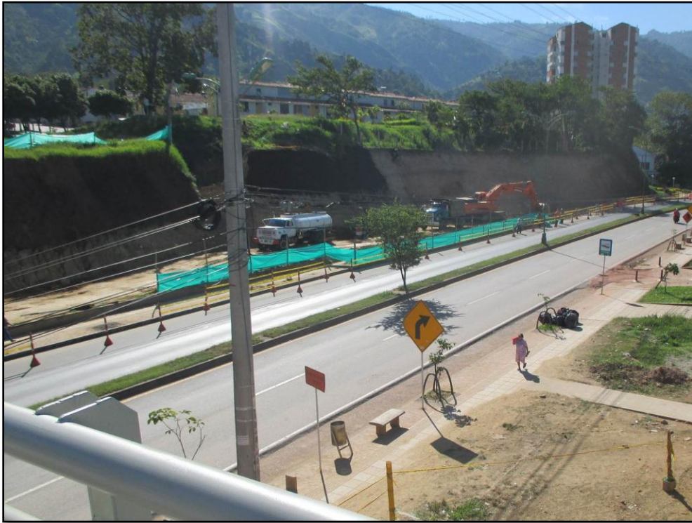
Figura 79. Riego de agua con carro tanque
