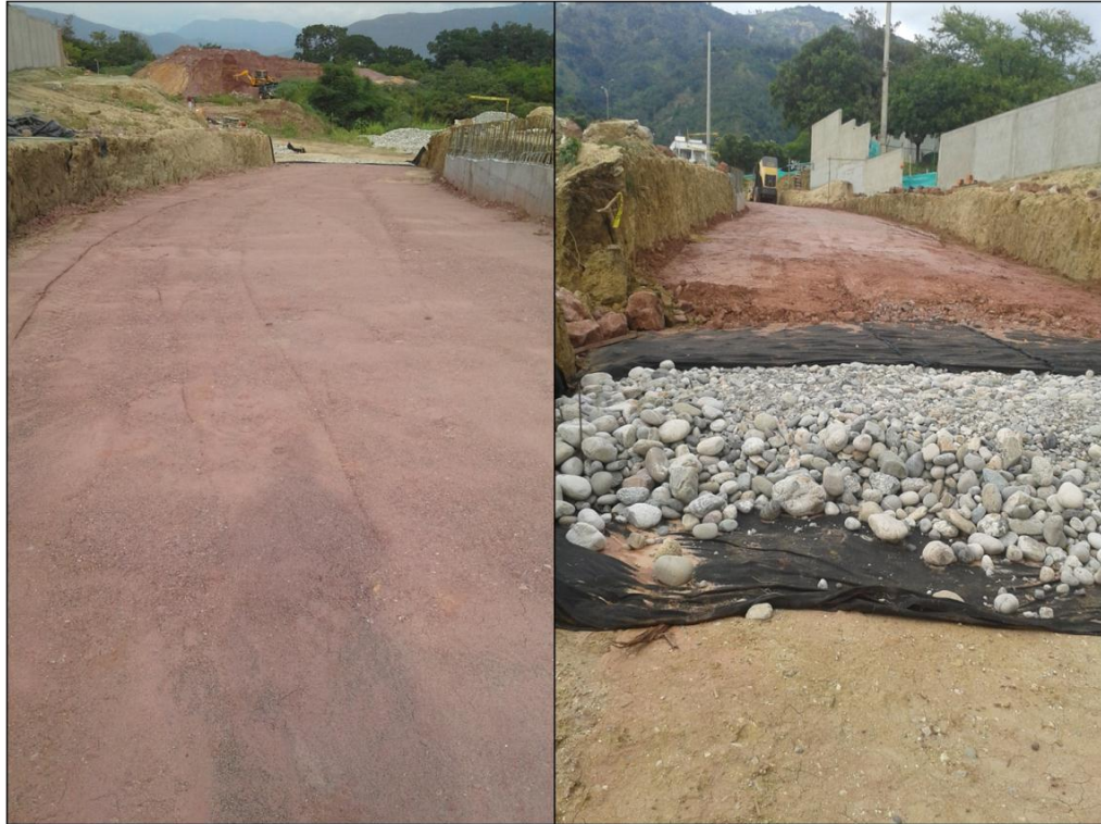
Figura 93. Primera capa de terraplén compactado eje 9
