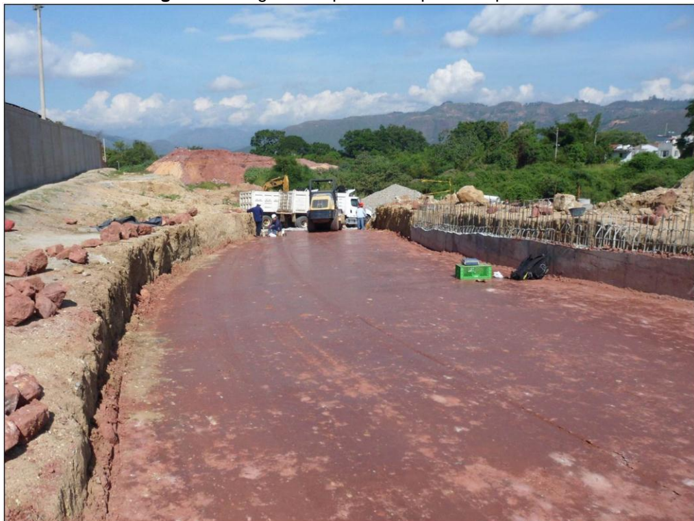
Figura 94. Segunda capa de terraplén compactada
