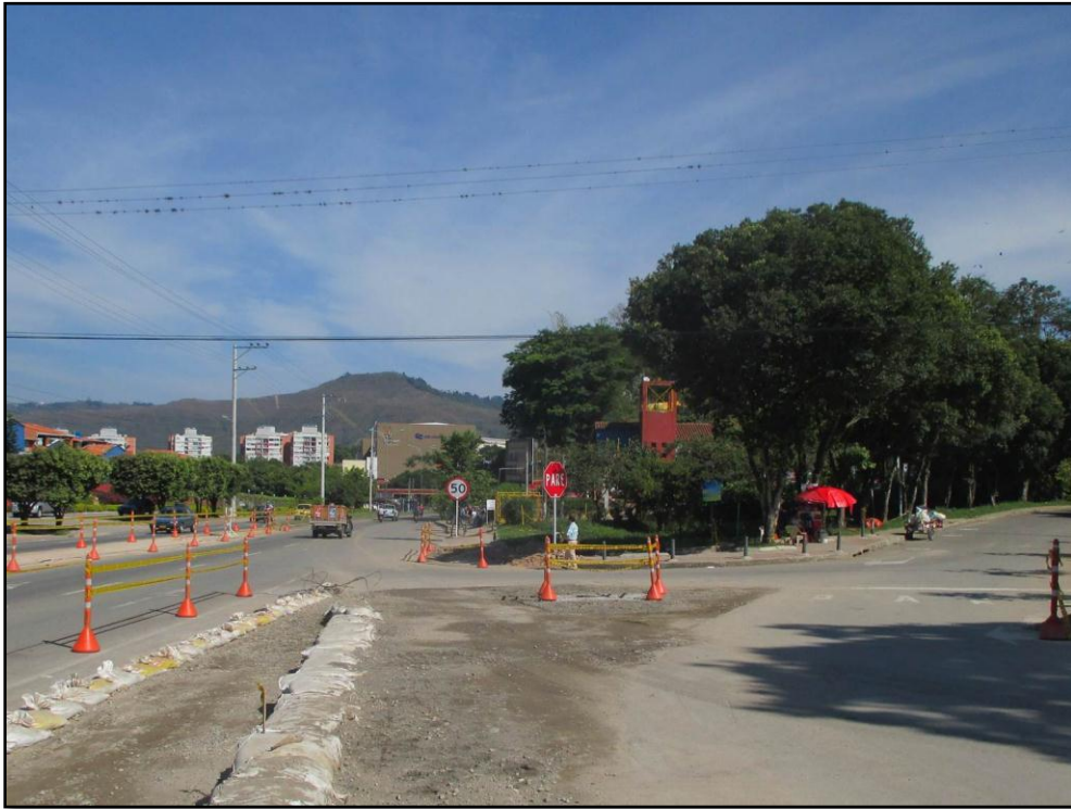
Figura 33. Variante con base granular
