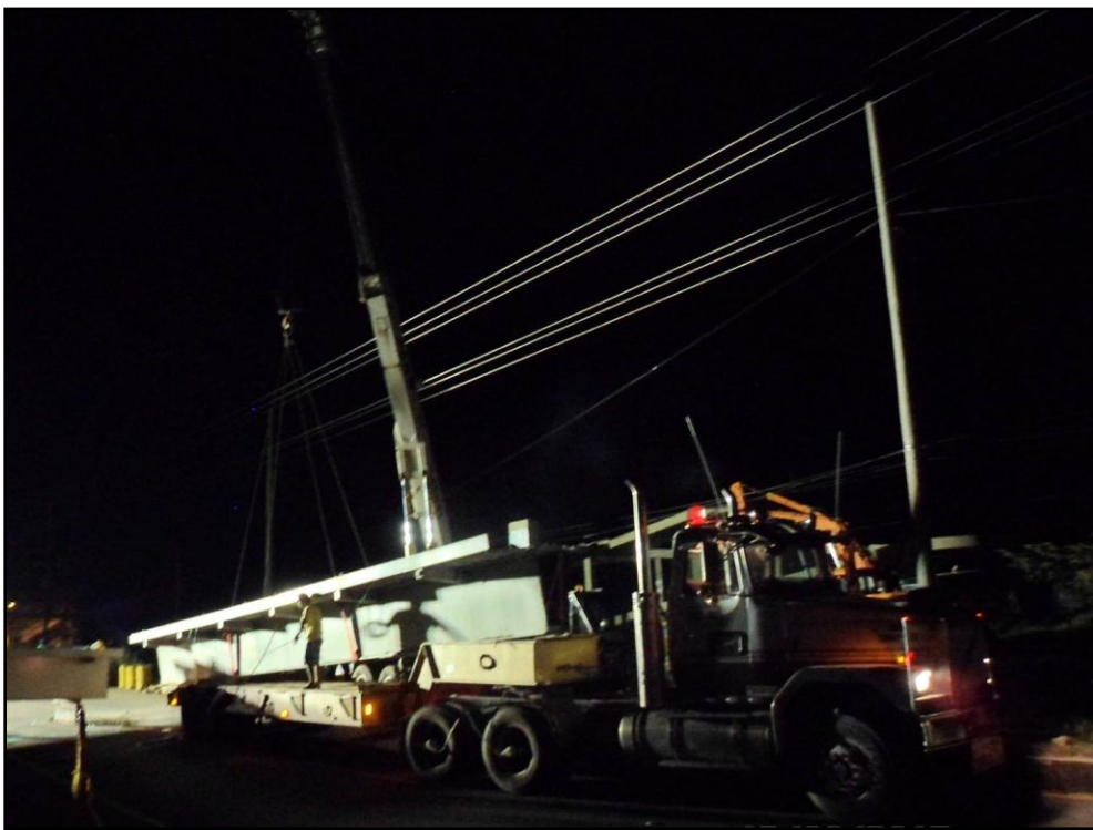
Figura 46. Cargue de viga
