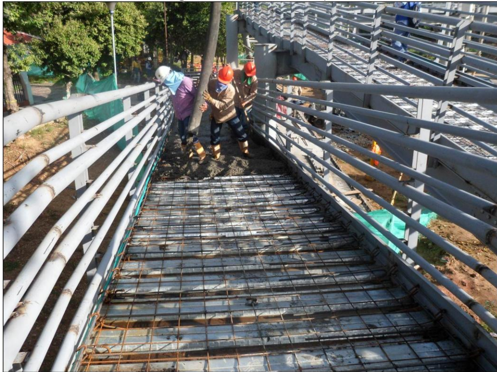
Figura 64. Fundida de rampa
