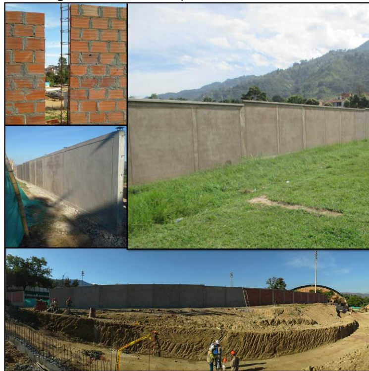
Figura 7. Avance mampostería muro cerramiento
