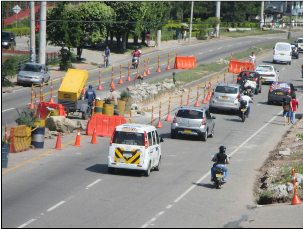
Figura 27. Demolición separador central norte
