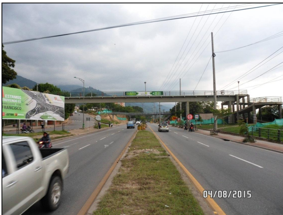
Figura 37. Puente peatonal existente en el Barrio San Francisco de la Cuesta
