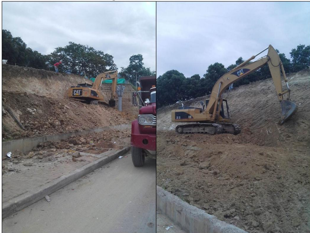
Figura 69. Perfilado del talud
