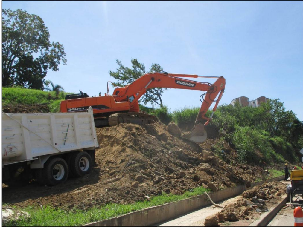
Figura 74. Corte del talud empleando el método de terrazas
