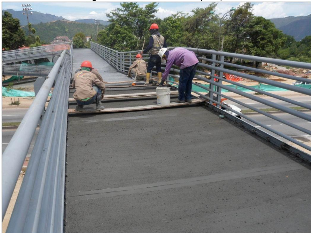
Figura 62. Acabado del tablero principal
