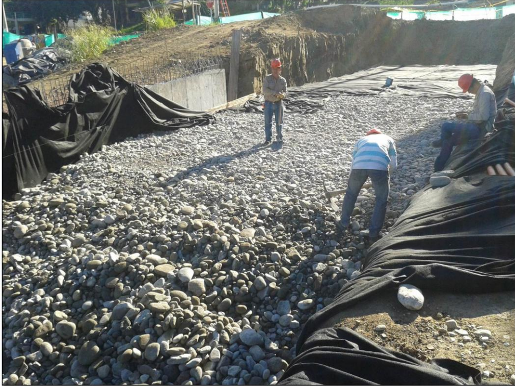
Figura 89. Colchón drenante eje 9
