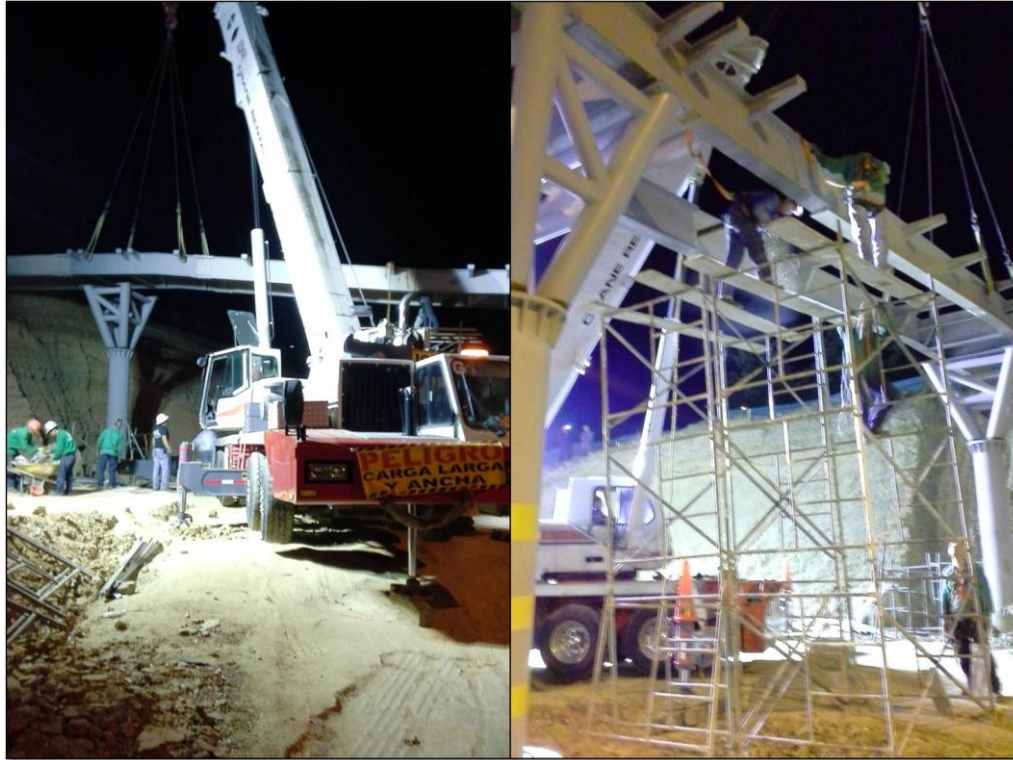
Figura 53. Instalación de la estructura en los apoyos 1', 1 y 2
