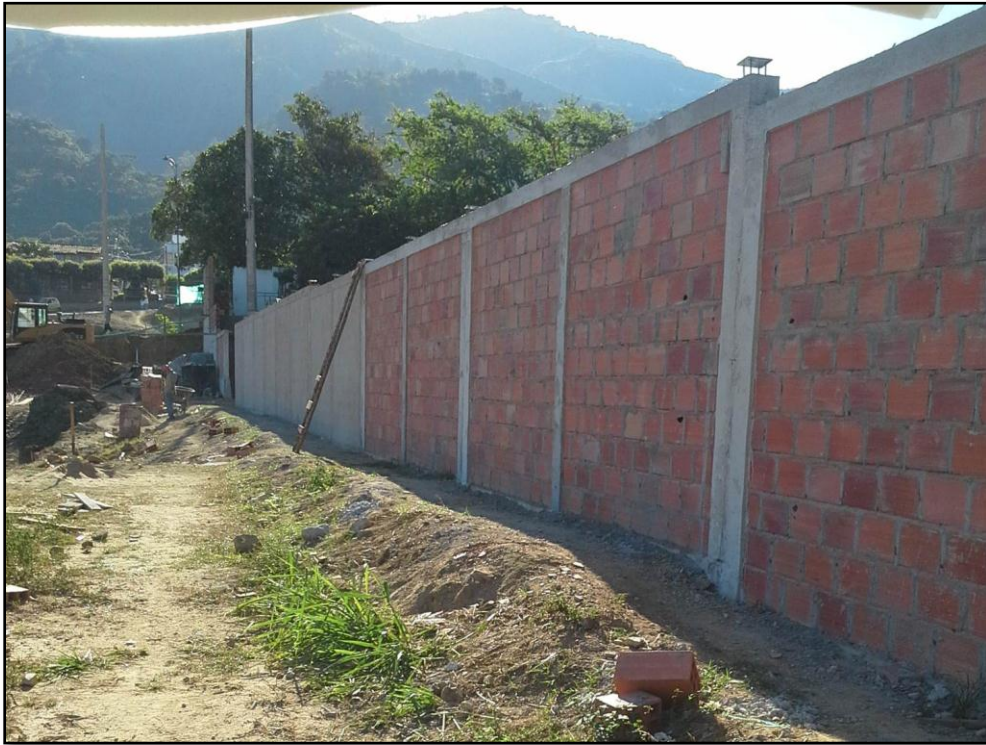
Figura 10. Instalación de friso parte externa muro norte de la cancha
