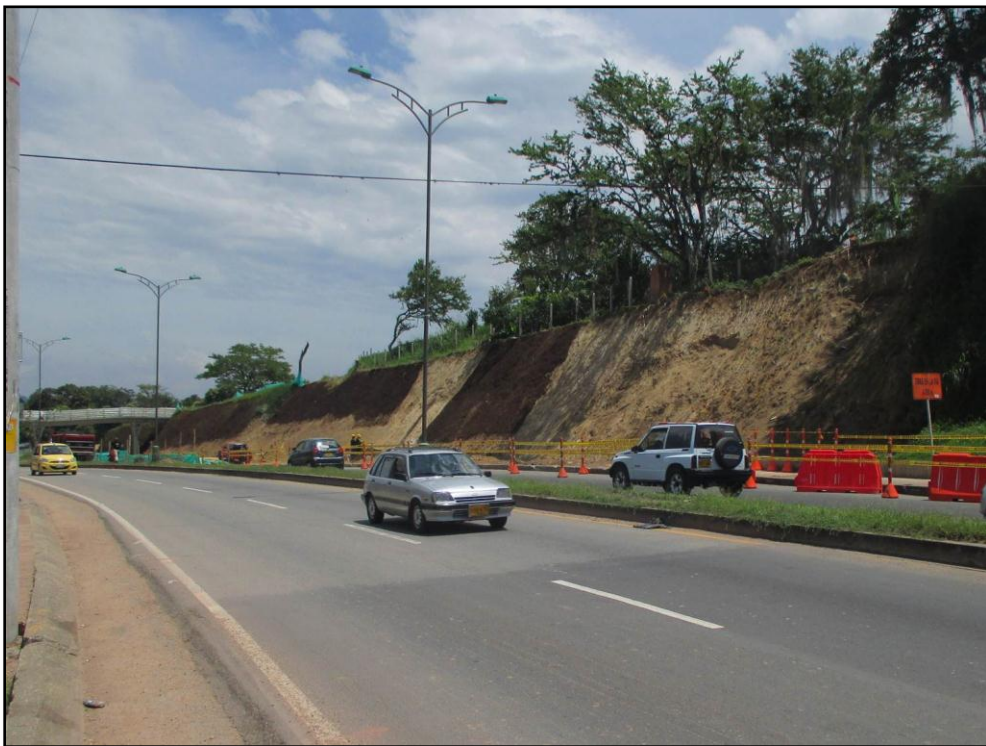
Figura 80. Final corte de talud para continuar la empedradización
