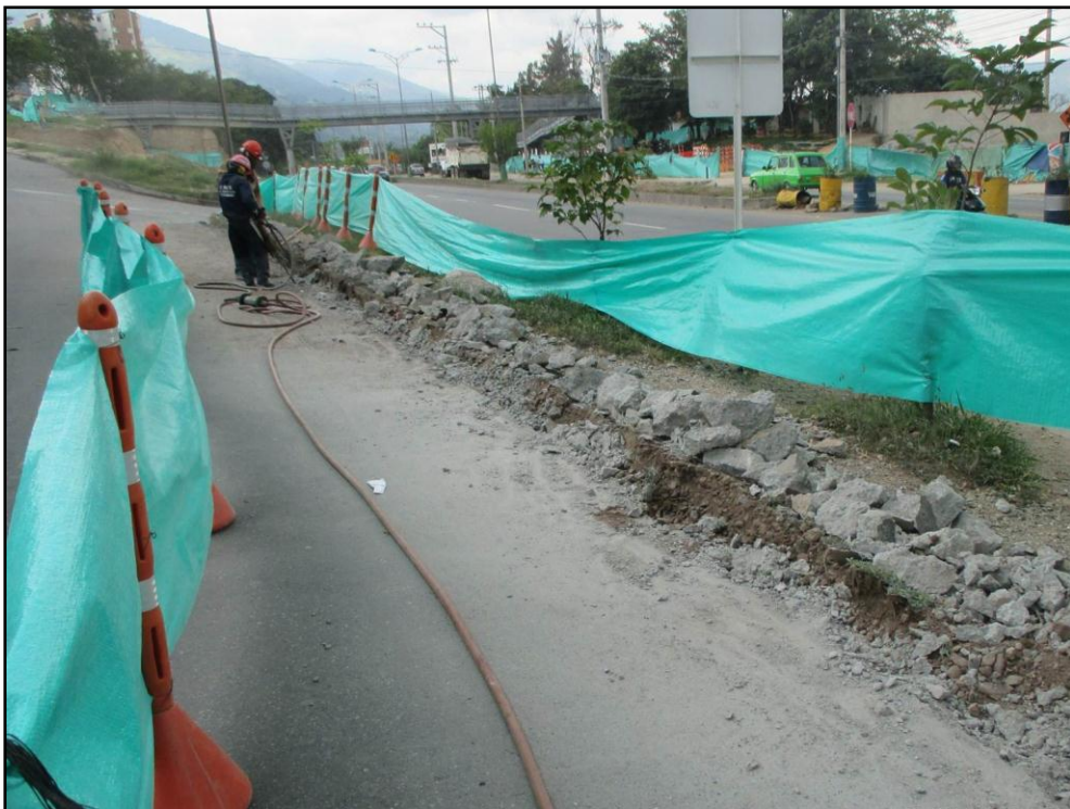
Figura 24. Demolición de bordillo costado oriental
