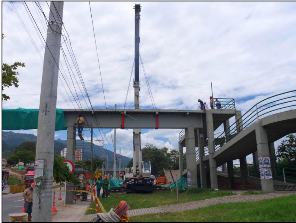
Figura 41. Corte y desmante de la viga
