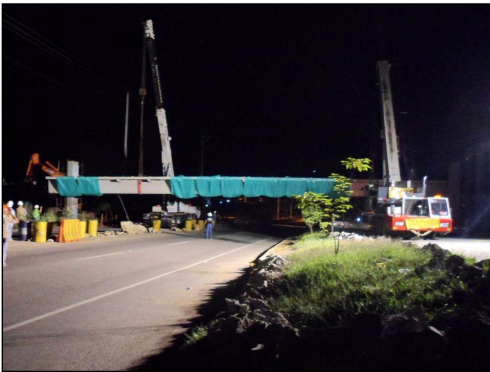
Figura 44. Proceso de desmonte de la viga
