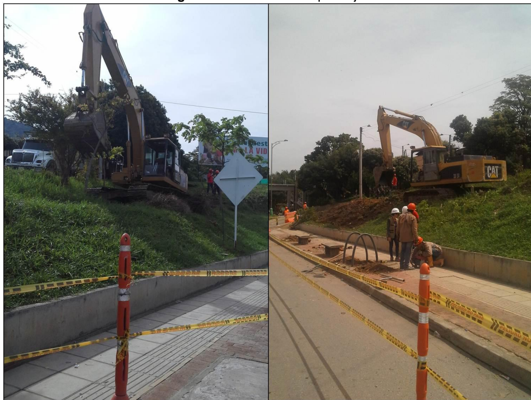
Figura 67. Inicio de descapote eje 1
