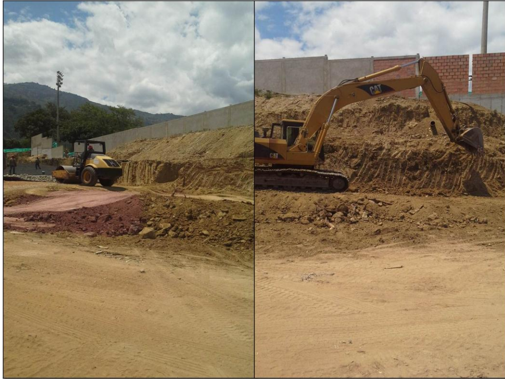
Figura 91. Cajeo y compactación eje 4
