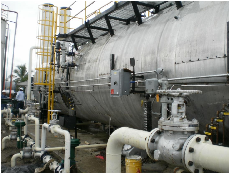
Figura 12. Tratador Electrostático V-702L (Instrumentos).[8]
