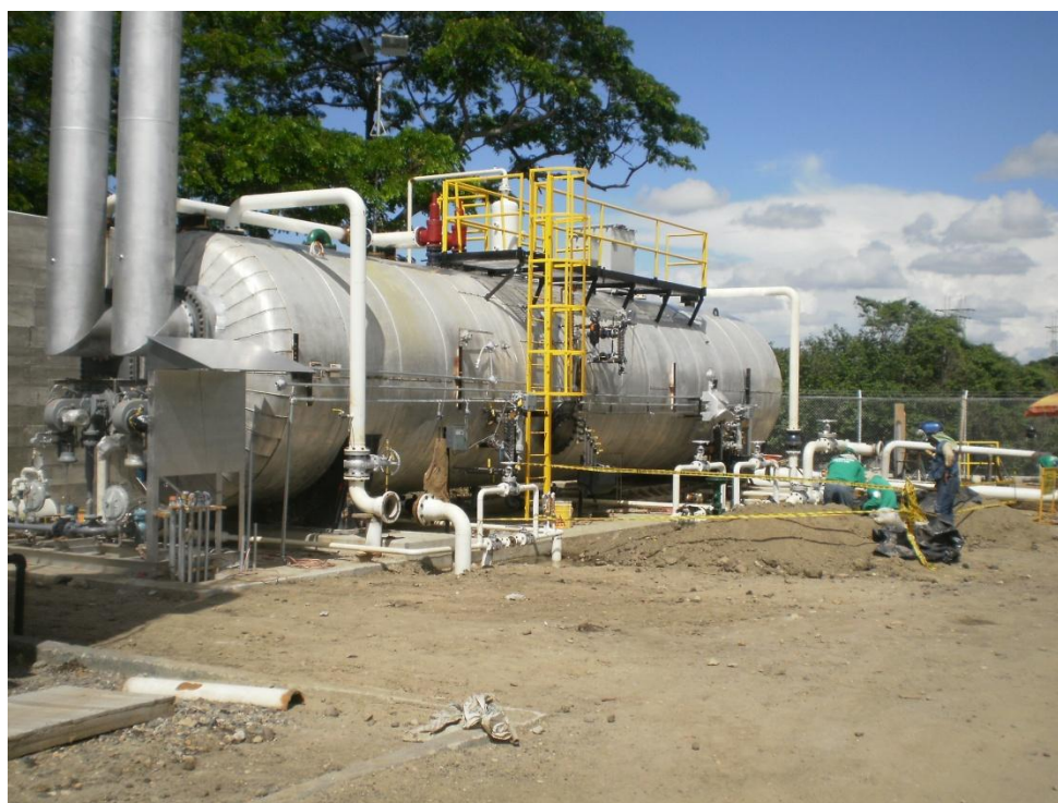
Figura 11. Tratador Electrostático V-702L (Toma General).[8]
