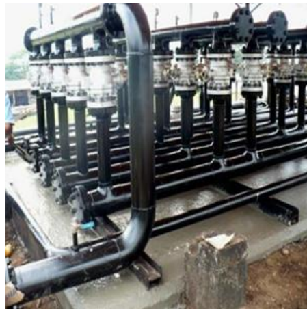
Figura 3. Múltiple de producción de una estación de flujo. [2]
