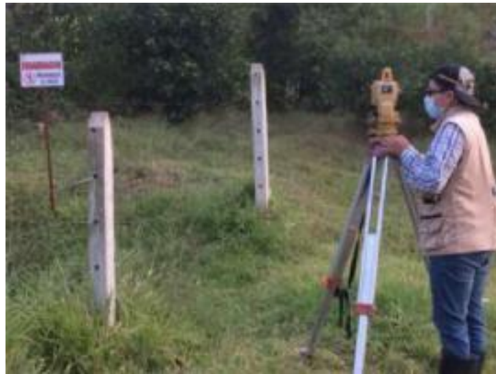
FIG. 53. SUPERVISIÓN TOPÓGRAFÍA PTAR.
