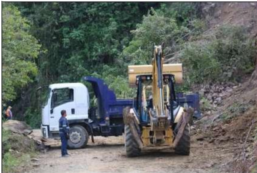
FIG. 40. RETROEXCAVADORA EN ACCIÓN Fuente: Autor
