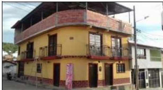
FIG. 64. VISITA VIVIENDA BIFAMILIAR
