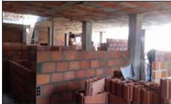
FIG. 66. VISITA VIVIENDA MULTIFAMILIAR
