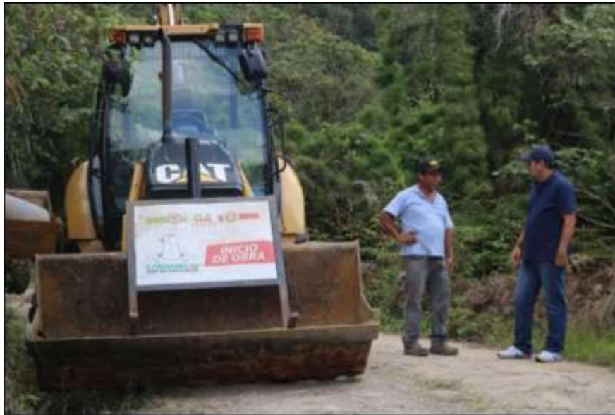
FIG. 38. INICIO DE OBRA MANTENIMIENTO DE VÍAS Terciarias
