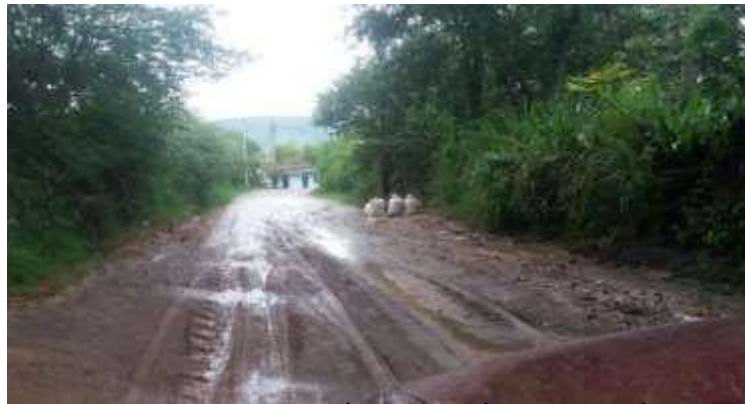
FIG. 57. VISITA VÍA CURITÍ- EL COMÚN
