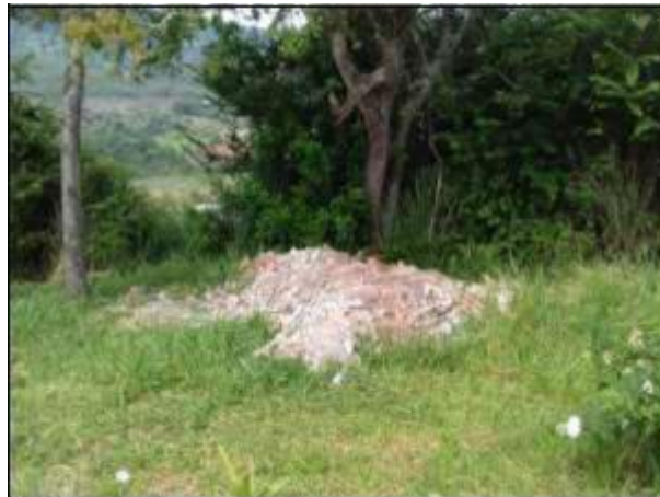
FIG. 28. MATERIAL PROVENIENTE DE DEMOLICIÓN
