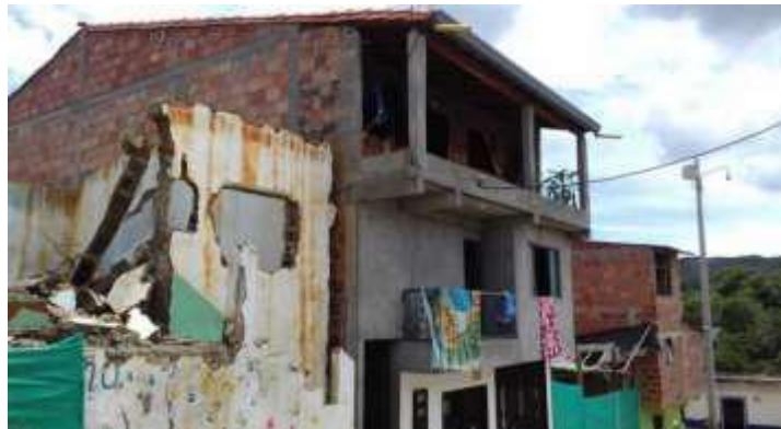
Fig. 69. VISITA OBRA NO LEGALIZADA Fuente: Autor
