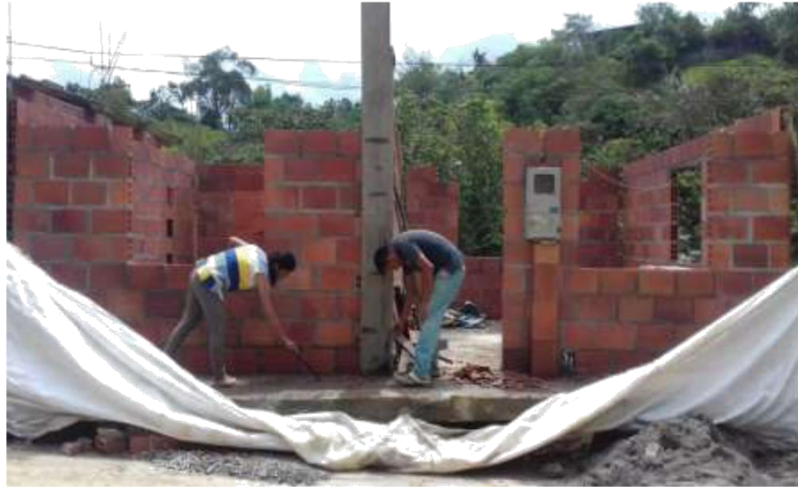
FIG. 68. VISITA OBRA NO LEGALIZADA Fuente: Autor
