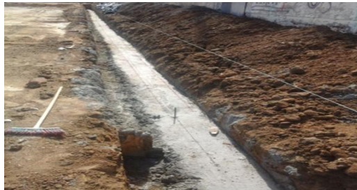
Imagen 14. Muro confinado bajo la mampostería a la vista
