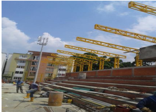
Imagen 23. Correas metálicas
