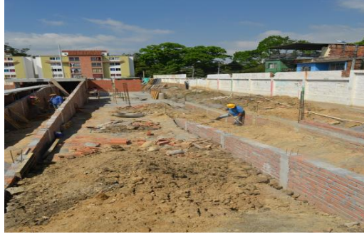
Imagen 10. Instalación de vigueterías para accesorios
