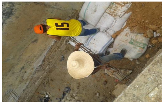
Imagen 16. Refuerzo de muro recomendado por Ing. estructural
