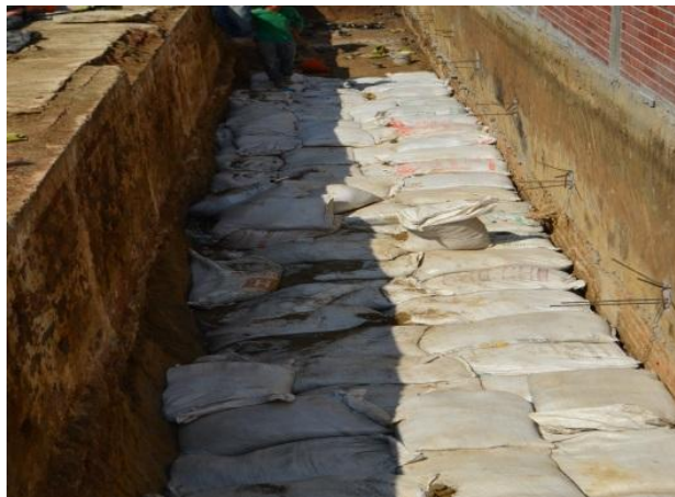
Imagen 36. Muerto en saco de suelo cemento relación 1:6
