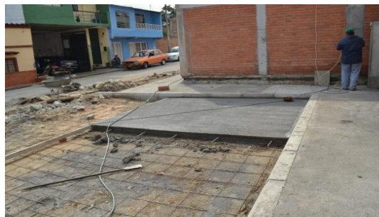
Imagen 12. Concreto hidráulico para parqueaderos
