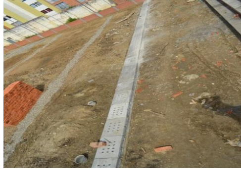
Imagen 30. Canaleta lateral de drenaje en la cancha
