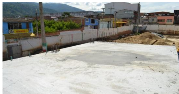
Imagen 17. Placa aligerada en concreto
