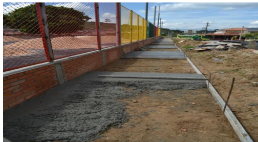
Imagen 12. Concreto hidráulico para parqueaderos
