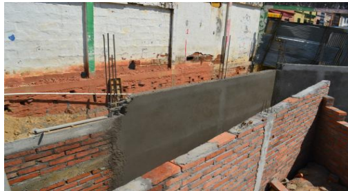
Imagen 14. Muro confinado bajo la mampostería a la vista
