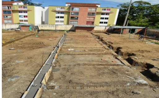
Imagen 7. Fundación de graderías en concreto
