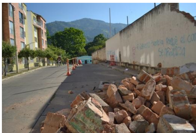
Imagen 3. Demolición de muro en mampostería
