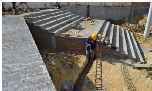
Imagen 11. Endurecimiento en concreto de 3000 psi
