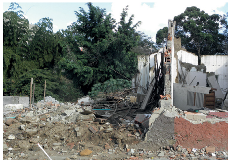
Foto 74. Demoliciones para la construcción del Parque Bicentenario
