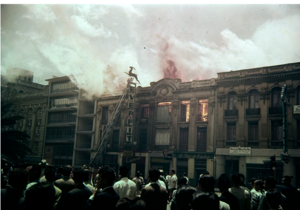
Foto 24. Incendio del edificio Gutiérrez
