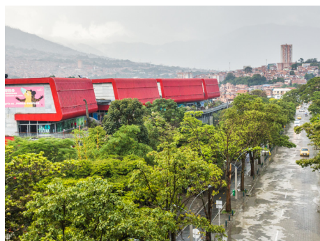
Foto 48. Intervenciones al norte del núcleo de la ciudad
