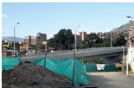
Foto 75. Construcción de puente sobre la quebrada Santa Elena (Parque Bicentenario) para dar continuidad a la circunvalar
