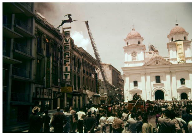
Foto 25. Incendio del edificio Gutiérrez (2)
