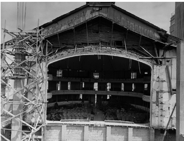
Foto 22. Demolición del teatro Bolívar
