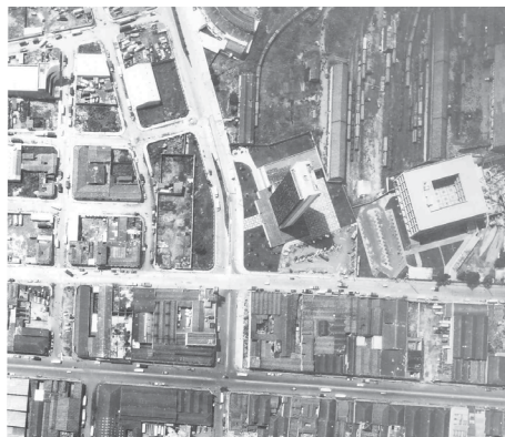
Foto 30. Edificios administrativos en antiguo sector de ferrocarriles, 1975
