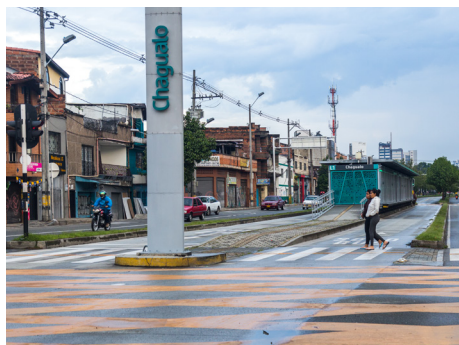
Foto 43. Calzada en construcción del Metroplús por el barrio El Chagualo
