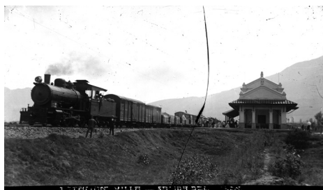
Foto 79. Antigua Estación Villa del sistema ferroviario
