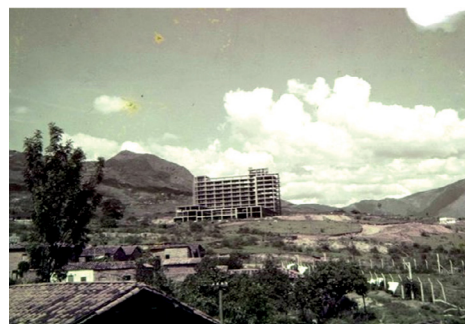
Foto 17. Construcción del Hospital Pablo Tobón Uribe
