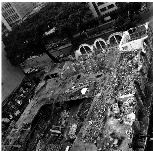
Foto 23. Demolición del Teatro Junín y Hotel Europa
