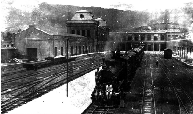
Foto 7. Estación Ferrocarril de Antioquia. Sector de Guayaquil
