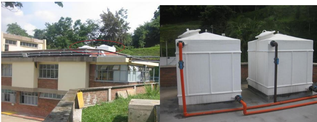
Ilustración 6. Tanques aforadores
