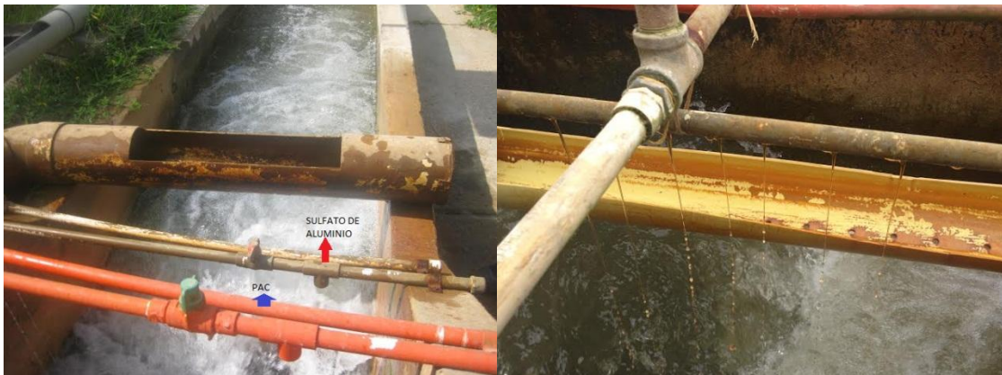
Ilustración 8. Flautas de aplicación del coagulante
