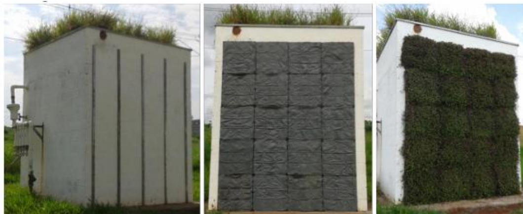
Figura 7 -Esquema experimental del comportamiento acústico de fachadas verdes. Azkorra et al. (2015)
