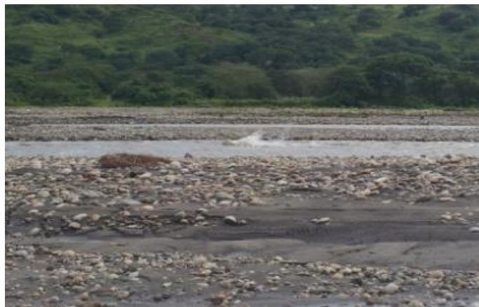
Fig. 63 Afloramiento del gasoducto y fuga en el río Cravo sur 2014
