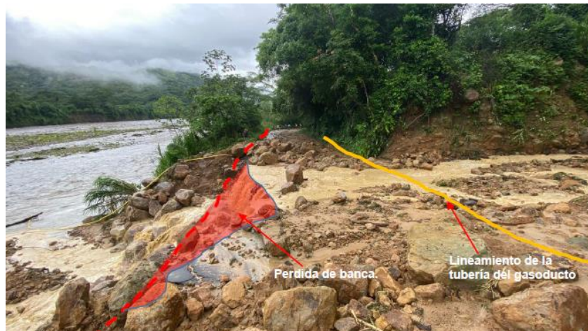
Fig. 17 Remoción en masa sobre el DDV
