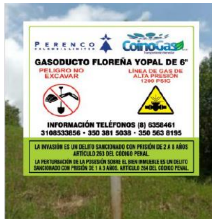
Fig. 58 Señalización sobre el paso del gasoducto
