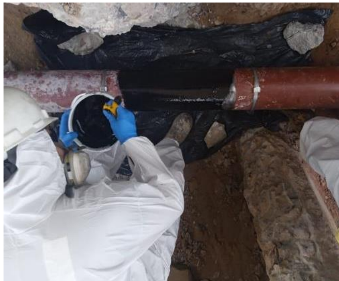
Fig. 42 Reparación corrosión PK 5+311
