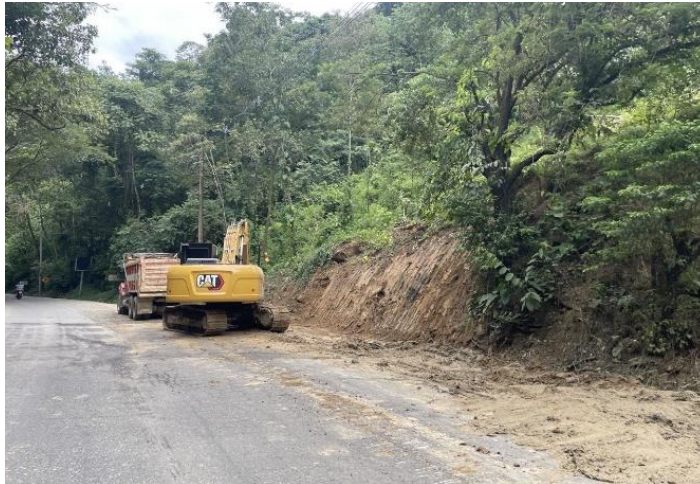
Fig. 18 Personal de invias limpieza de cunetas, 19 de julio 2024 PK 11+400
