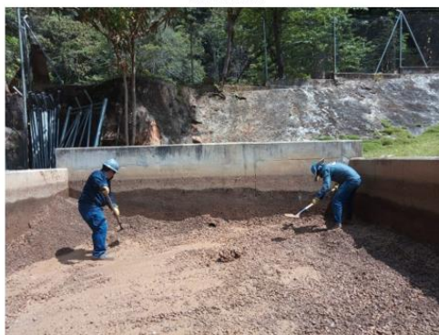
Fotografía 1. Retiro de material por técnica manual de la futura zona de floculación
