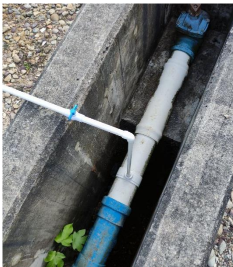
Imagen 3. Instalación inyección de floculante por medio de collarín
