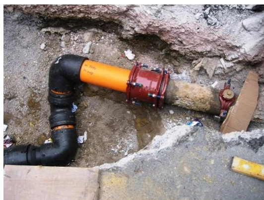
Ilustración 6. Unión brida universal
