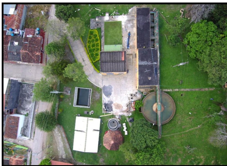
Imagen 2. Fotografía aérea vista en planta de PTAP Convencional
