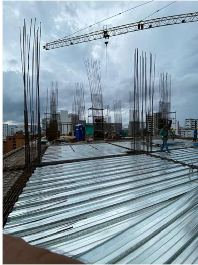
Figura 19 – Placa piso 10 Fuente: Propia
