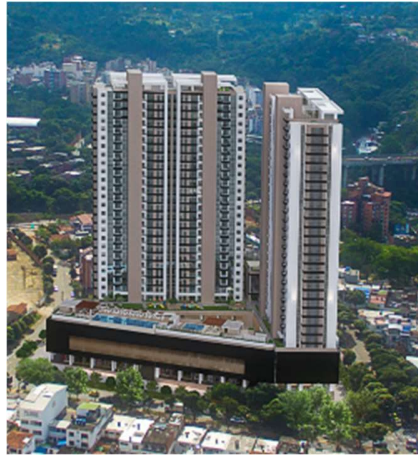
Figura 4 – Vista general torre 1 y 2 Fuente: Marval S.A
