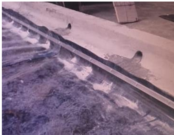
Figura 39. Platinas de seguridad para que no pase el agua.
