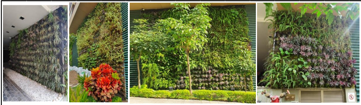
Figura 25. Muro edificación - La Foret
