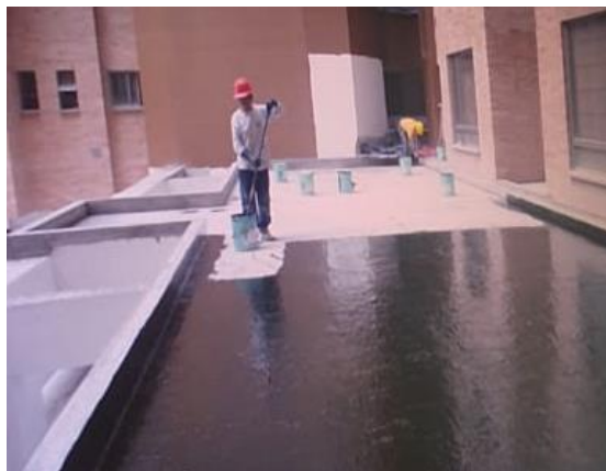
Figura 37. Muro de Impermeabilizante.
