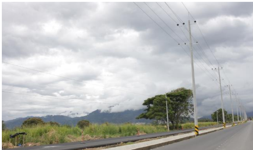
Ilustración 56: Sector Aeropuerto Fuente: Enertolima
