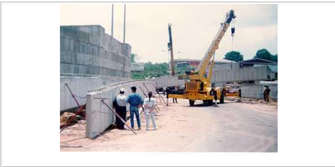
Figura 145. Izaje de vigas prefabricadas del Intercambiador Aranzoque
