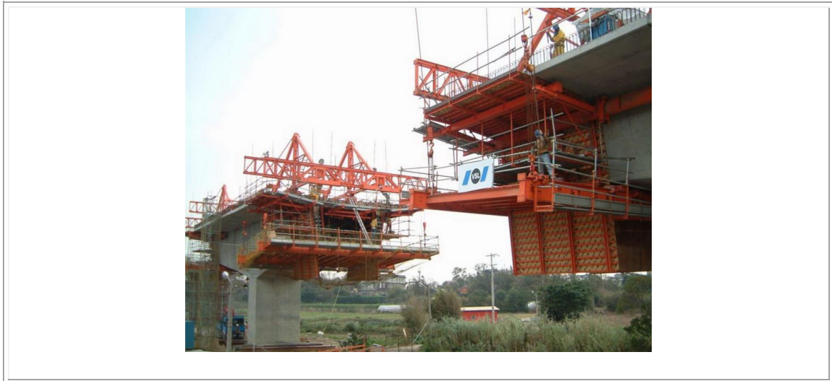
Figura 149. Puente por voladizos sucesivos fundido en sitio
