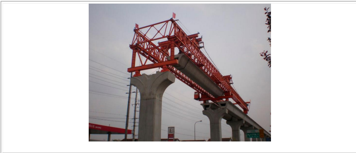
Figura 146. Montaje mediante viga de lanzamiento.
