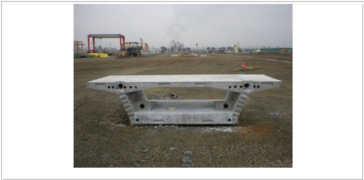
Figura 150. Dovela de junta seca
