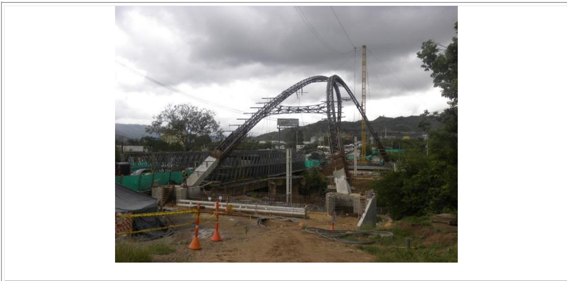
Figura 157. Construcción del puente de Flandes –Girón (Santander)
