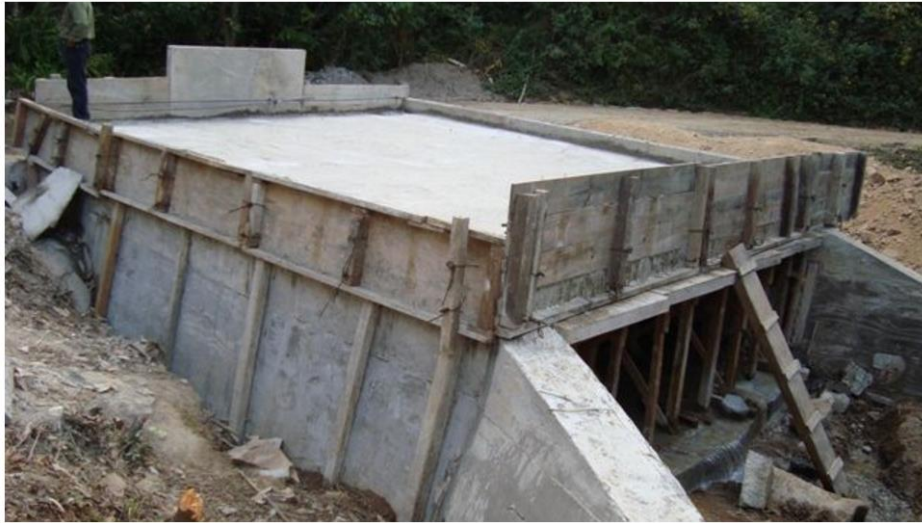
Figura 143. Puente de losa fundido sobre cimbra
