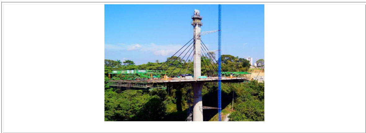
Figura 159. Construcción viaducto la novena en Bucaramanga
