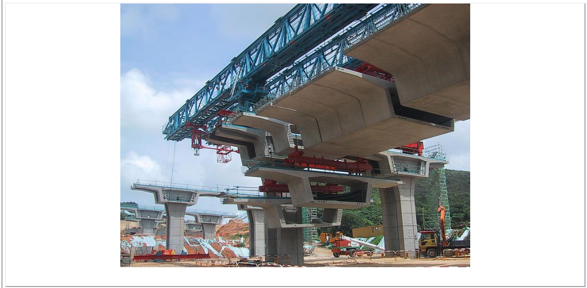
Figura 151. Montaje de dovelas secas luz por luz
