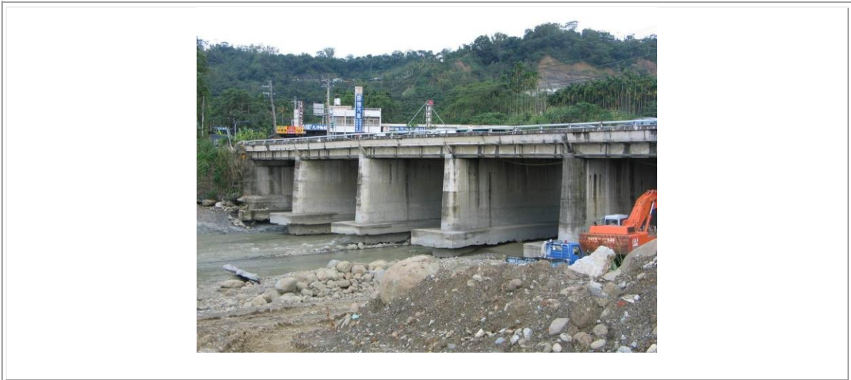
Figura 20. Pila Tipo Muro
