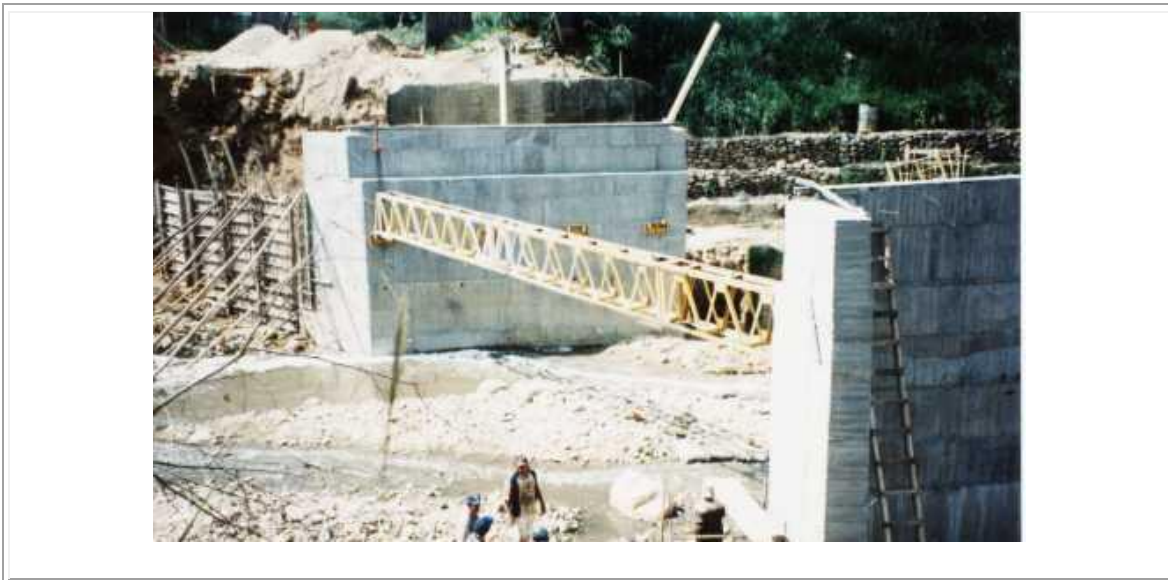
Figura 144. Montaje de vigas metálicas de cimbra para apoyo de la viga.
