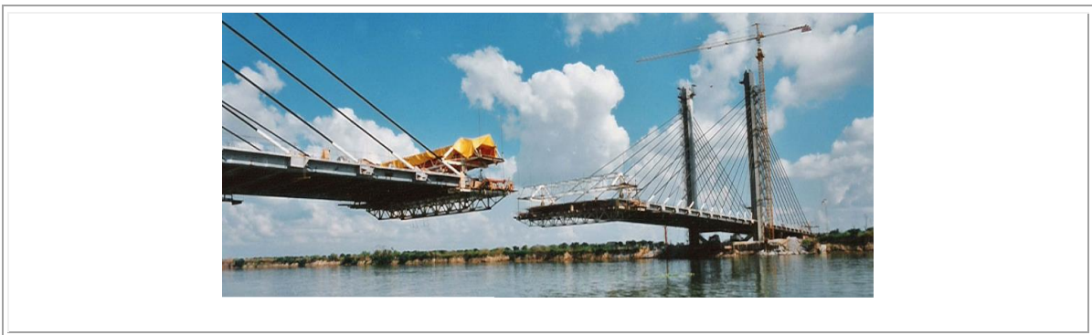
Figura 158. Construcción puente atirantado con dovela metálicas
