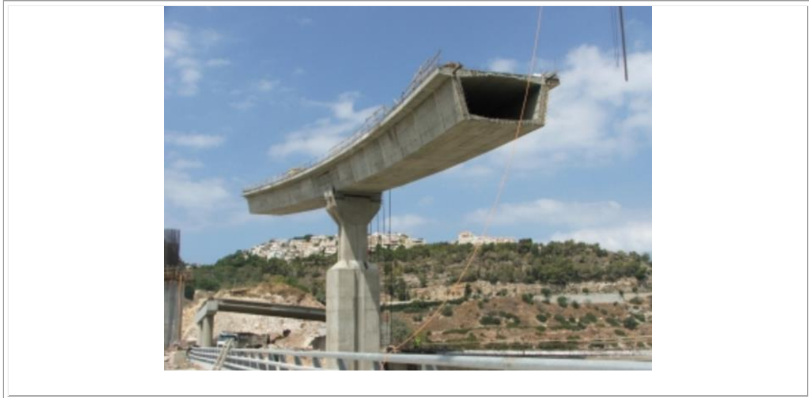
Figura 152. Montaje de dovelas secas, por avance segmental.
