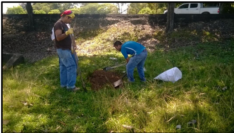
Fotografía No 6 Apiques paralelos a la vía existente
