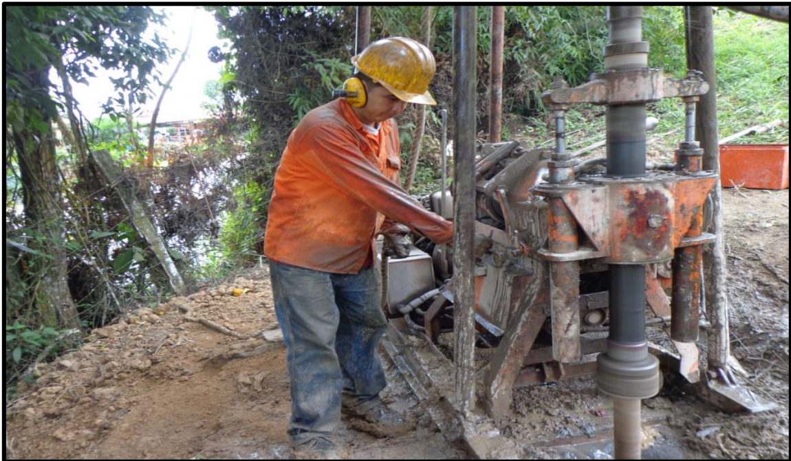
Fotografía No 3 Sondeos mecánicos en Lisboa.
