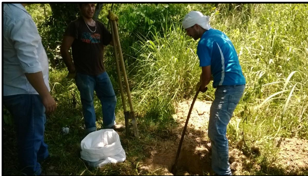
Fotografía No 7 Apiques paralelos a la vía existente
