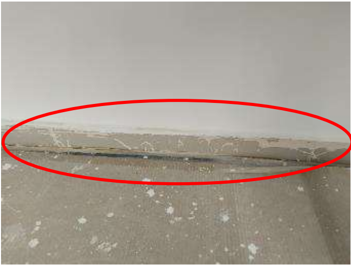
Limpiar pintura del guardaescoba.
