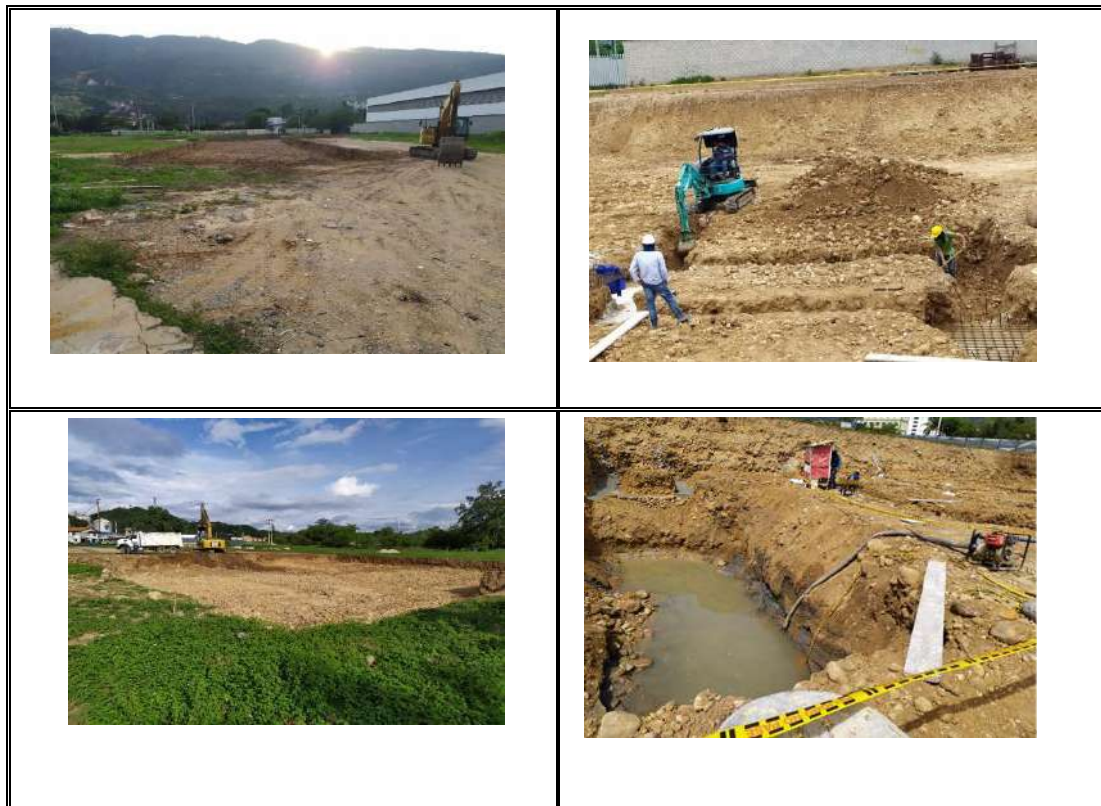
Figura 13. Supervisión de obra excavación a máquina
