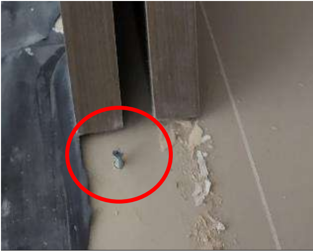
Detalle puerta closet principal.
