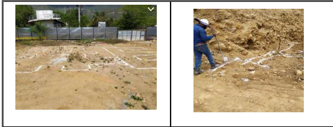
Figura 12. Supervisión de obra localización y replanteo
