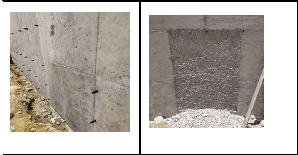
Figura 15. Supervisión concreto columnas y muros de contención
