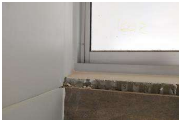
Detalle enchape baño en baño
