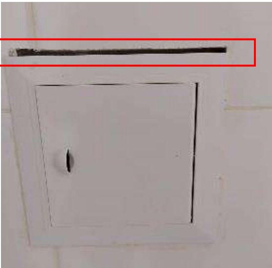
Detalle enchape de pared caja de cableado.
