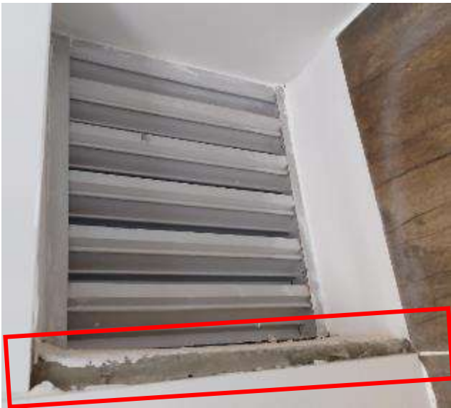
Detalle en ventana baño principal.
