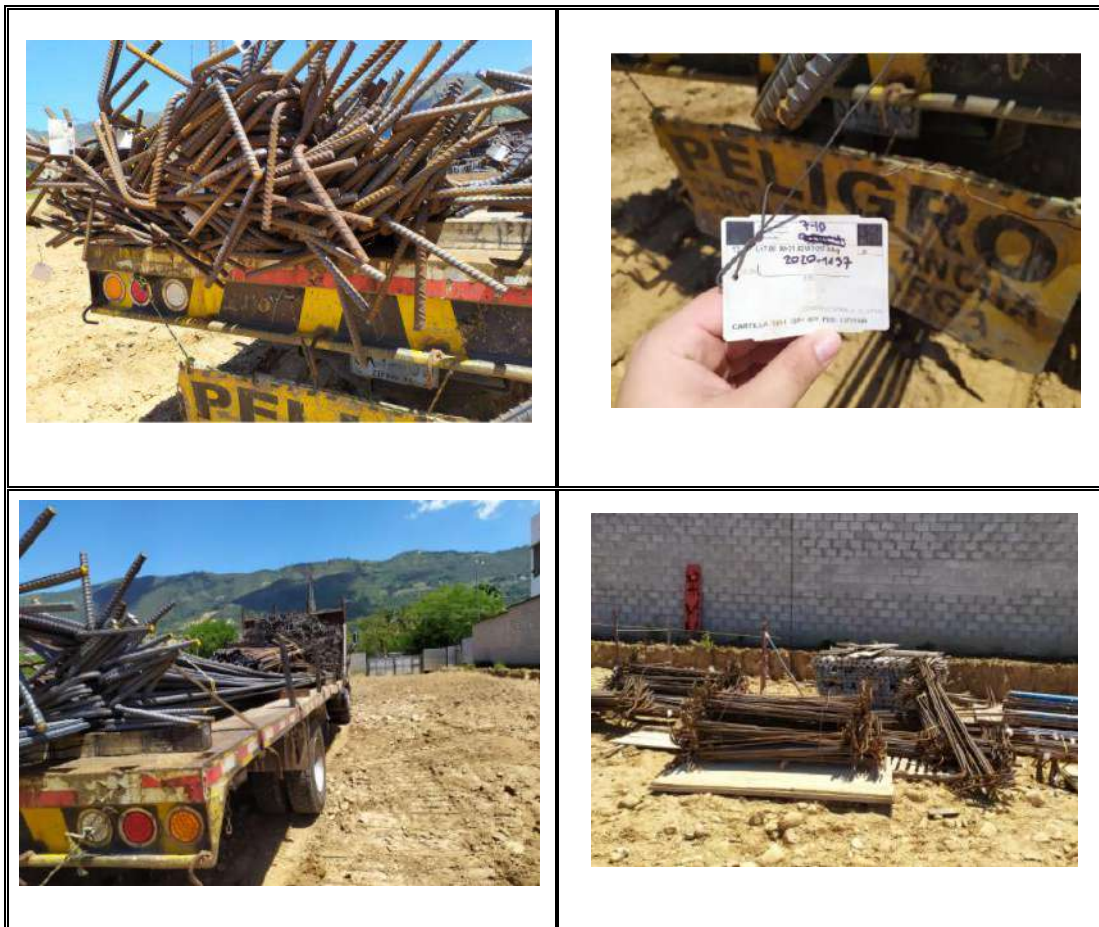
Figura 11. Registro del recibo del acero en obra
