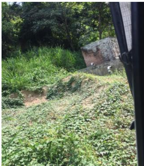
REGISTRO 20. Tanque de agua.
