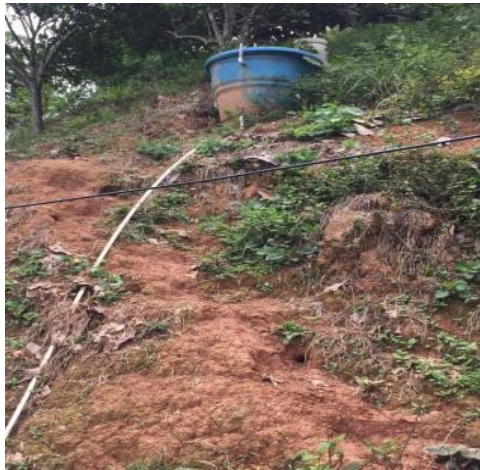
REGISTRO 25. Tanque con acometida de agua hidráulica a la vista.
