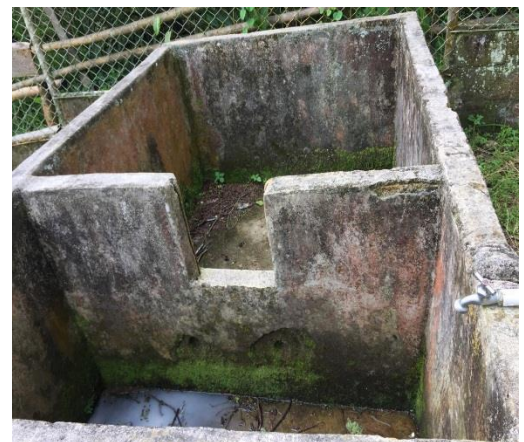
REGISTRO 34. Tanque en ladrillo temosa.
