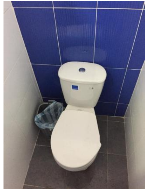
REGISTRO 15. Baterías de baño en buen estado.
