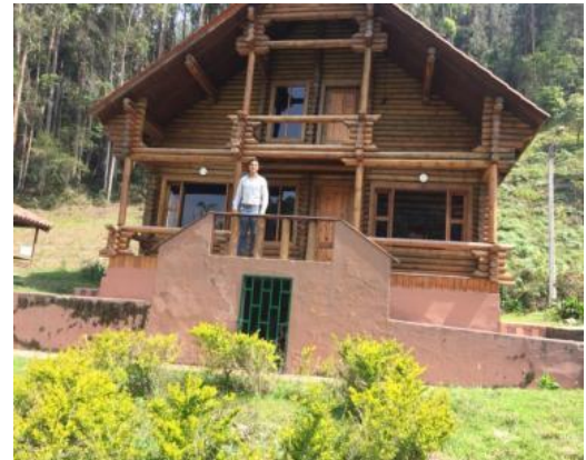
REGISTRO 13. Casa en madera.
