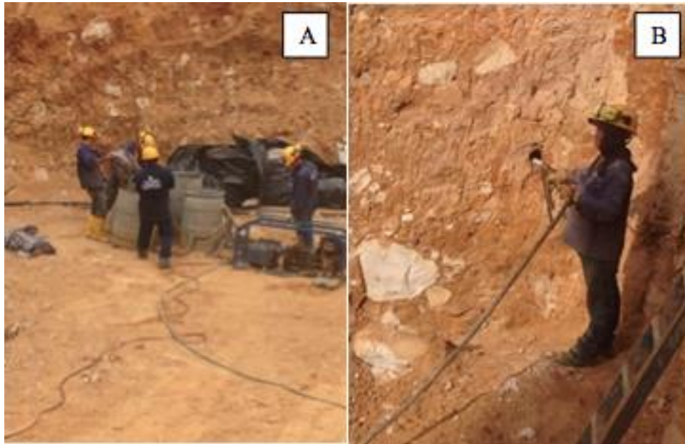
Figura 19. A. Bomba para inyección. B. Inyección y re-inyección de anclaje. Fuente: Autor.
