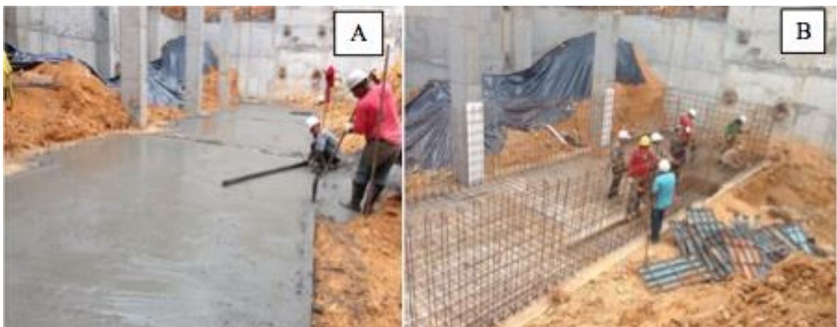
Figura 31.A. Solado de limpieza B. Figuración hierro tanque Fuente: Autor.
