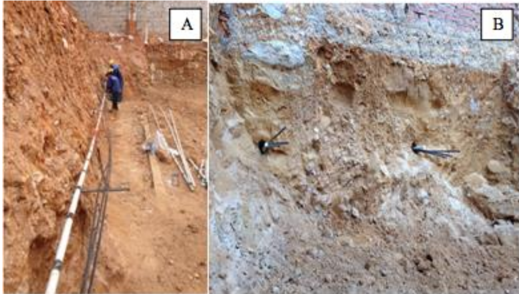
Figura 18. A. Guaya para el anclaje. B. Guaya dentro de la perforación.
