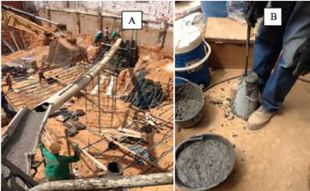
Figura 22. A. Fundida de muro de contención. B. Ensayo de asentamiento. Fuente: Autor.
