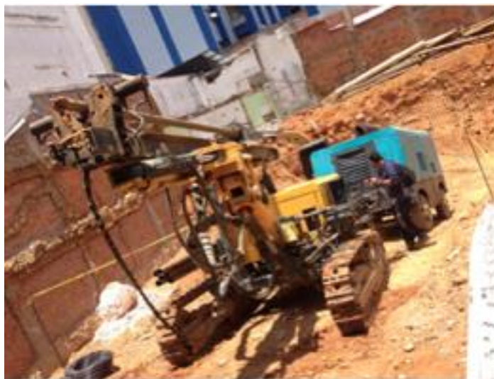
Figura 14. Track de perforación con su compresor.
