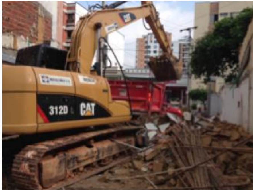
Figura 3. Retroexcavadora, limpieza de escombros. Fuente: Autor.
