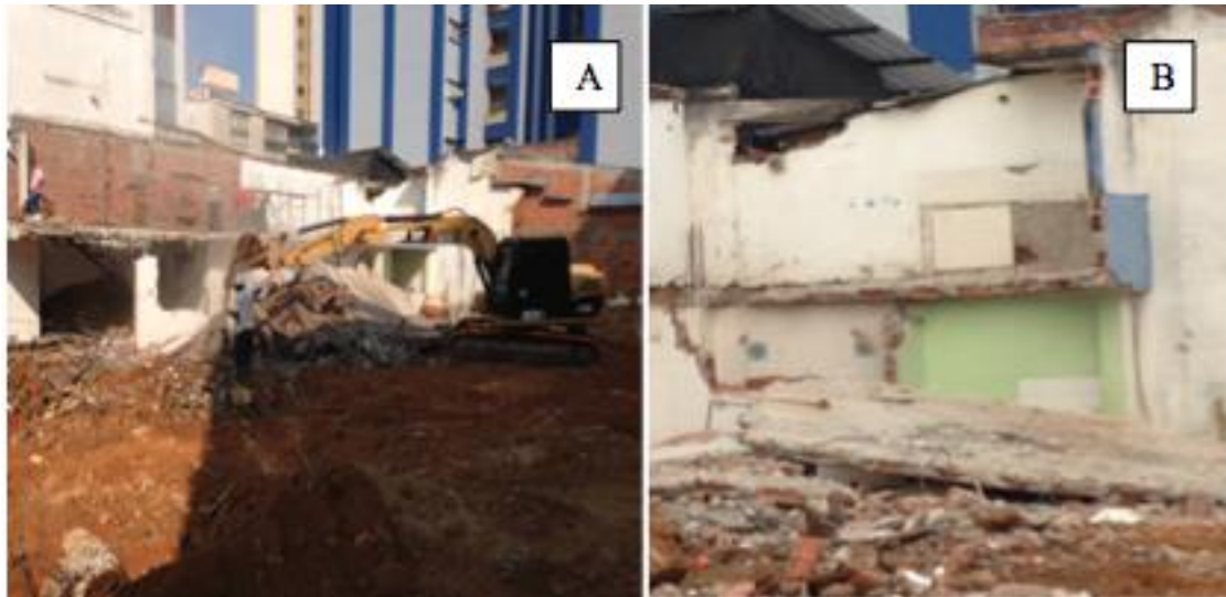
Figura 8. A) eje de placa demolido por retroexcavadora B) Eje final de placa demolido
