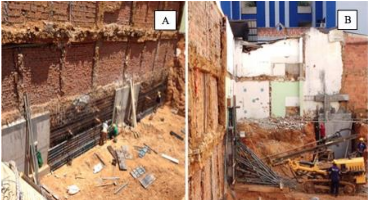
Figura 24. A. Muros de contención. B. Perforación en muro fundido.
