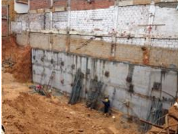
Figura 25. Segundo nivel de anclajes. Fuente: Autor.
