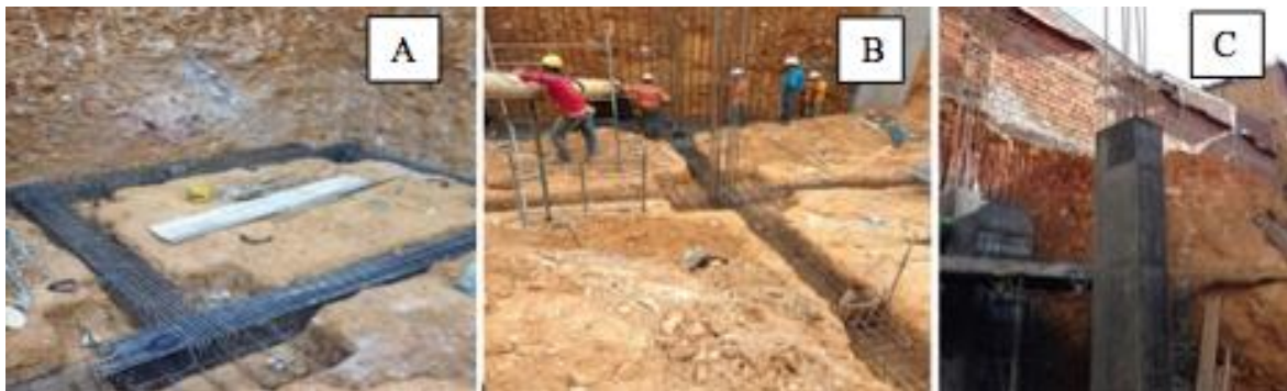
Figura 29. A. Armado de vigas y zapatas.
