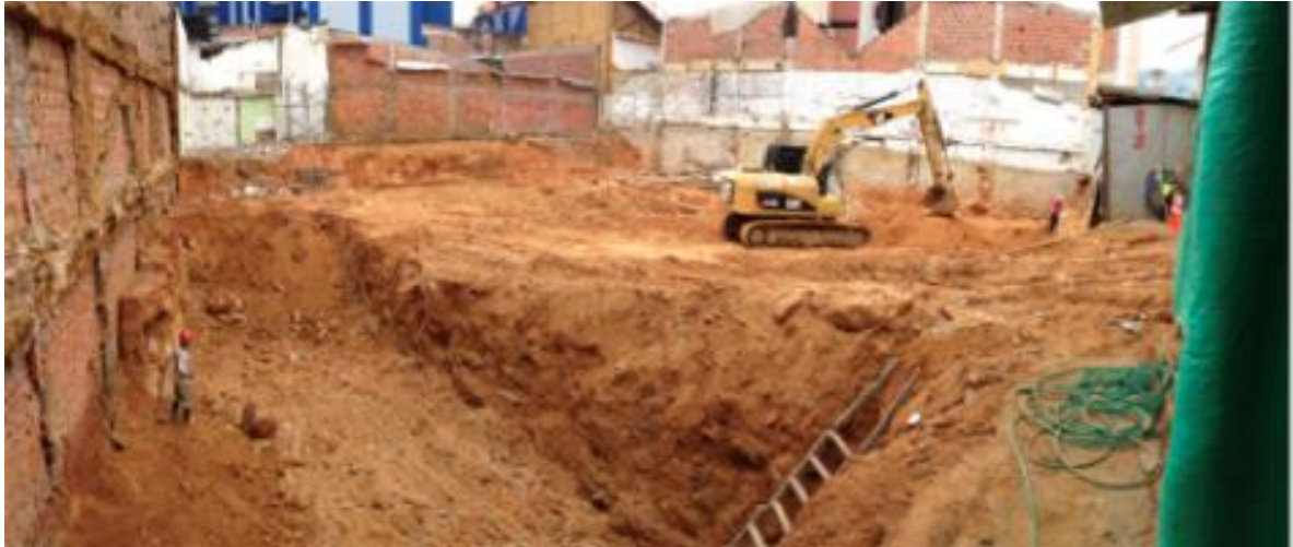
Figura 13. Excavación, profundidad zapata, edificaciones vecinas.
