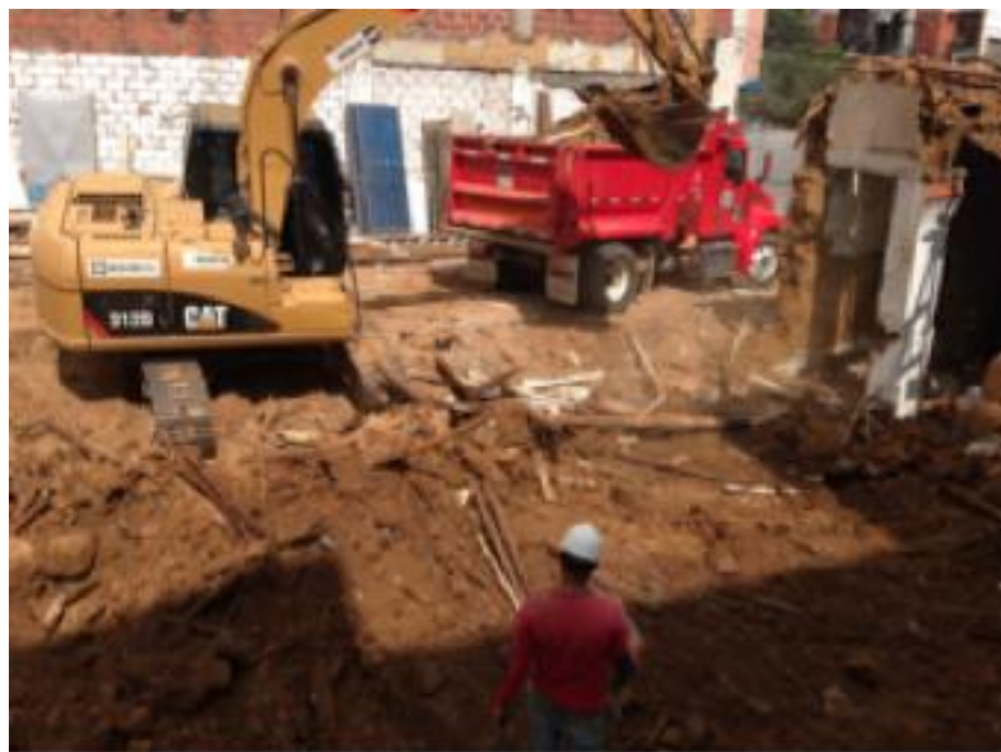
Figura 4. Demolición de muros de tapia Fuente: Autor.
