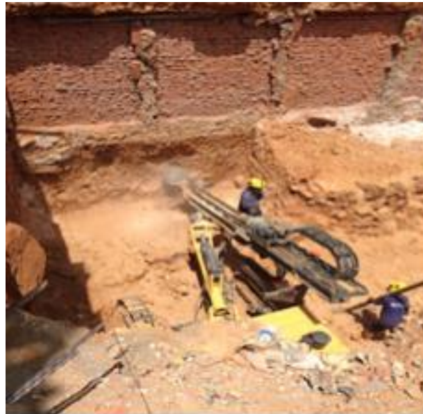
Figura 17. Perforación de anclaje. Fuente: Autor.
