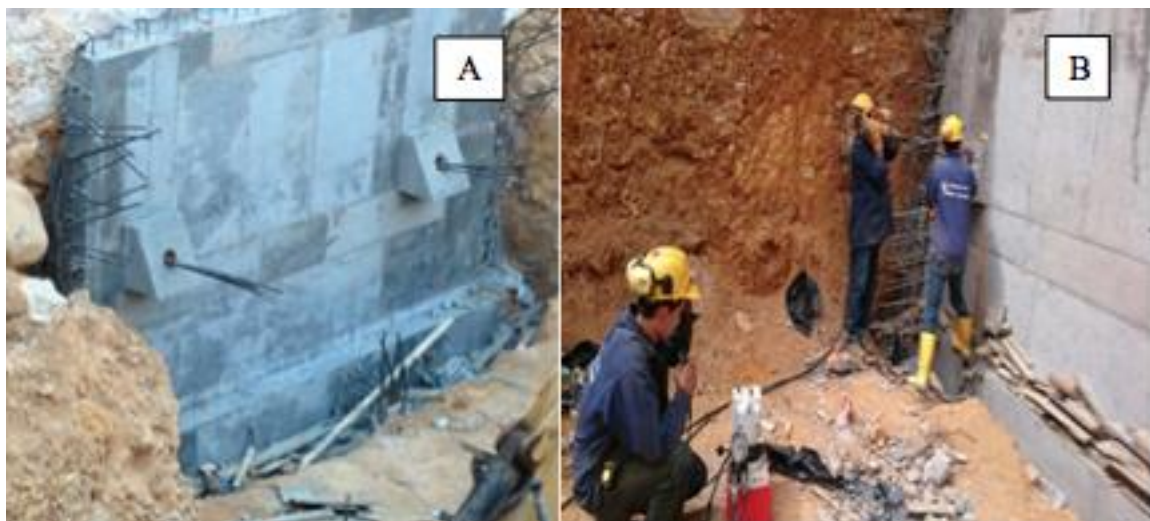
Figura 23. A. Muro de contención fundido. B. Tensionamiento de anclaje. Fuente: Autor.
