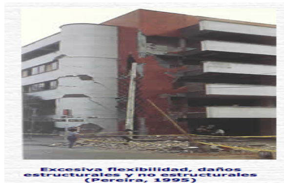
Figura 6. Excesiva flexibilidad, daños estructurales y no estructurales (Pereira, 1995)
