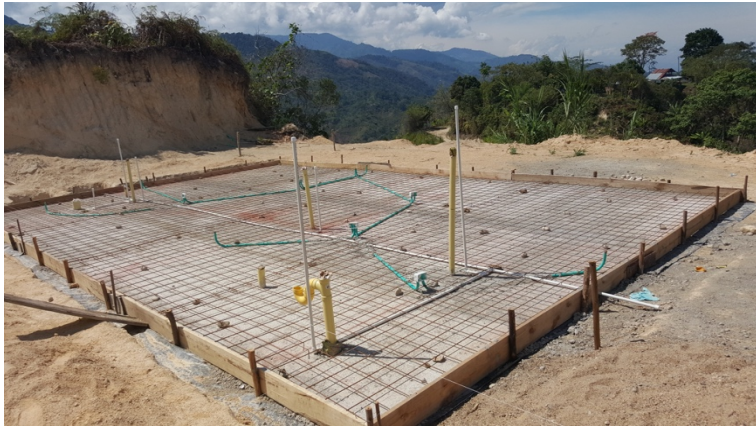
Figura 25. Preparación para fundir placa
