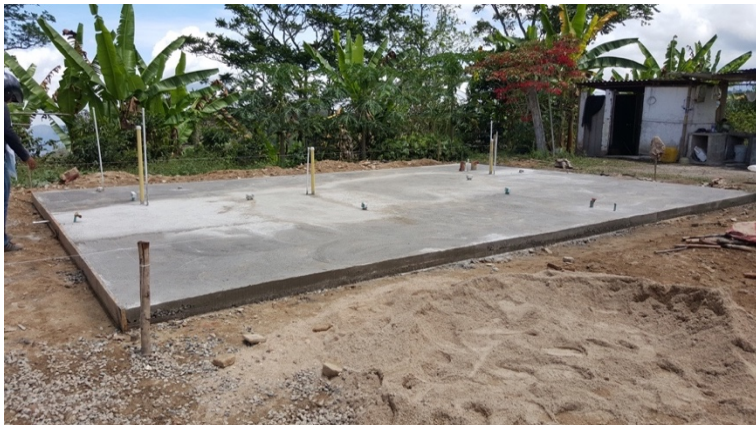
Figura 27. Placa fundida lista para proceso de anclajes
