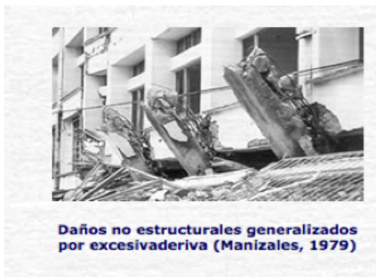
Figura 6. Excesiva flexibilidad, daños estructurales y no estructurales (Pereira, 1995)
