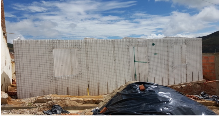
Figura 28. Paneles en su sitio listos para la aplicación de las capas de mortero
