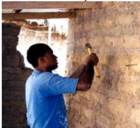
Figura 23. Instalación de malla para reforzar edificaciones en tapia
