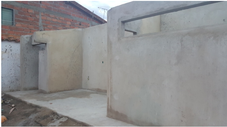
Figura 29. Muros frisados
