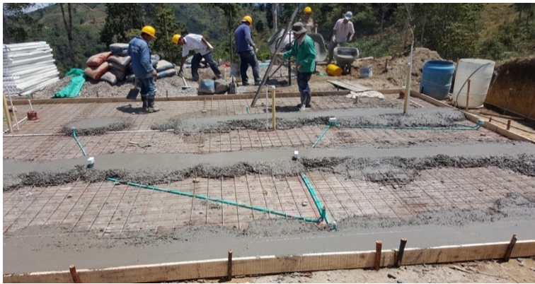
Figura 26. Fundición de placa
