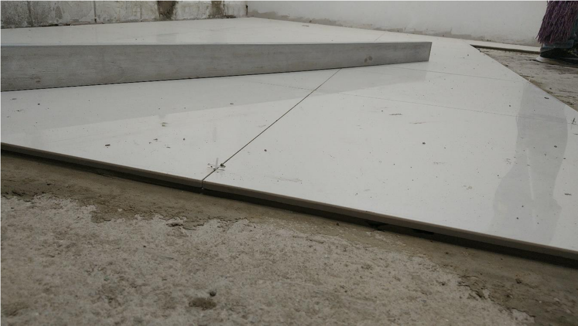
Ilustración 19 Revisión de nivel y correcto uso de juntas
