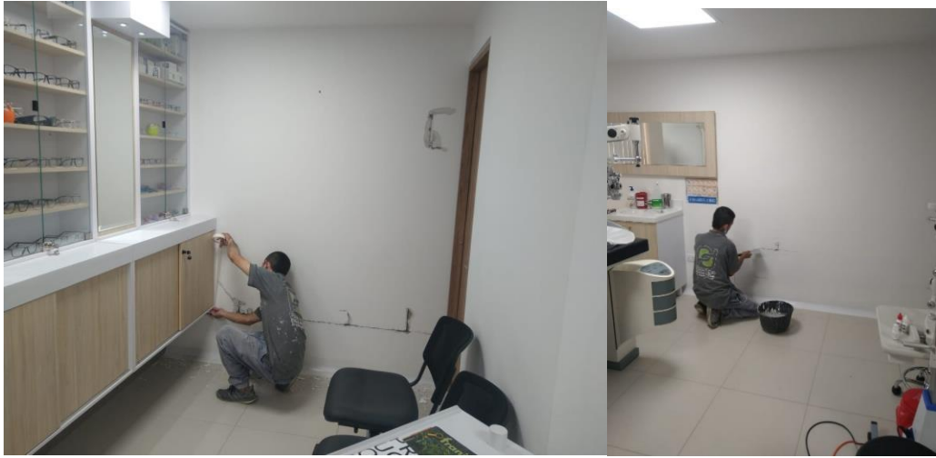
Ilustración 16 Reparación de daños de consultorio vecino
