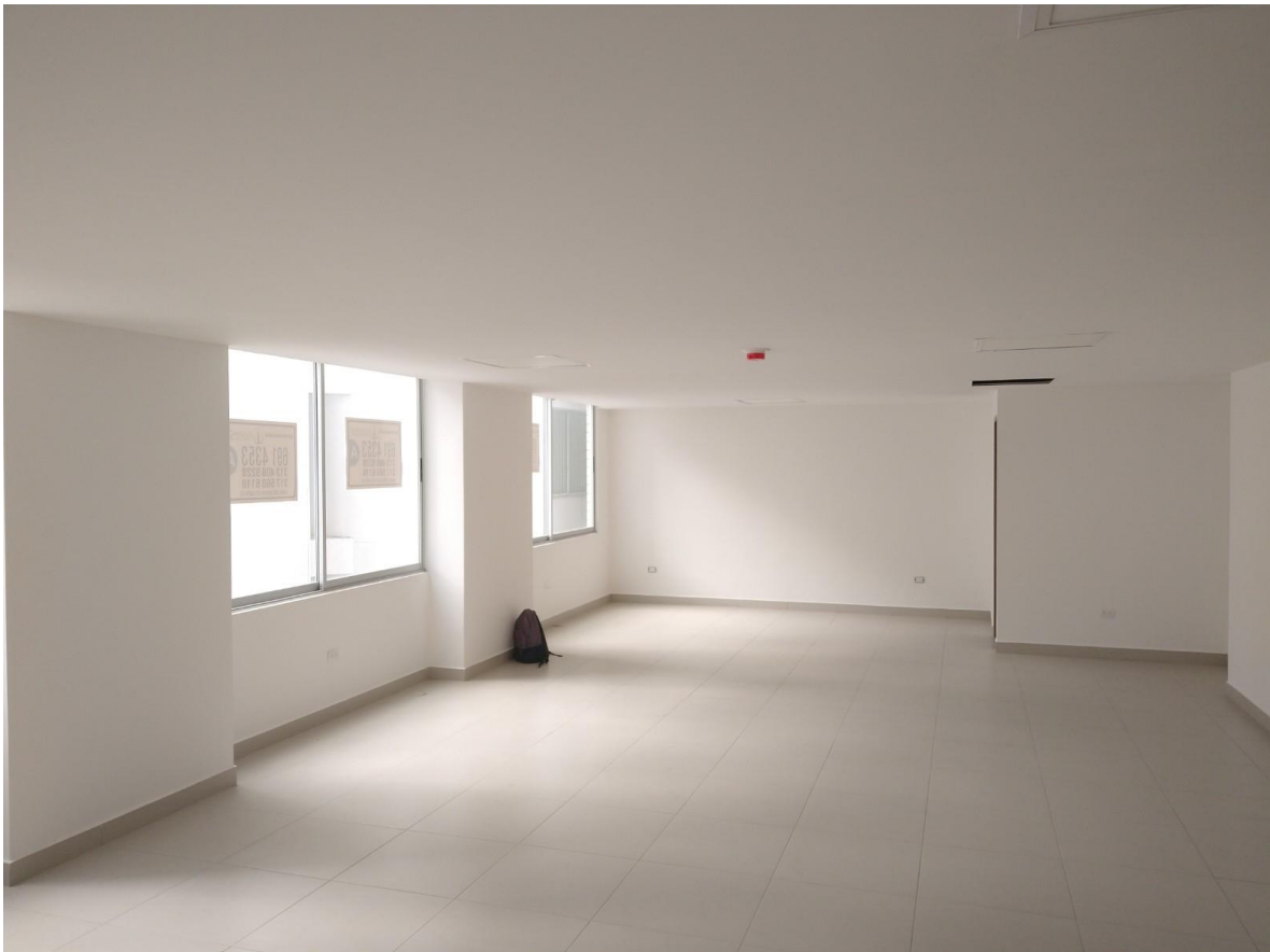
Ilustración 12 Consultorio sin remodelación
