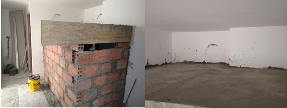
Ilustración 15 Cuarto de máquinas en mampostería
