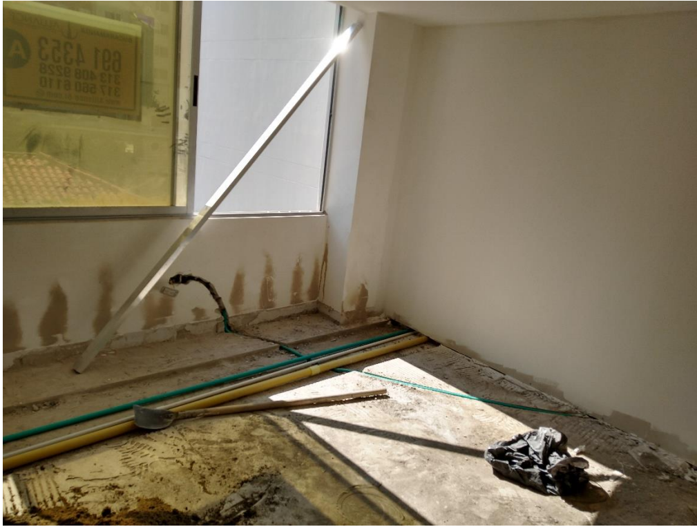
Ilustración 17 Demolición de piso del consultorio
