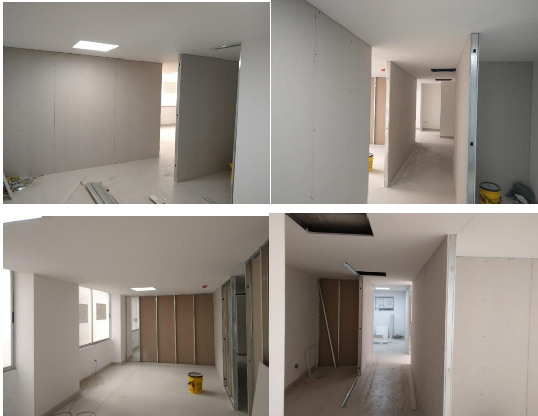
Ilustración 14 Instalación de drywall
