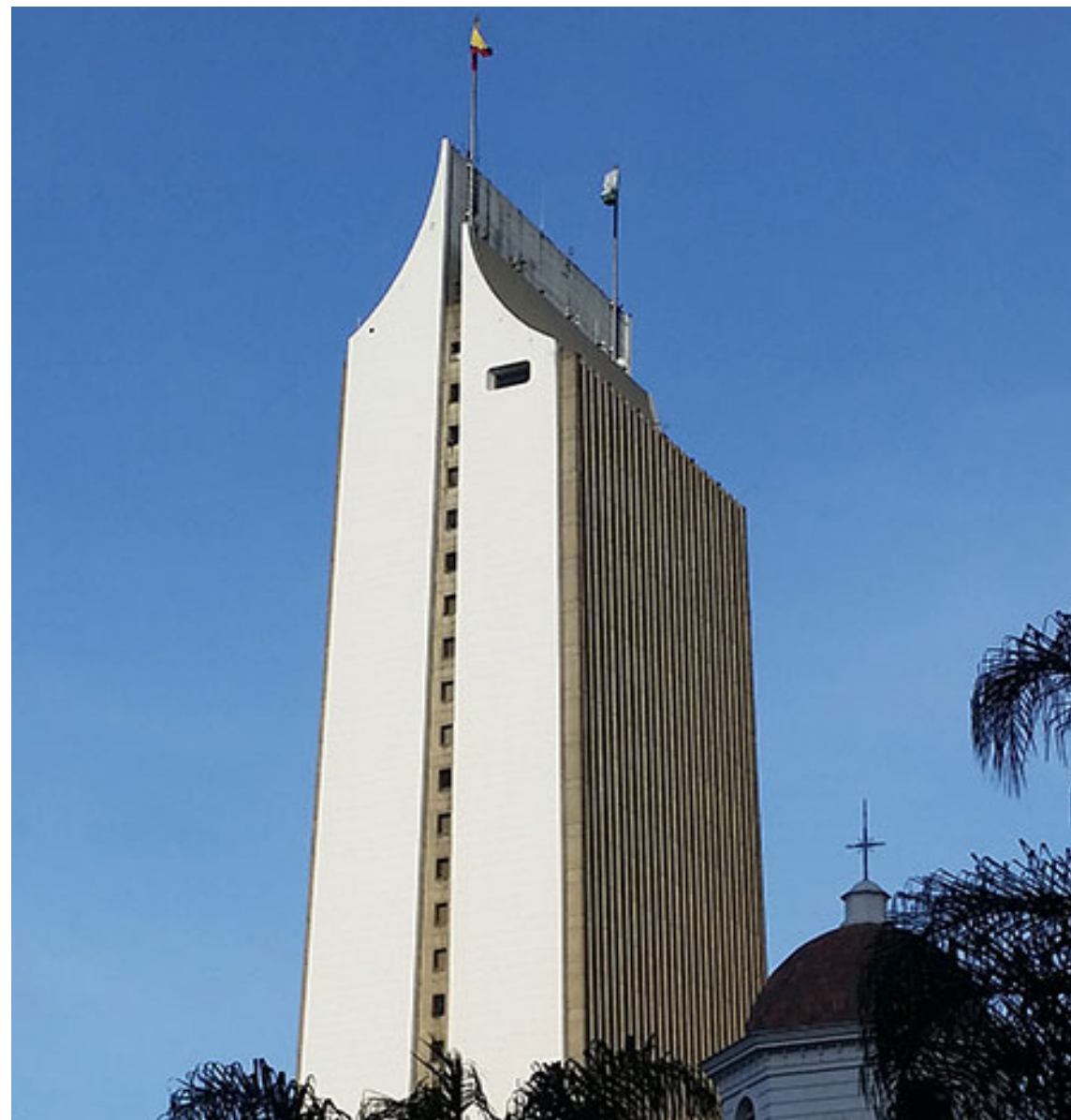
Imagen 16: Edificio Coltejer, vista general- Medellín, Colombia. Imagen de autor.
