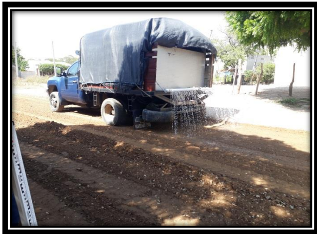
Imagen 19. Base Granular, Humectación y Compactación. Fuente:( Elaboración Propia)
