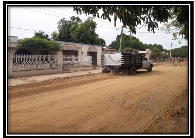
Imagen 19. Base Granular, Humectación y Compactación. Fuente:( Elaboración Propia)
