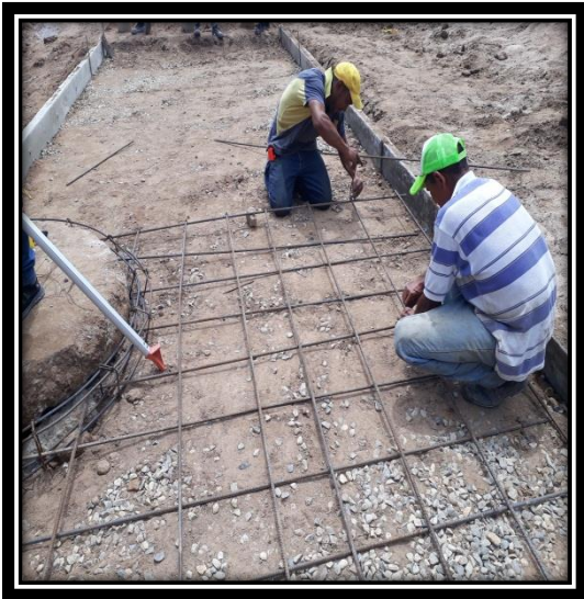
Imagen 22. Acero de Refuerzo (Corte, Amarre e Instalación) Fuente:( Elaboración Propia)
