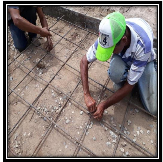
Imagen 22. Acero de Refuerzo (Corte, Amarre e Instalación) Fuente:( Elaboración Propia)
