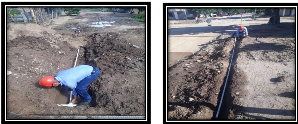
Imagen 25 Suministro e instalación de tuberías. Fuente:( Elaboración Propia)
