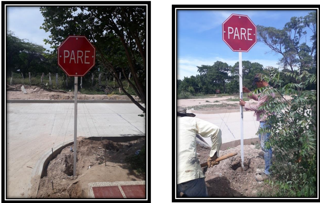
Imagen 17. Estructuras de Soporte de las Señales. Fuente:( Elaboración Propia)
