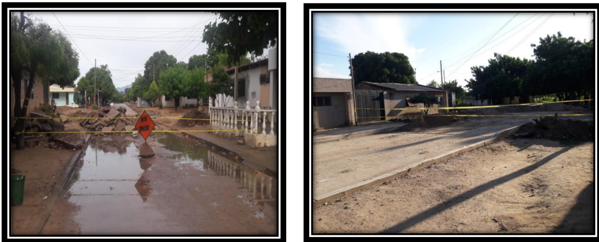
Imagen 8. Cerramiento, delimitación y señalización de obra. Fuente:( Elaboración Propia)
