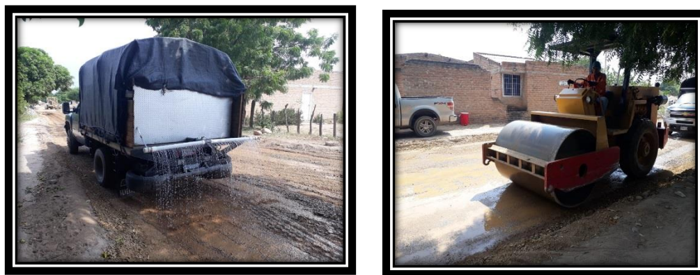
Imagen 16. Humectación y compactación del terreno. Fuente:( Elaboración Propia)
