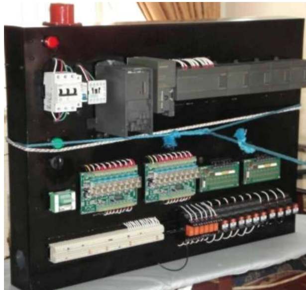
Figura 3.32 Panel frontal con todos los elementos ya instalados
