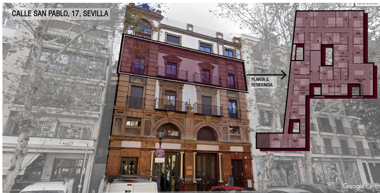
Imagen 75. Imagen que muestra fachada principal del edificio junto a una planta del tercer piso. Elaboración propia.
