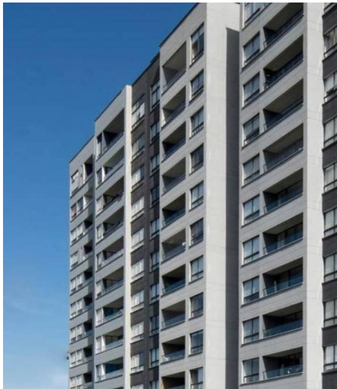
Imagen 41. Fachada del edificio, exponiendo la materialidad de sus acabados. Tomada por autora.
