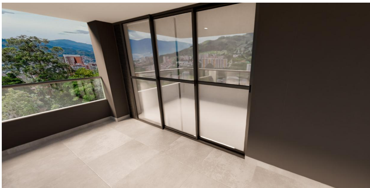
Imagen 38. Sistema constructivo y materialidad utilizada en la construcción del edificio de vivienda colectiva. Imagen tomada por autora.
