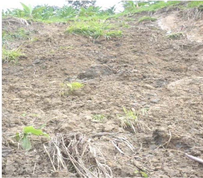
Figura 6. Zona de erosión vereda La Colorada
