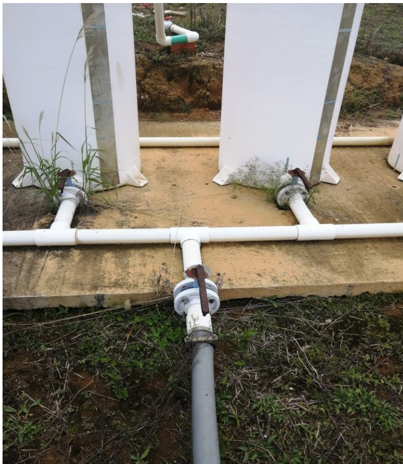
Figura 15. Punto óptimo para instalación de bomba dosificadora AFG.
