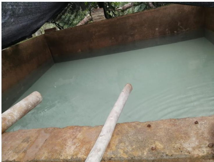
Figura 8. Tratamiento de agua en un solo tanque.
