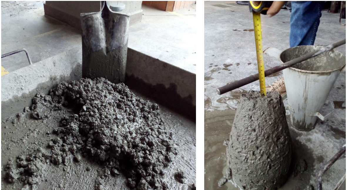
Figura 12. Consistencia de la mezcla de Concreto
