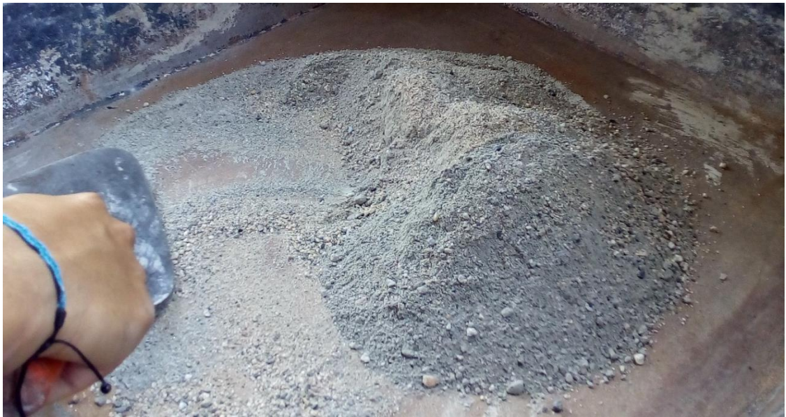
Figura 16. Preparación de la mezcla de mortero
