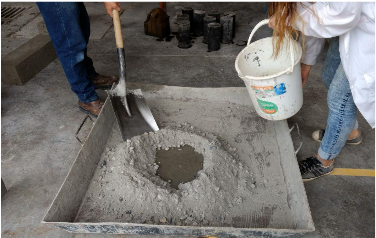
Figura 11. Preparación de la mezcla de Concreto
