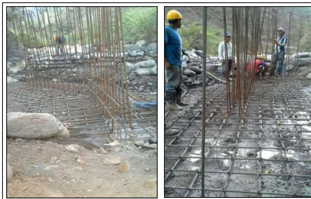
Figura 26. Armado Acero de refuerzo Construcción Bocatoma.
