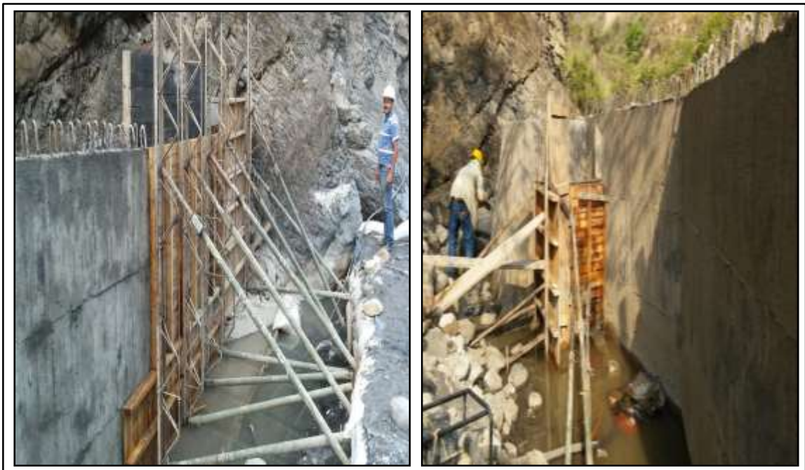
Figura 27. Armado de formaleta para construcción Bocatoma.
