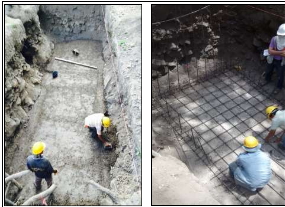
Figura 25. Excavación (Izquierda) y Acero de refuerzo (Derecha) para zarpa de cimentación.
