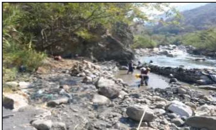
Figura 24. Manejo de Aguas para construcción de Bocatoma.
