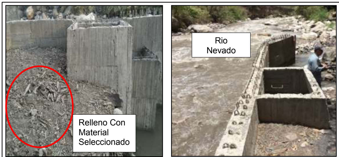
Figura 28. Terminación de Bocatoma y Relleno con material Seleccionado.
