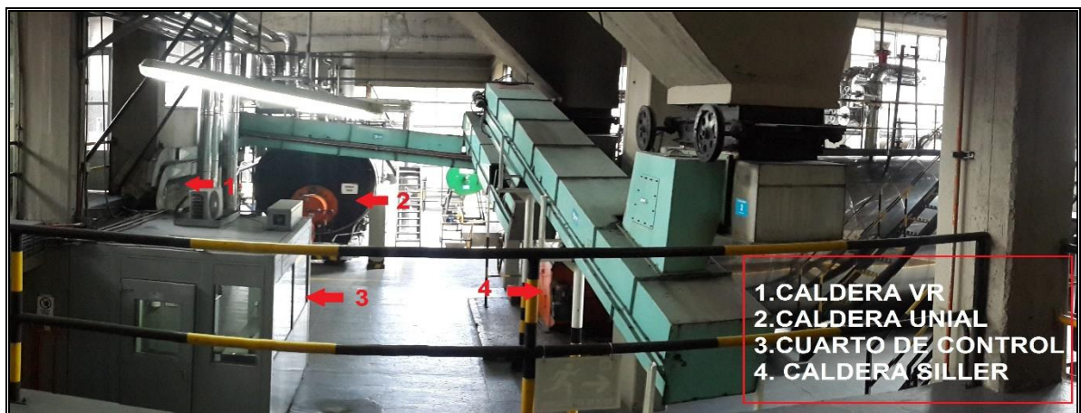
Ilustración 4. Panorámica área de Calderas Fuente: Autor.
