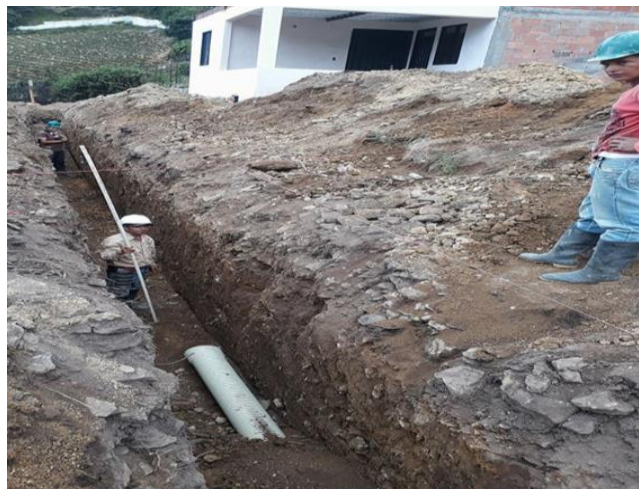
Ilustración 12: Nivelación de la tubería para cumplimiento de la pendiente. Fuente: Autor.
