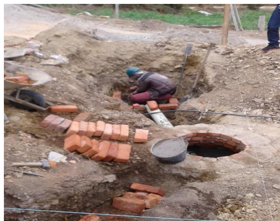
Ilustración 27: Domiciliaria de alcantarillado con longitud de 2 metros. Fuente: Autor.
