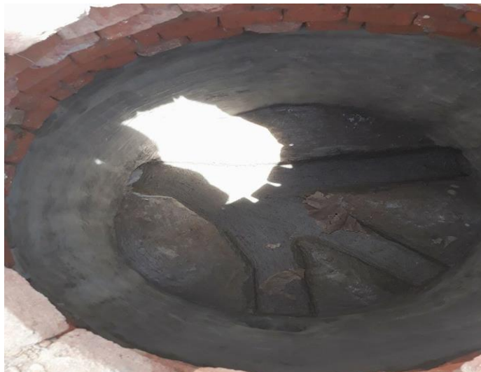
Ilustración 5: Detalle Pozo de inspección N° 2 del alcantarillado. Fuente: Autor.
