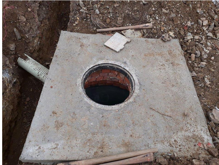
Ilustración 3: Acometida del tramo de alcantarillado durante su etapa constructiva. Fuente: Autor.
