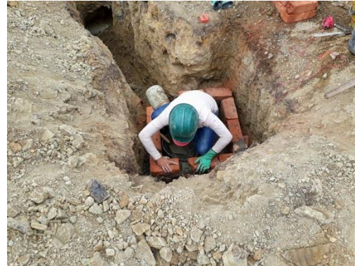
Ilustración 29: Construcción de cajas de inspección.
