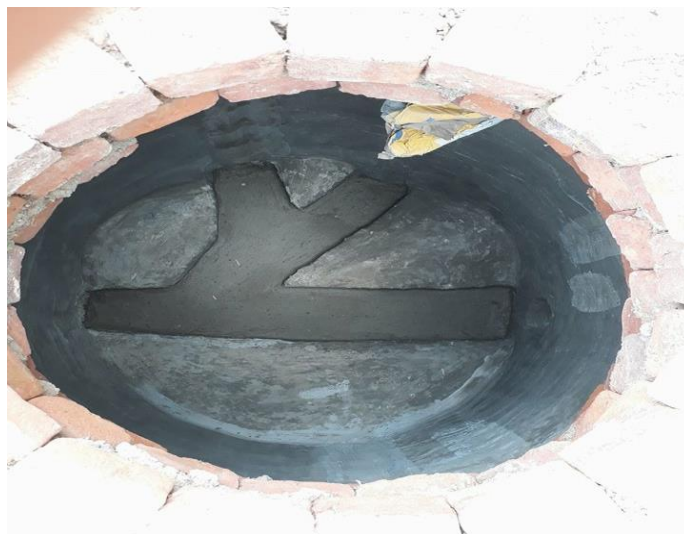
Ilustración 7: Cañuela del pozo de inspección N° 5. Fuente: Autor.
