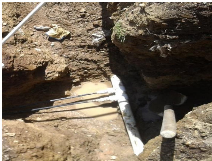
Ilustración 2: Acometida de acueducto, construidas en el proyecto. Fuente: Autor.
