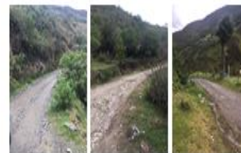
Ilustración 40: Inspección ocular para verificación de tramos placas huellas. Fuente: Autor.
