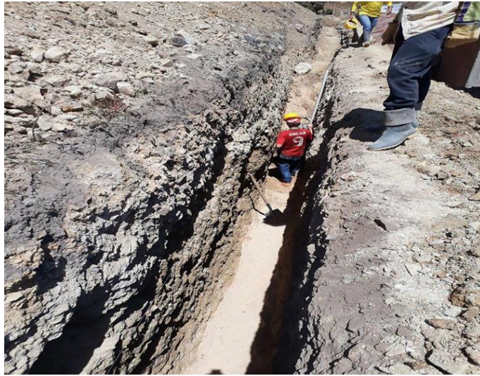
Ilustración 36: Colchón de arena, espesor 10 cm. Fuente: Autor.
