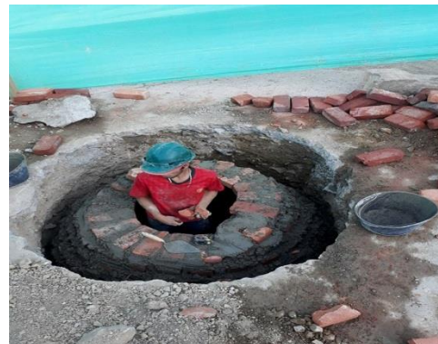
Ilustración 31: Construcción del cono con diámetro 60.
