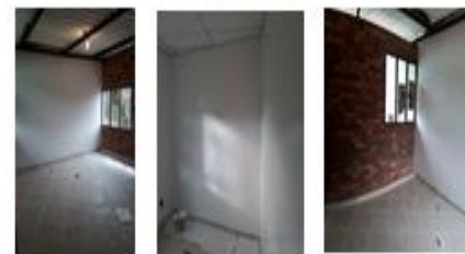
Ilustración 48: Inspección ocular adecuación oficinas. Fuente: Autor.
