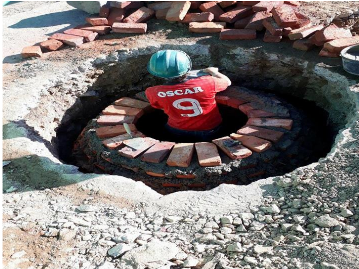
Ilustración 13: Pozo de inspección N° 1 altura = 1,6. Fuente: Autor.
