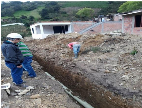
Ilustración 25: Instalación de tubería NOVAFORT.
