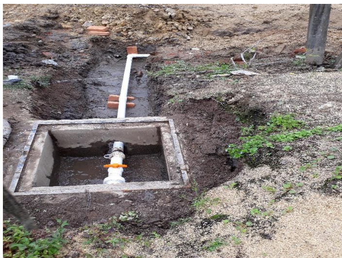
Ilustración 34: suministro e instalación de tubería PVC RDE 21 d=2". Fuente: Autor.
