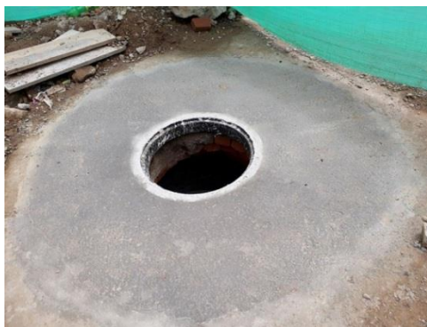
Ilustración 32: Pozo de alcantarillado terminado. Fuente: Autor.
