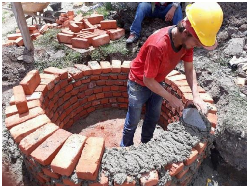
Ilustración 30: Construcción cilindro pozo de alcantarillado. cm
