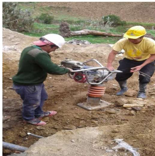
Ilustración 38: Compactación con material seleccionado
