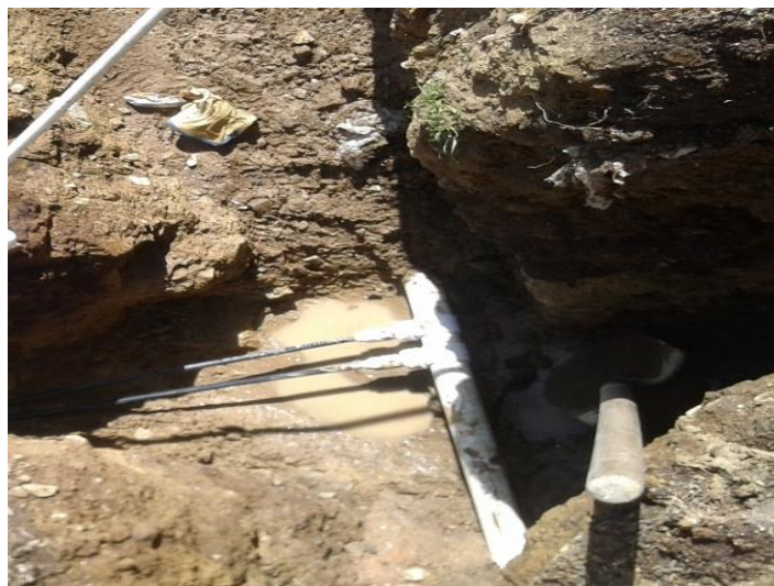
Ilustración 35: Suministro e instalación de domiciliaria de acueducto. Fuente: Autor.
