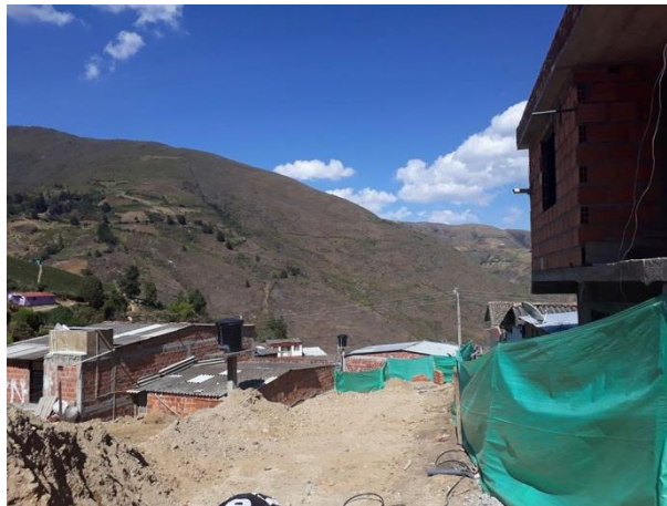
Ilustración 20: Cerramiento Provisional para lograr aislamiento de la zona de trabajo. Fuente: Autor.
