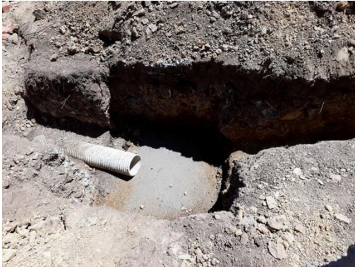
Ilustración 28: Base en concreto con espesor de 12 cm.
