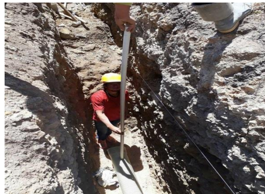
Ilustración 26: Instalación de tubería, toma de niveles.
