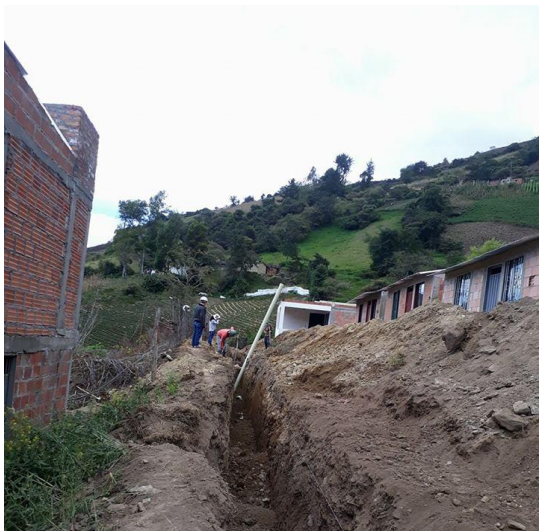
Ilustración 37: Relleno con material seleccionado
