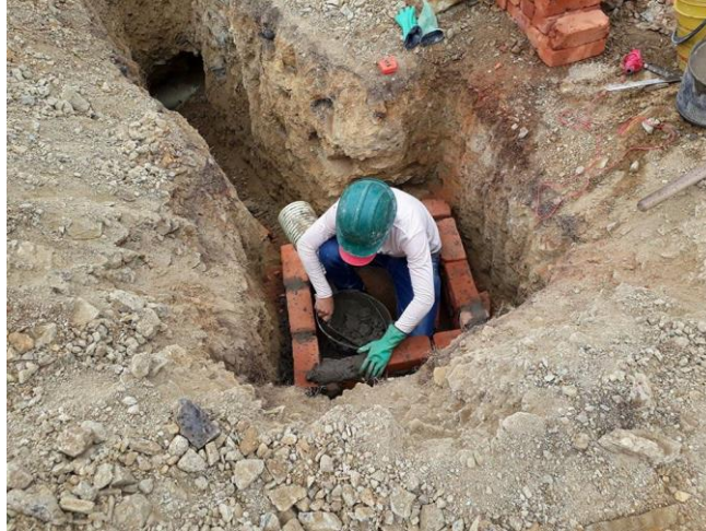
Ilustración 6: Construcción de caja de inspección de 60*60*60 cm. Fuente: Autor.
