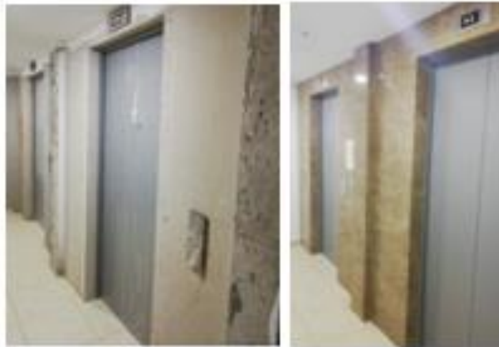
Ilustración 33 Enchape caras de ascensores.
