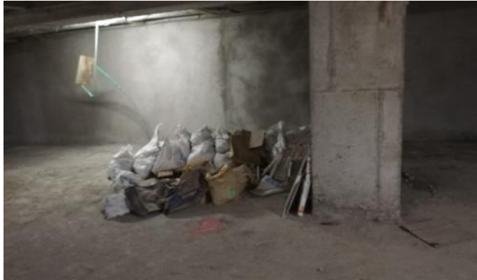
Ilustración 6 Escombros de la obra.
