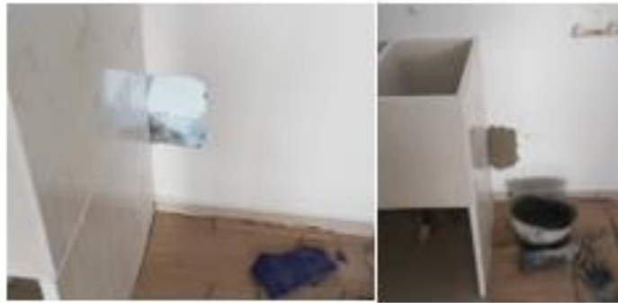
Ilustración 13 Resane de hueco en apartamento.
