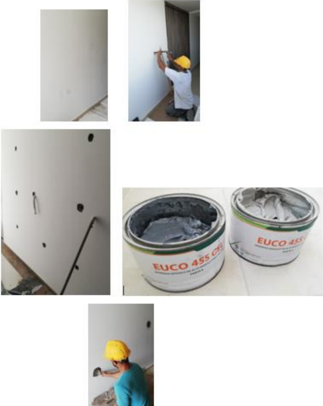
Ilustración 22 Procedimiento de quitar grasa de muros.
