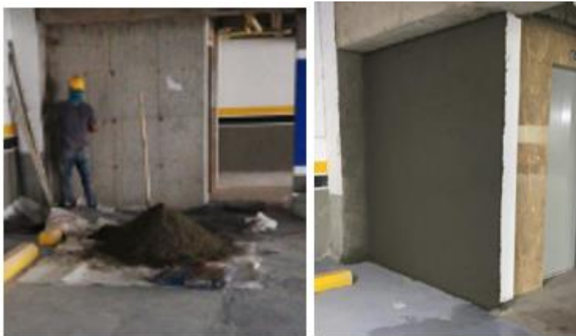
Ilustración 19 Friso de pantalla para poder pintar.
