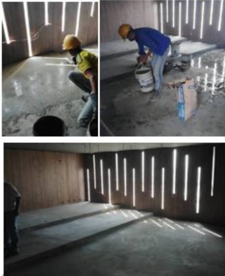
Ilustración 8 Procedimiento de quemar piso sala de cine.
