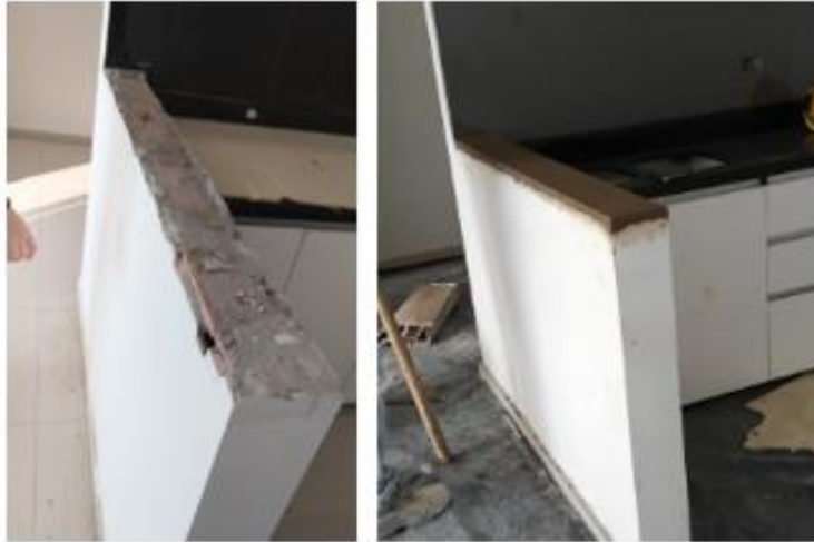
Ilustración 9 Resane de barra de la cocina apartamentos.
