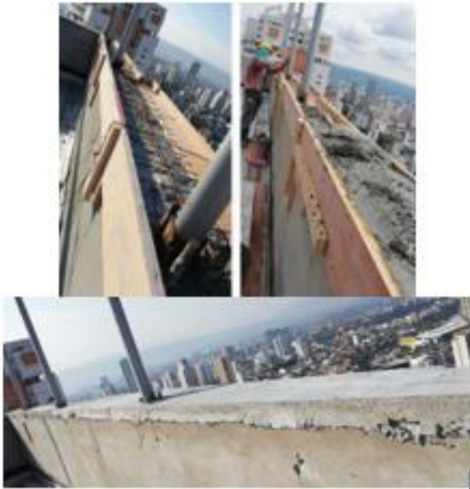
Ilustración 20 Realización alfajía cancha sintética.
