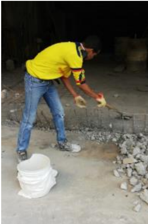
Ilustración 17 Demolición del mortero n0.
