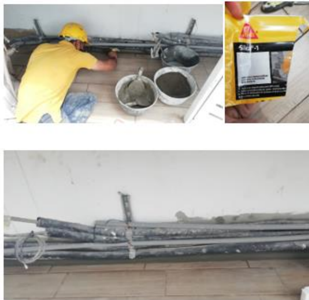
Ilustración 12 Aplicación de Sika-1 en media caña.
