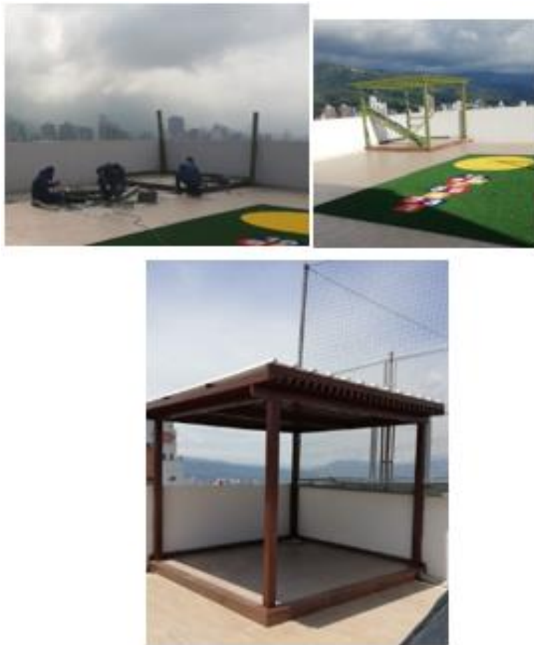
Ilustración 29 Instalación de quioscos en piso 30.
