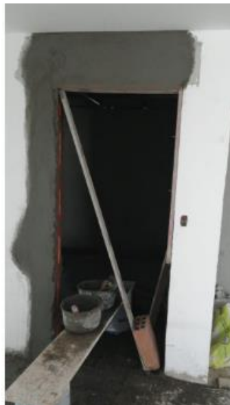
Ilustración 14 Modificación dimensión de puerta.
