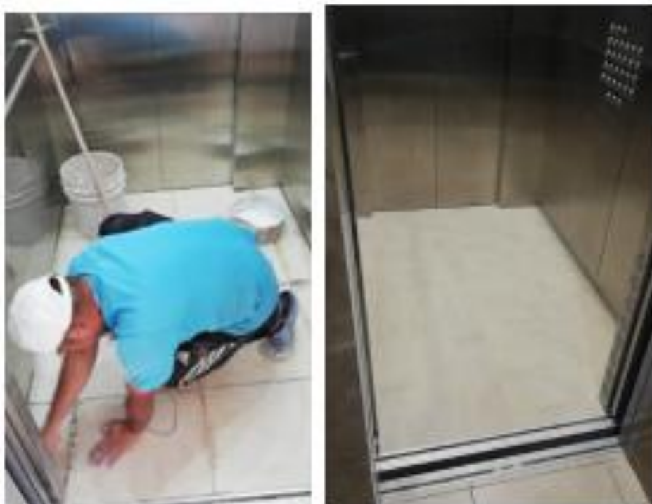
Ilustración 34 Enchape de piso ascensores.
