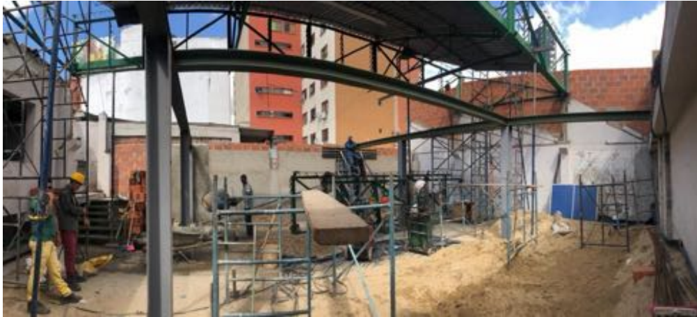
Ilustración 56 Instalación de columna HEA 200 (Fuente propia).
