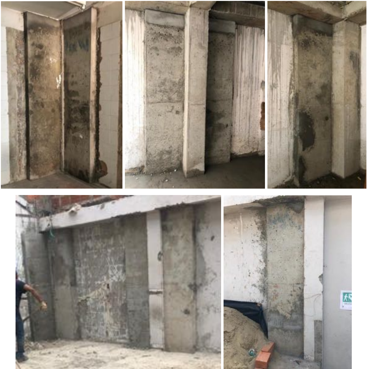
Ilustración 37 Construcción de pantallas (Fuente propia)
