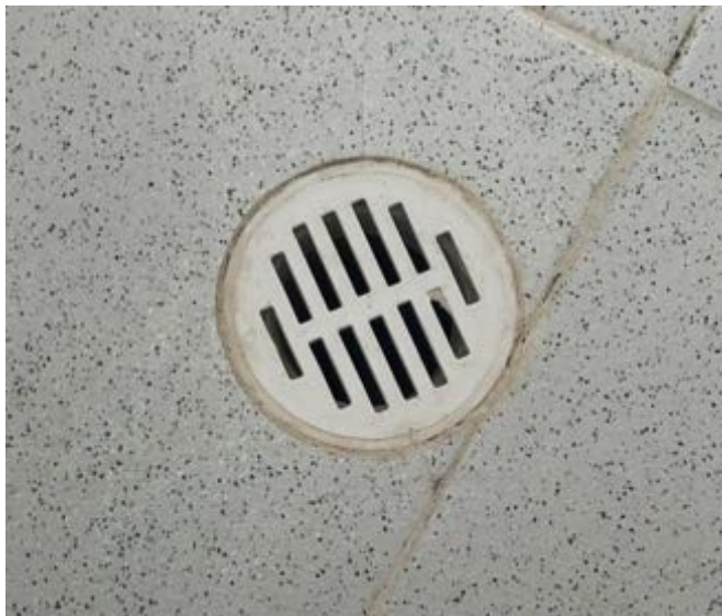
Ilustración 92 Instalación de rejillas (Fuente propia)
