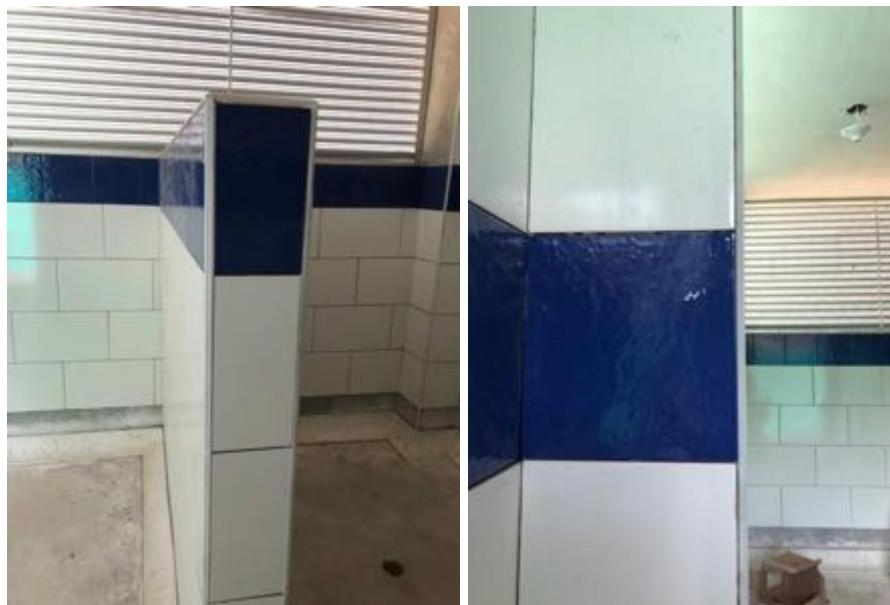
Ilustración 88 Instalación de perfiles plásticos (Fuente propia)
