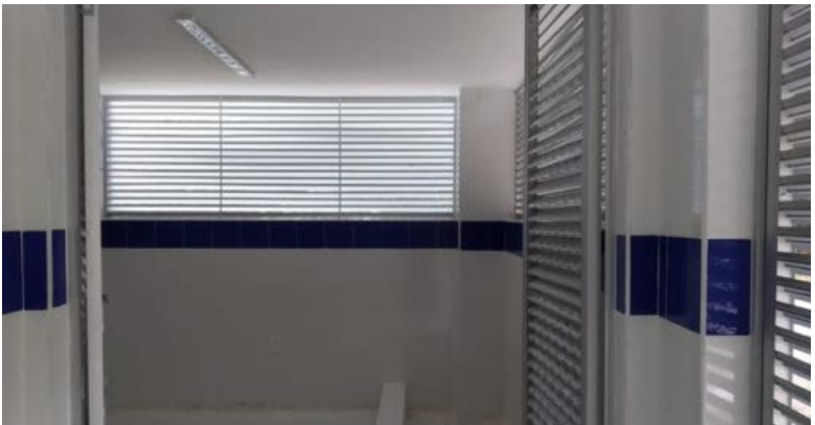
Ilustración 108 Finalización de obra (Fuente propia)
