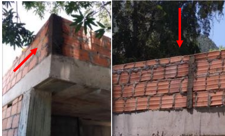
Ilustración 70 Columnetas en concreto antepecho terraza.
