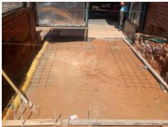
Ilustración 14 Malla electrosoldada (Fuente propia)
