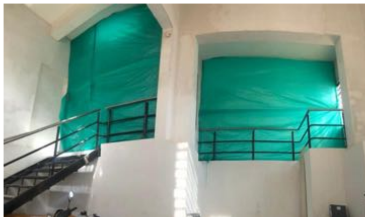
Ilustración 16 Cerramiento de obra (Fuente propia)
