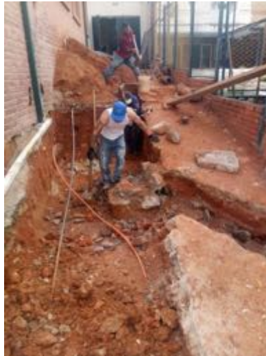
Ilustración 3 Excavación (Fuente propia)
