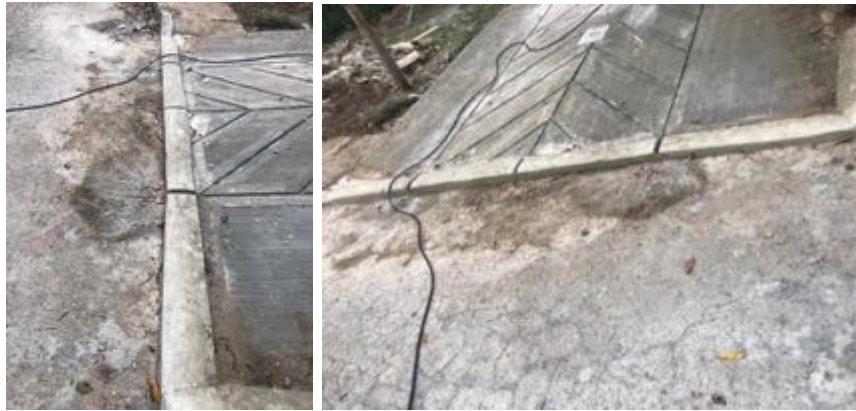
Ilustración 74 Construcción de Bordillos (Fuente propia)
