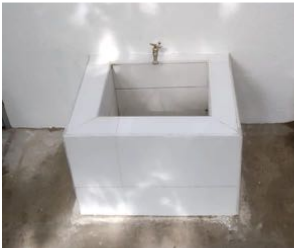
Ilustración 94 Instalación de Poceta (Fuente propia)
