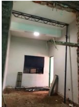
Ilustración 19 Demolición de muro y piso de oficina de rectoría (Fuente propia)
