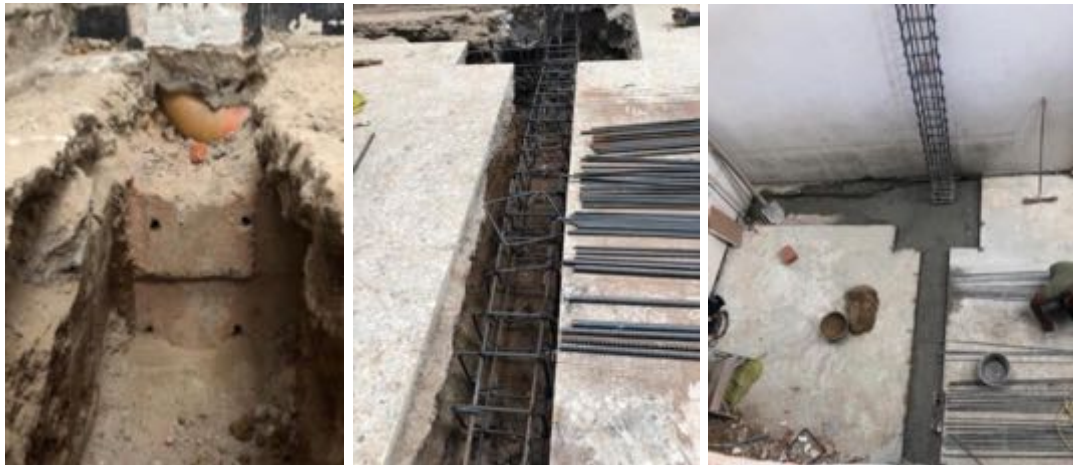
Ilustración 27 Construcción de Viga de amarre y zapata de cimentación (Fuente propia)
