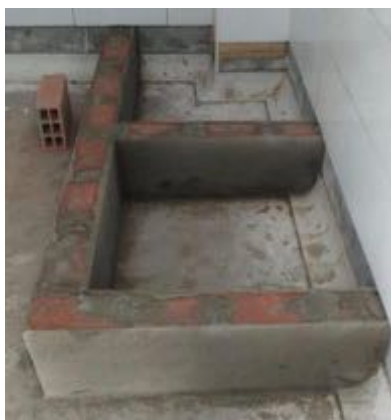
Ilustración 78 Mampostería y friso en dique de contención
