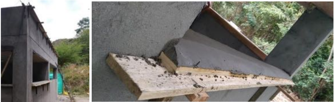
Ilustración 72 Alfajias en concreto (Fuente propia)
