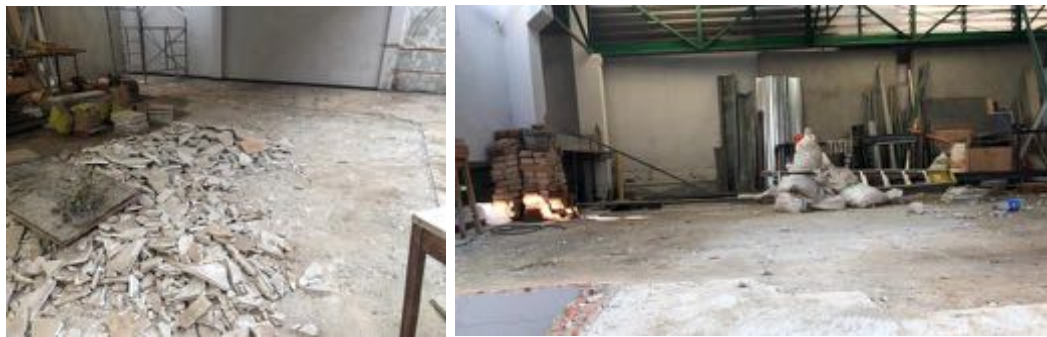
Ilustración 20 Demolición de piso (Fuente propia)
