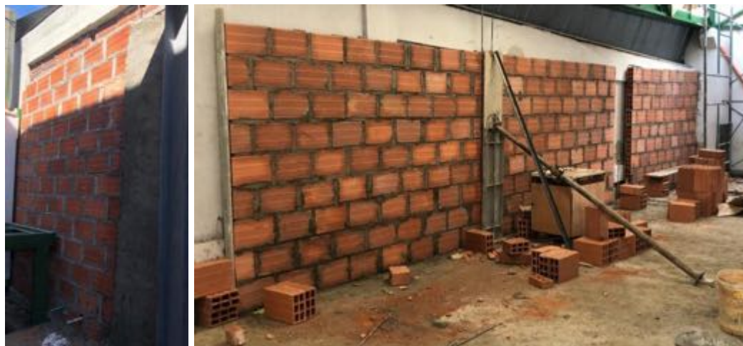
Ilustración 39 Muro en mampostería (Fuente propia)
