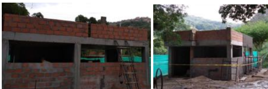
Ilustración 77 Suministro e instalación de Mampostería (Fuente propia)
