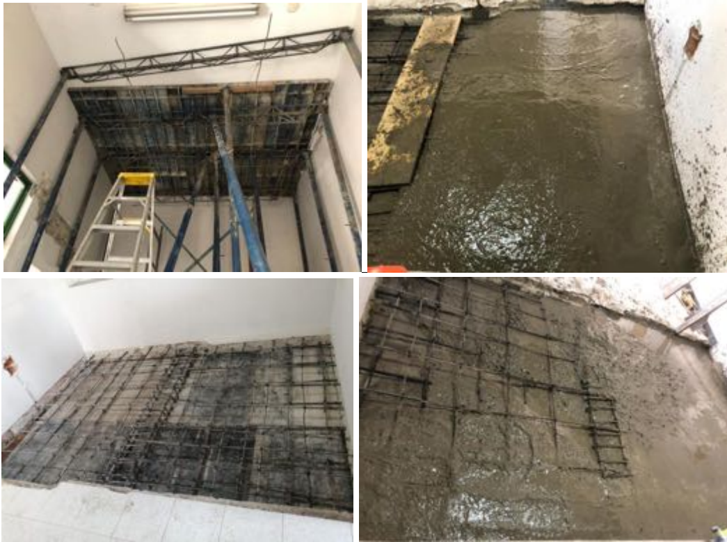
Ilustración 32 Fundida de placa segundo piso (Fuente propia)
