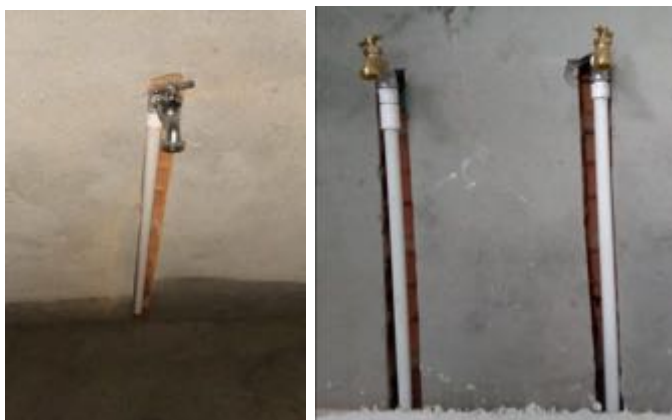
Ilustración 93 Instalación de llaves terminar de manguera (fuente propia)
