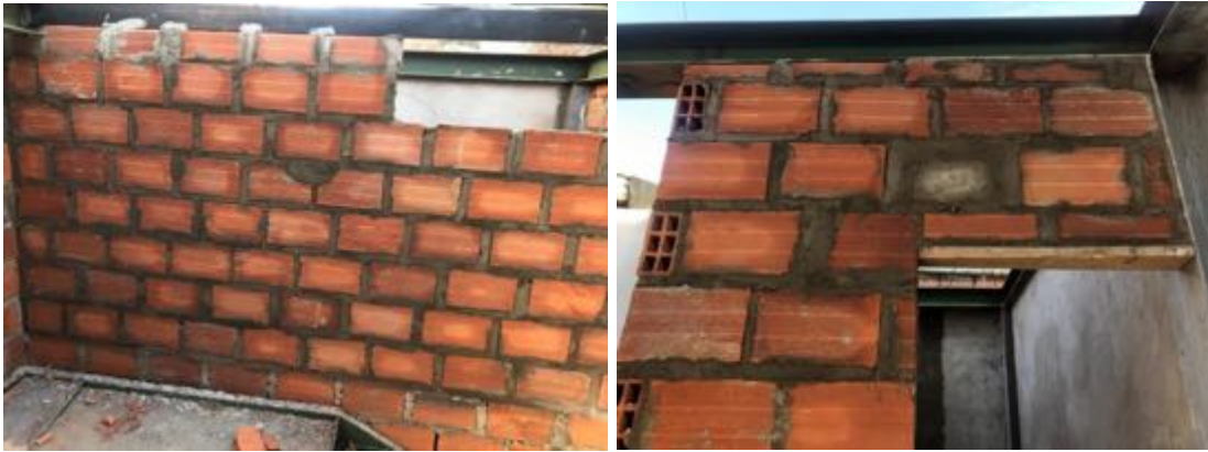
Ilustración 40 Muro de mampostería para baño (Fuente propia)
