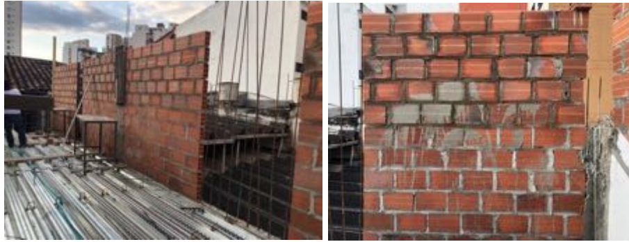
Ilustración 42 Muro de mamposteria tercer nivel (Fuente propia)
