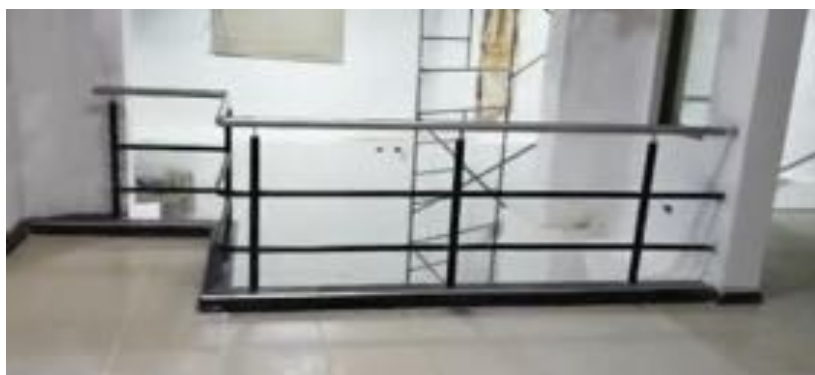
Ilustración 10 Instalación de pasamanos (Fuente propia)
