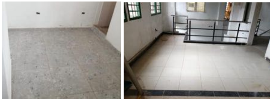
Ilustración 7 Enchape de piso (Fuente propia)
