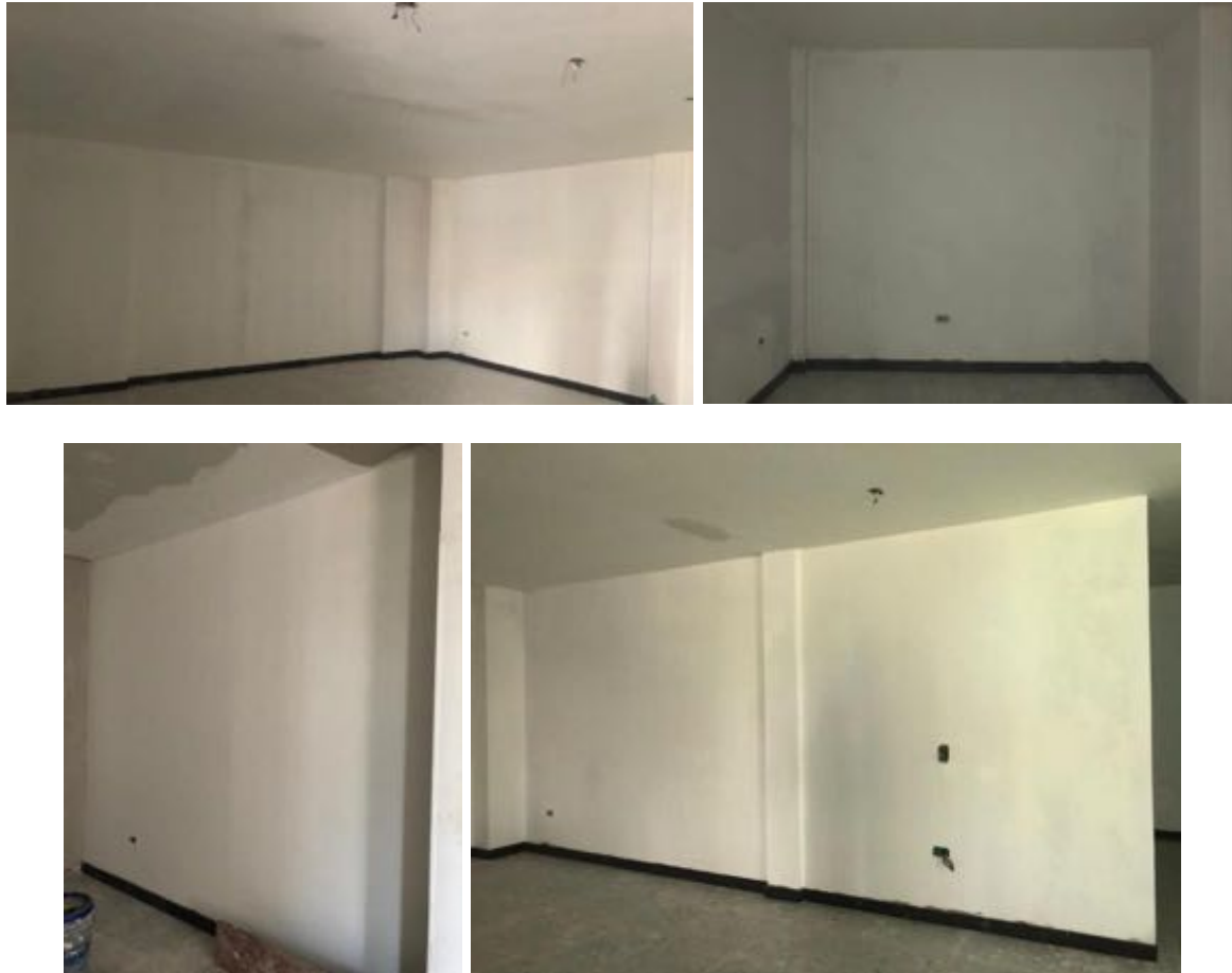
Ilustración 55 Estuco, resane y pintura de muros (Fuente propia).
