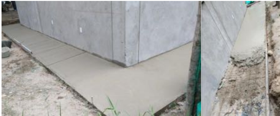
Ilustración 71 Anden perimetral (Fuente propia)
