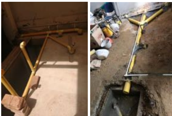
Ilustración 46 Instalación tubería servicio y drenaje para baños primer y segundo nivel (Fuente propia).
