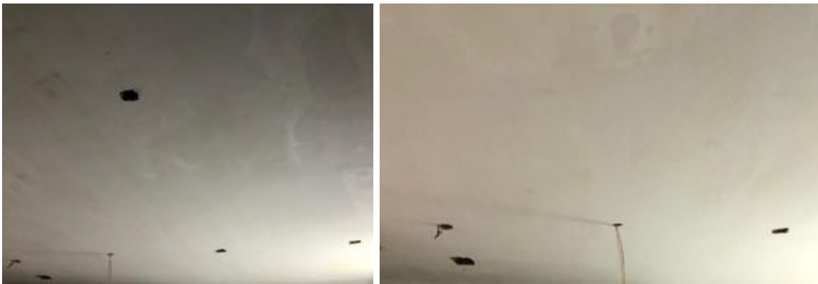
Ilustración 54 Resane bajo placa de segundo nivel (Fuente propia).
