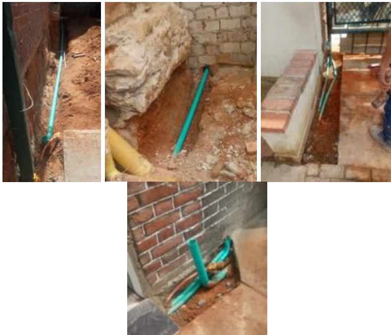
Ilustración 6 Instalación de Tubería (Fuente propia)
