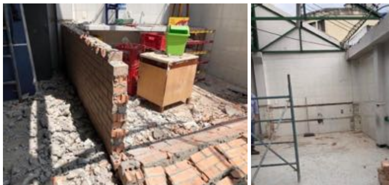
Ilustración 22 Demolición de enchape de pared (Fuente propia)
