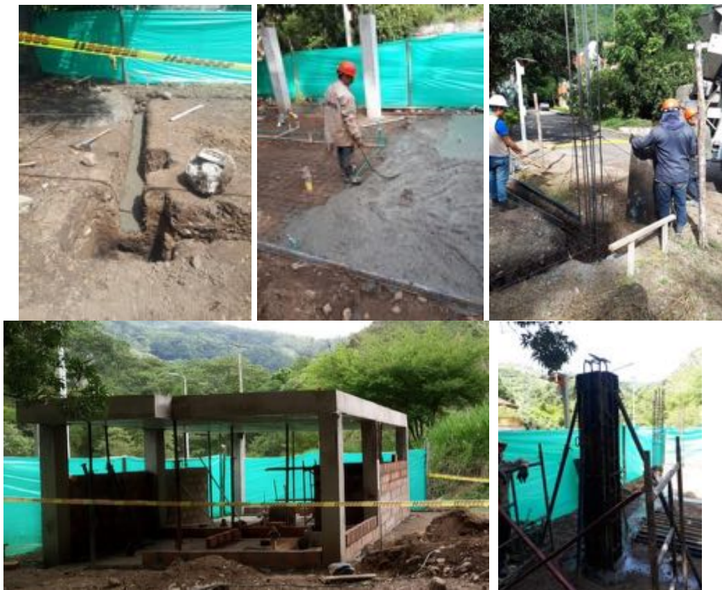
Ilustración 69 Columnas y vigas de Concreto 3500 PSI (Fuente propia)
