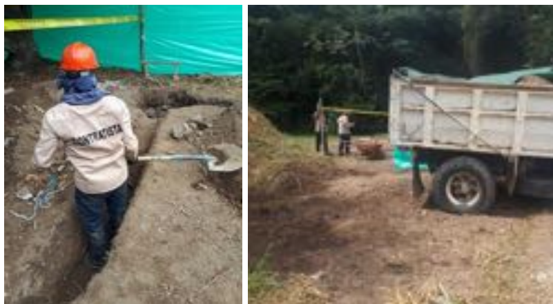
Ilustración 68 Excavación y retiro del suelo (Fuente propia)
