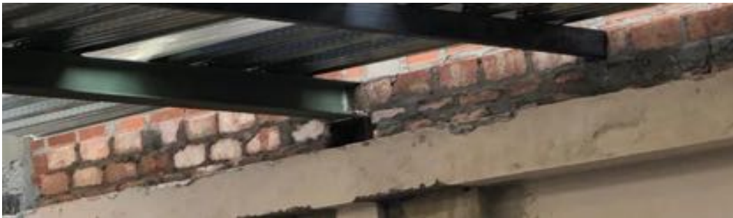
Ilustración 41 Muro en mampostería sobre viga (Fuente propia)
