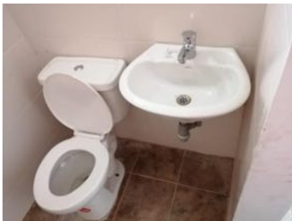
Ilustración 8 Instalación de sanitario (Fuente propia)
