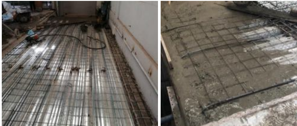
Ilustración 33 Amarre de varilla de refuerzo e instalación de Malla electrosoldada (Fuente propia)
