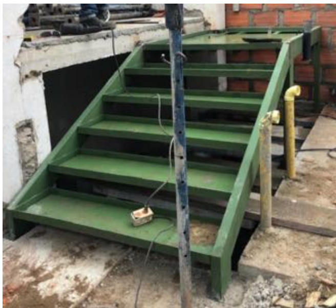
Ilustración 60 Instalación de escalera (Fuente propia).
