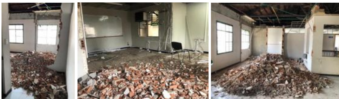
Ilustración 18 Demolición de muros (Fuente propia)
