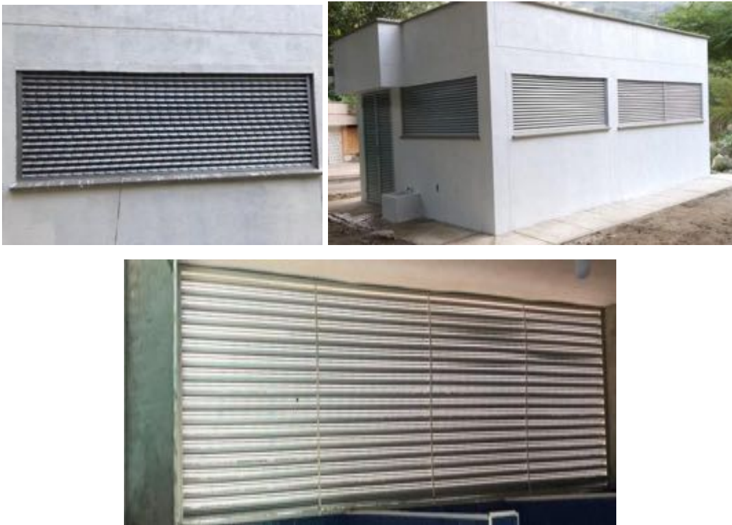
Ilustración 97 Instalación de Ventanería (Fuente propia)
