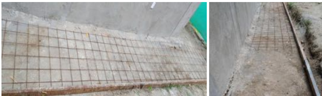
Ilustración 76 Malla electrosoldada en ánden (Fuente propia)
