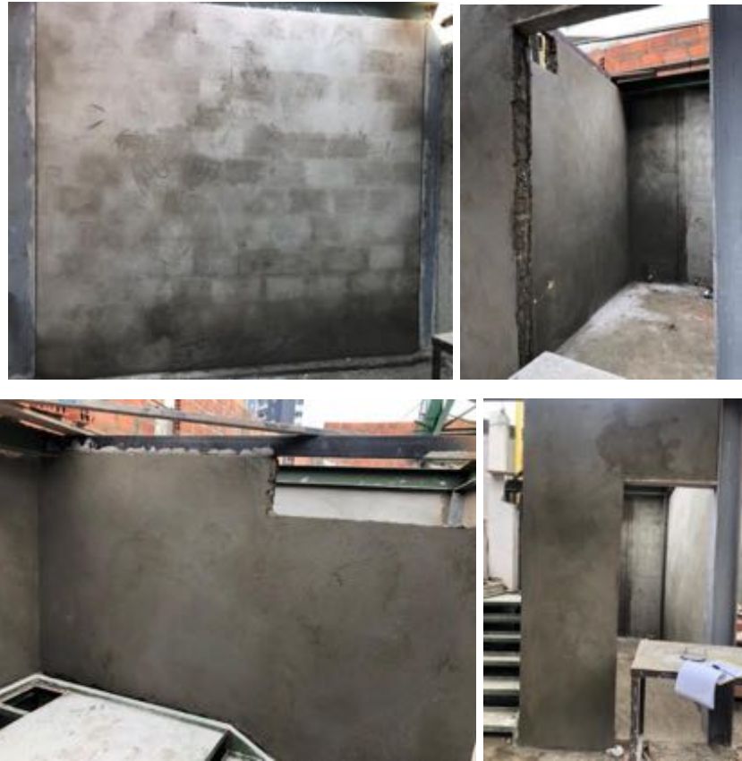
Ilustración 44 Friso de muro (Fuente propia).
