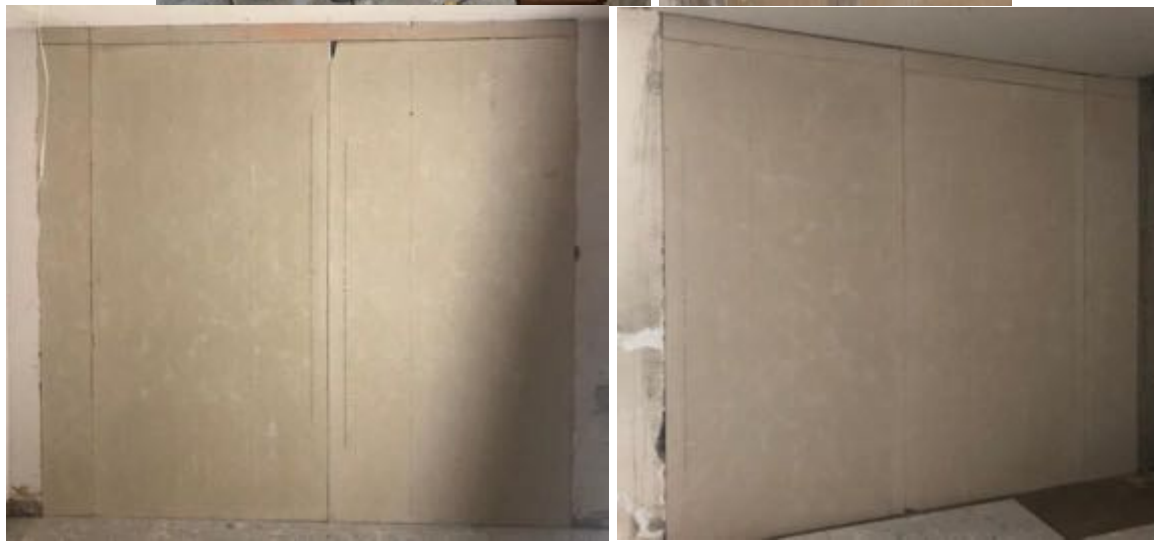
Ilustración 51 Instalación Muros eterboard (Fuente propia)
