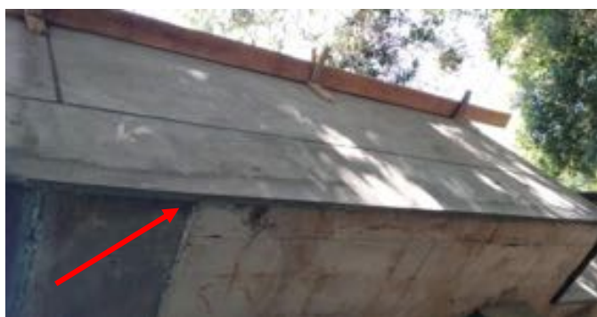
Ilustración 82 Construcción de Goteros (Fuente Propia)
