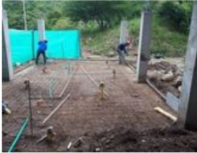
Ilustración 85 Suministro e instalación de Red Eléctrica (Fuente propia)
