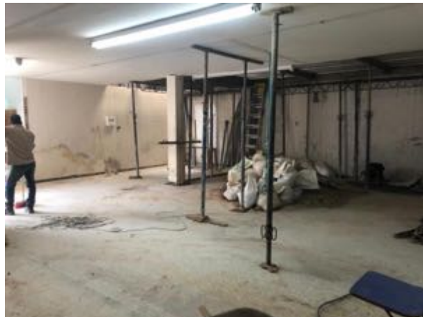
Ilustración 17 Demolición de muros primer piso (Fuente propia)
