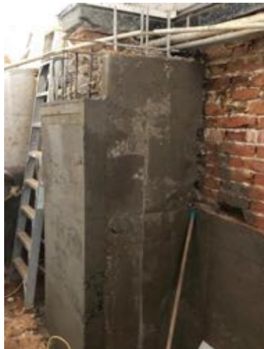
Ilustración 4 Columnas de concreto con acero de refuerzo (Fuente propia)
