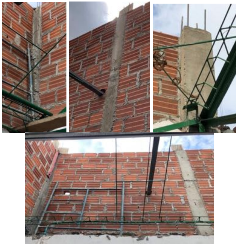
Ilustración 31 Construcción de columnetas (Fuente propia)
