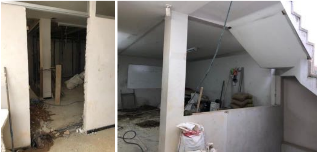
Ilustración 26 Desmonte de ventanería (Fuente propia)
