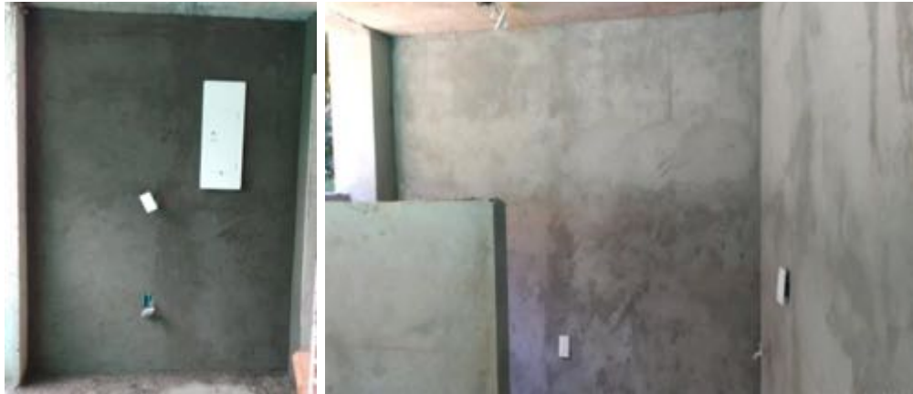
Ilustración 79 Friso Liso sobre muro (Fuente propia)
