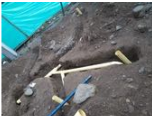
Ilustración 83 Instalación y suministro de Red Sanitaria (Fuente propia)
