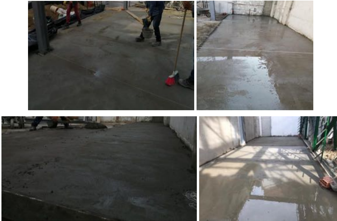
Ilustración 48 Mortero de piso en segundo nivel (Fuente propia)
