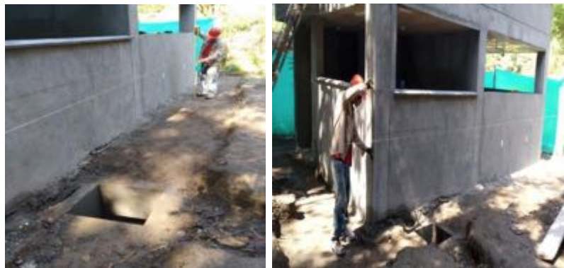
Ilustración 66 Replanteo de ánden perimetral (Fuente propia)
