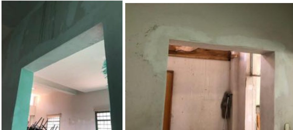
Ilustración 53 Resane de pared (Fuente propia).
