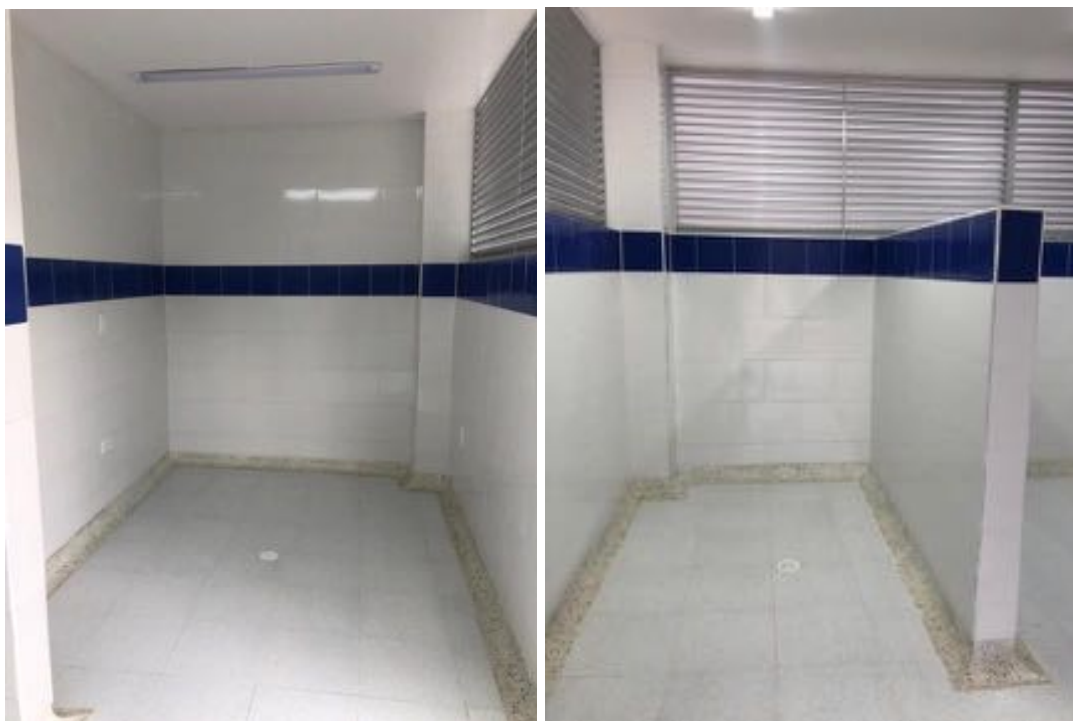
Ilustración 86 Enchape de muros (Fuente propia)
