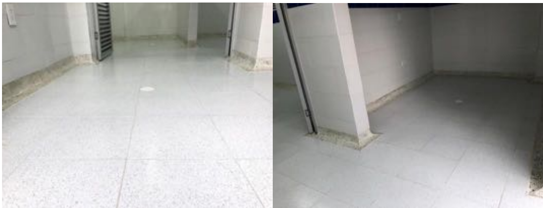
Ilustración 87 Enchape de piso (Fuente propia)
