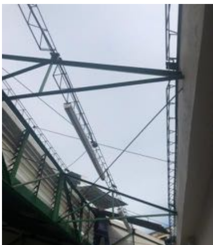
Ilustración 24 Desmonte de cubierta existente en segundo nivel (Fuente propia)
