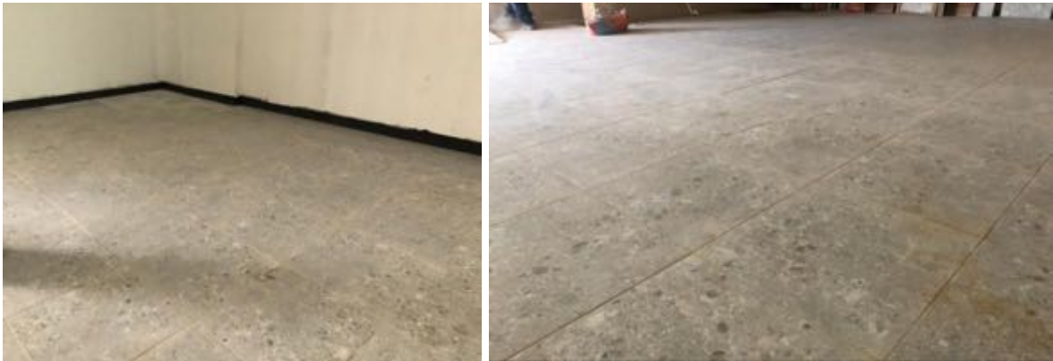
Ilustración 50 Enchape de piso (Fuente propia)
