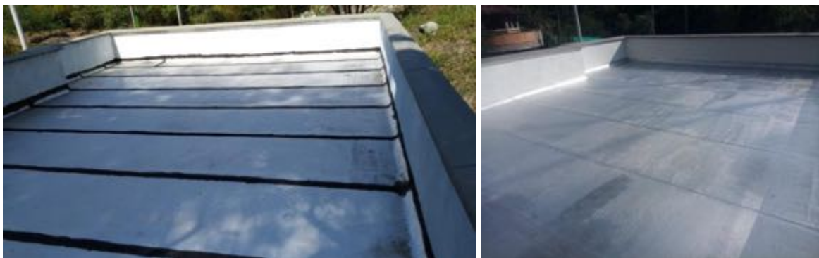
Ilustración 95 Impermeabilización de Cubierta con Manto Asfáltico (Fuente propia)
