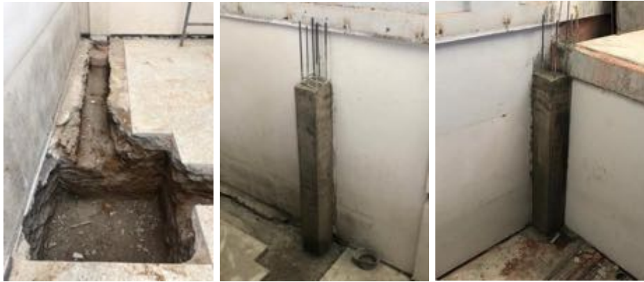
Ilustración 30 Columnas primer nivel (Fuente propia)
