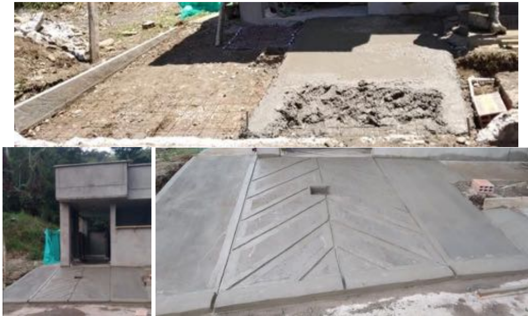
Ilustración 73 Construcción de Rampa (Fuente propia)
