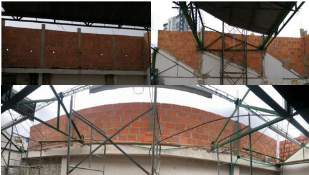
Ilustración 38 Muro en mampostería (Fuente propia)
