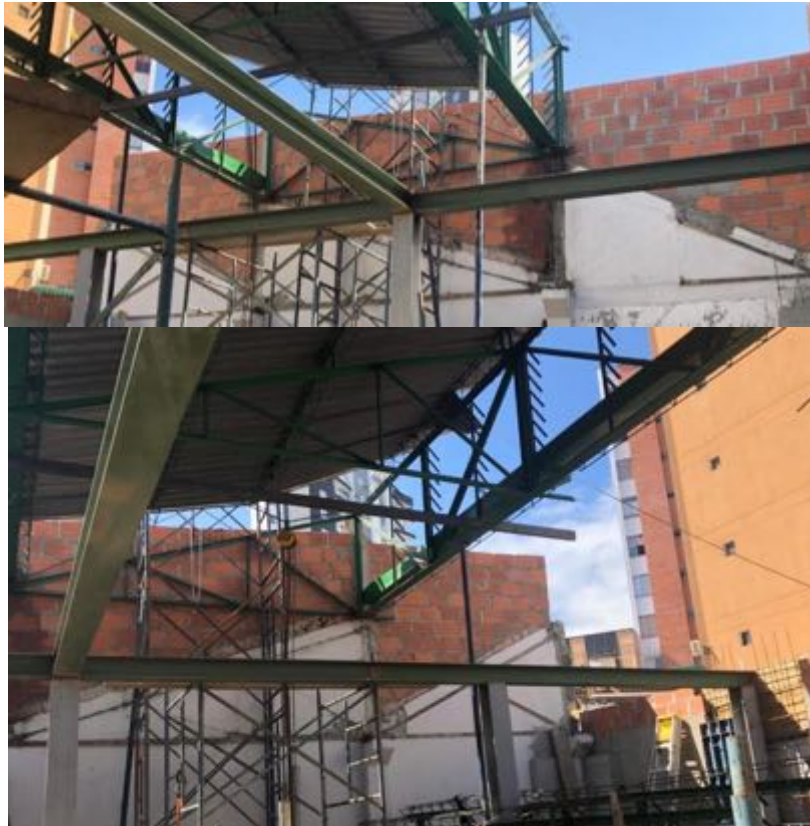
Ilustración 57 Instalación de vigas en perfil HEA 180 (Fuente propia).
