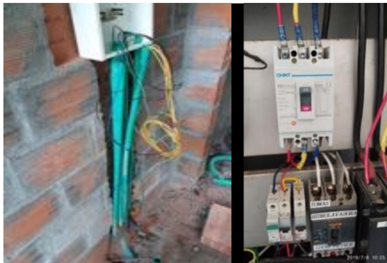
Ilustración 103 Instalación de tablero trifasico (Fuente propia)
