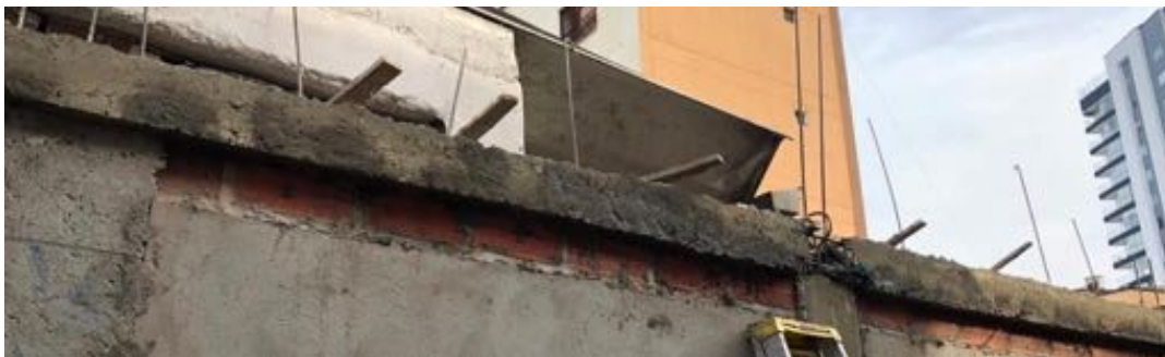
Ilustración 29 Construcción de viga.
