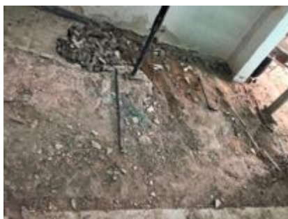
Ilustración 23 Demolición de Enchape (Fuente propia)
