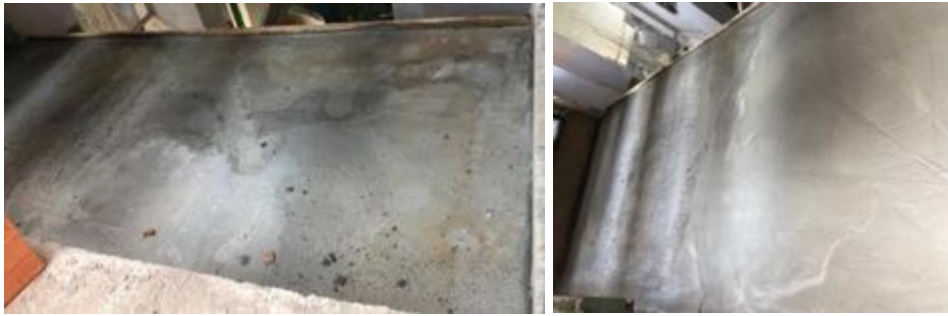
Ilustración 35 Placa de concreto sobre placa superior de primer nivel (Fuente propia)
