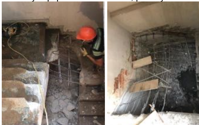
Ilustración 21 Demolición de escaleras (Fuente propia)
