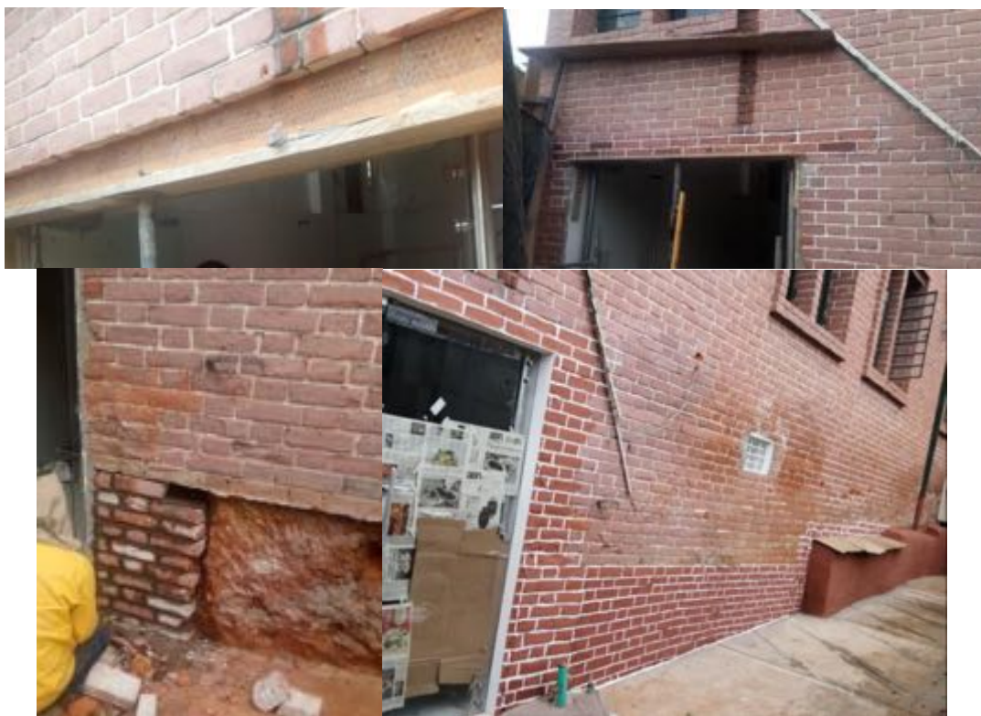
Ilustración 13 Muro de mamposteria (Fuente propia)
