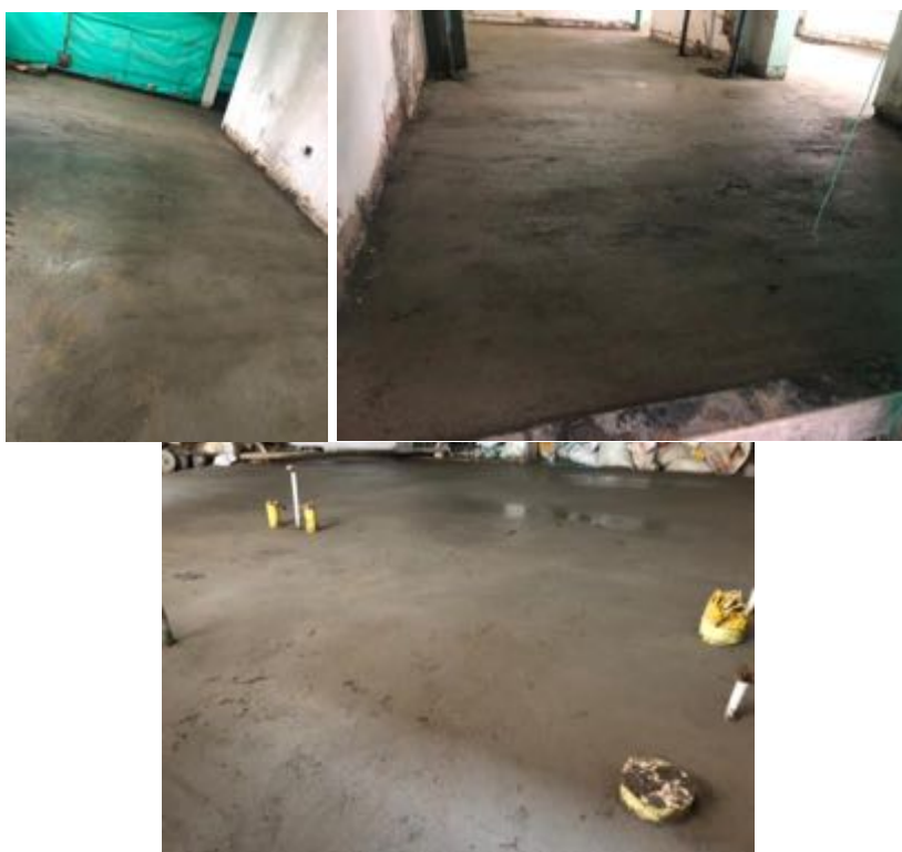
Ilustración 47 Mortero de piso de primer nivel (Fuente propia)
