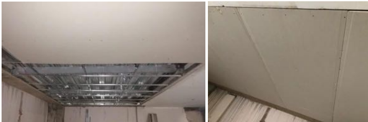
Ilustración 52 Instalación techo eterboard (Fuente propia).
