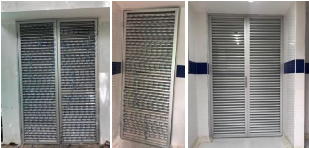
Ilustración 96 Puerta en carpintería metálica (Fuente propia)
