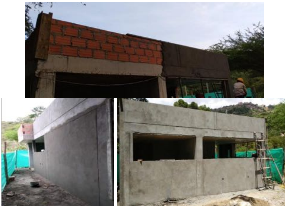
Ilustración 80 Friso Impermeabilizado (Fuente propia)
