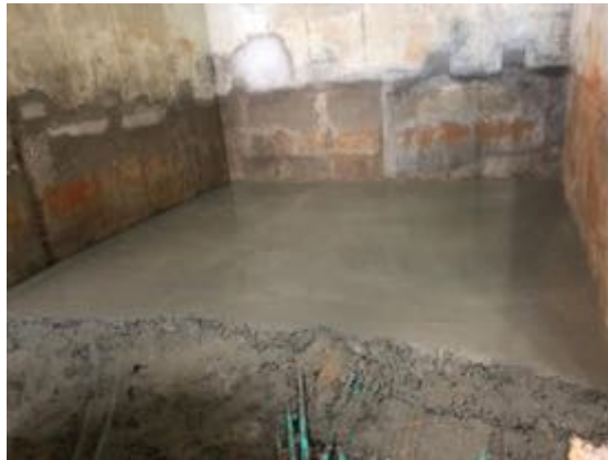
Ilustración 5 Fundida de placa de piso (Fuente propia)
