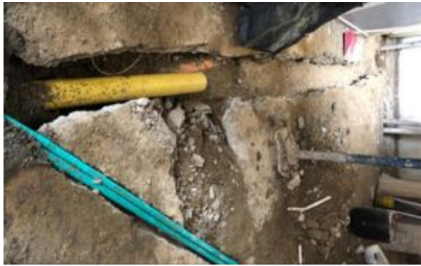
Ilustración 49 Instalación de Tubería (Fuente propia)
