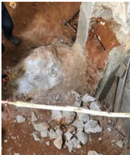
Ilustración 2 Excavación en roca (Fuente propia)
