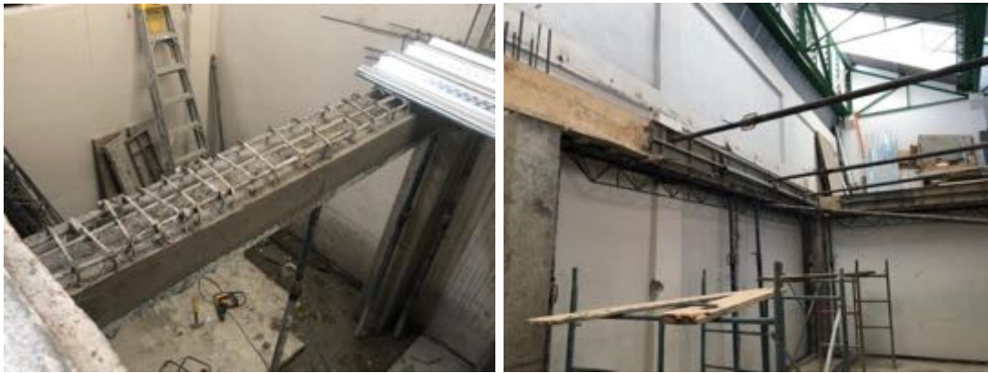
Ilustración 28 Fundida de vigas aereas (Fuente propia)
