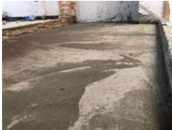
Ilustración 34 Fundida de placa segundo nivel (Fuente propia)
