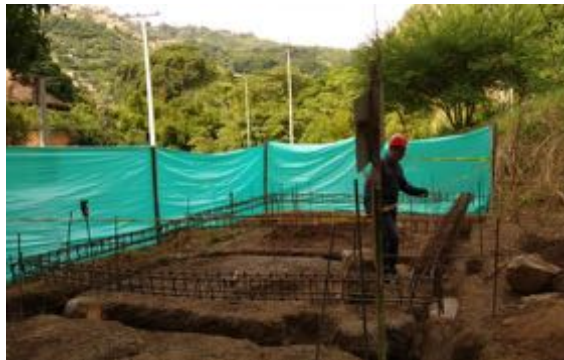
Ilustración 75 Amarre de Acero (Fuente propia)
