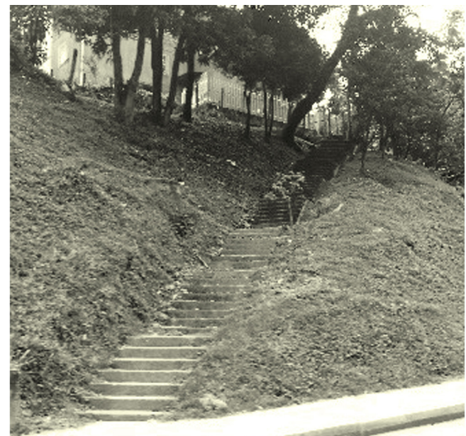
Imagen Número 20: Escaleras y pendiente de acceso a B. Rincón desde calle 4f y quebrada caza diana
