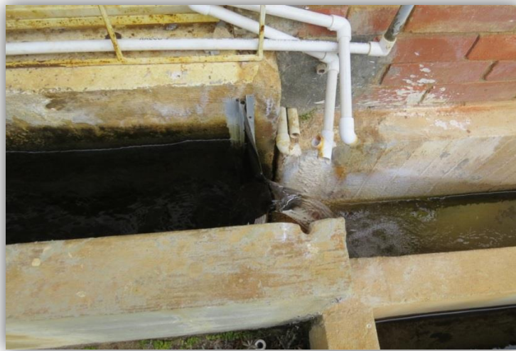
Ilustración 1. Zona de Coagulación PTAP-ACUABE
