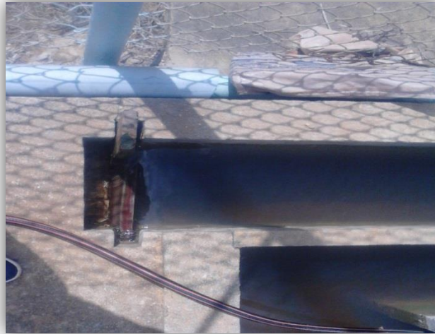
Ilustración 5. Compuerta implementa a la salida del floculador
