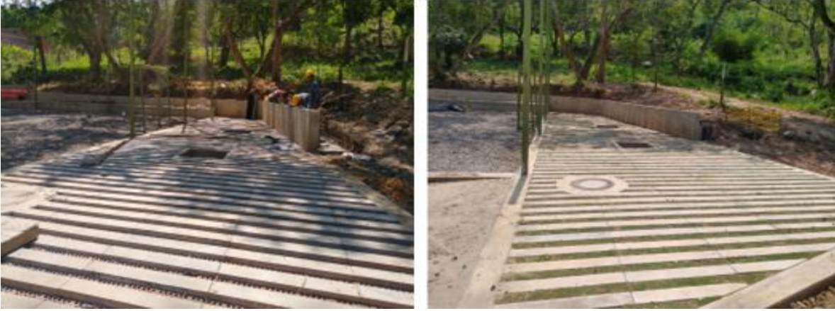
Ilustración 43 Instalación prado japonés
