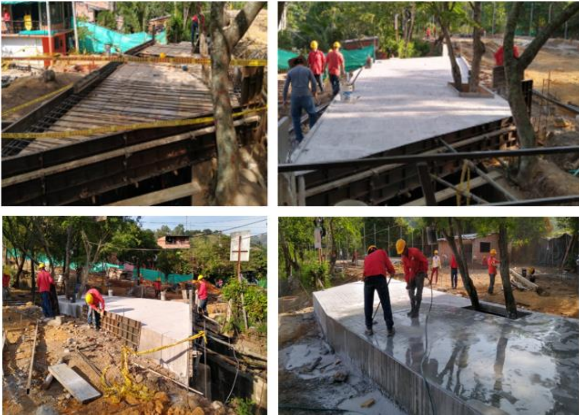
Ilustración 14 Construcción paso a nivel plazoleta principal
