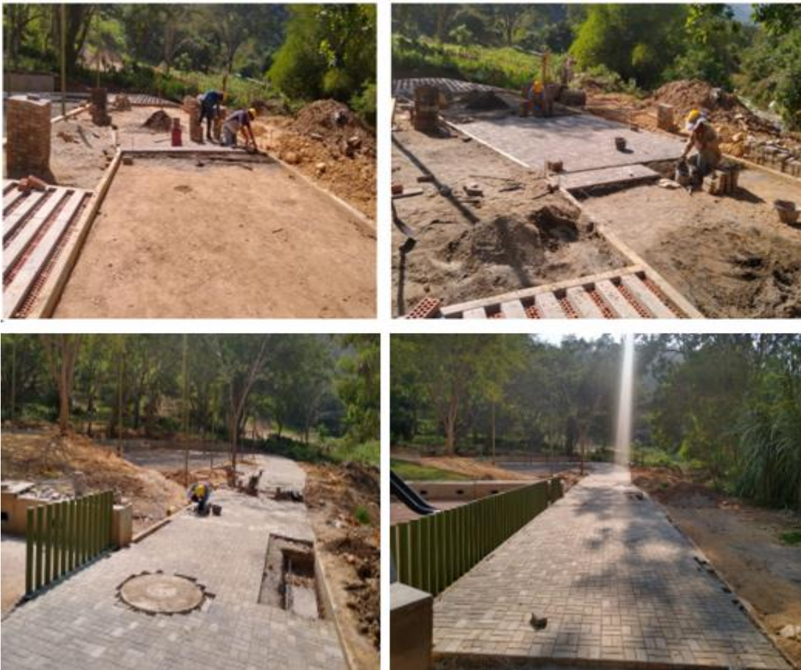
Ilustración 46 Instalación de adoquín
