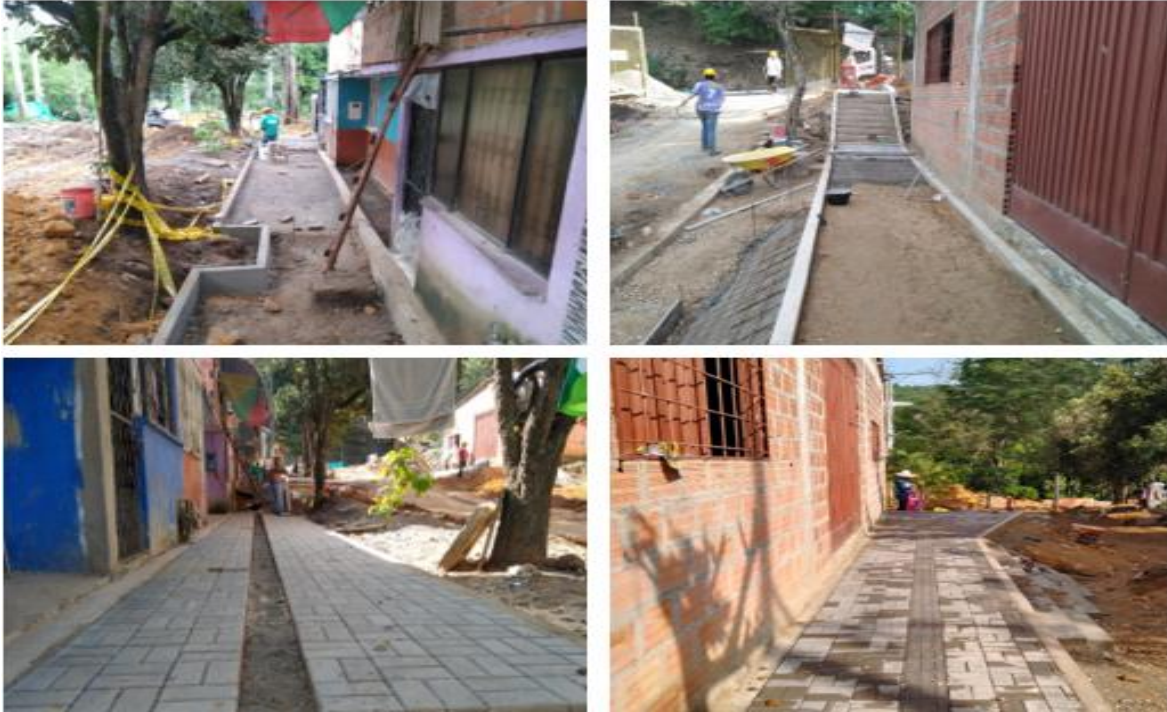
Ilustración 34 Instalación adoquín iglesia y colegio
