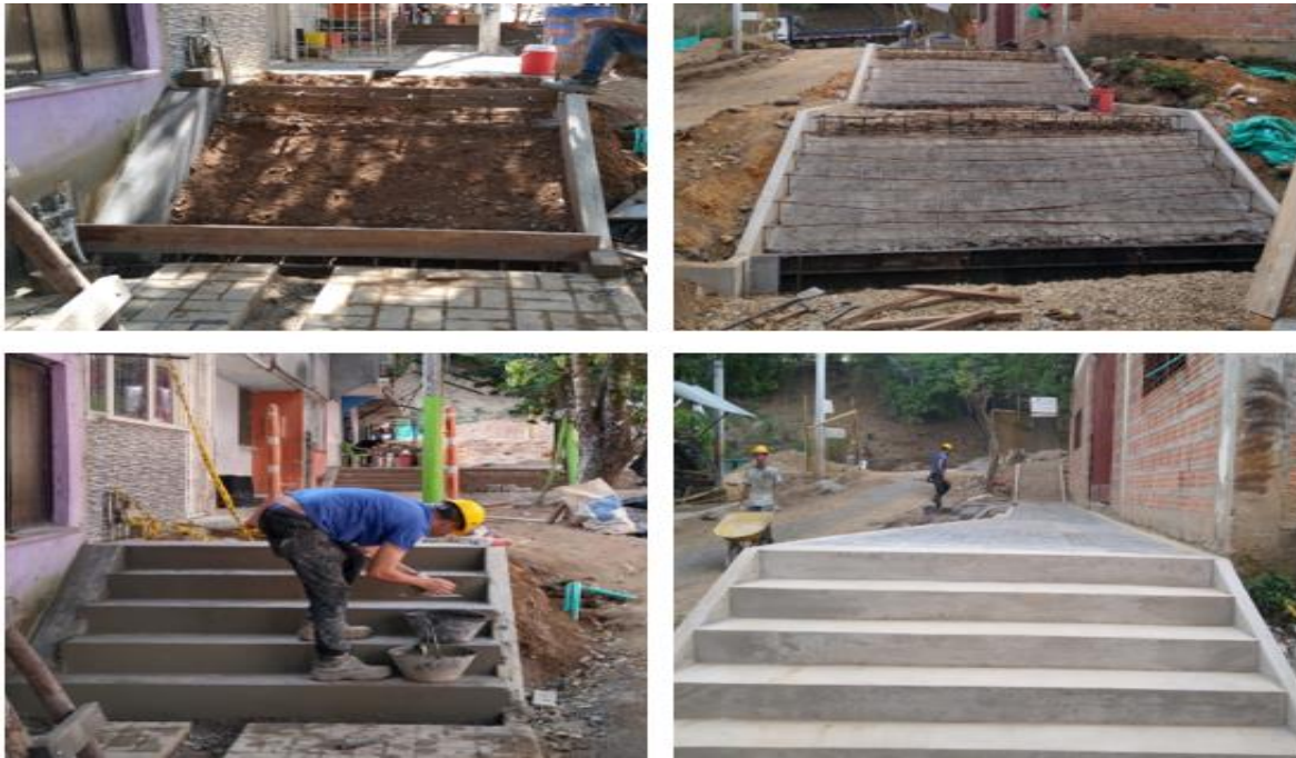
Ilustración 33 Construcción escaleras
