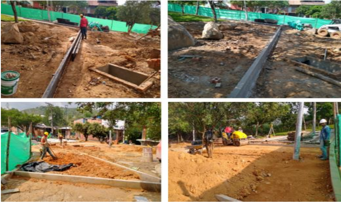
Ilustración 10. Bordillos paso a nivel. plazoleta principal
