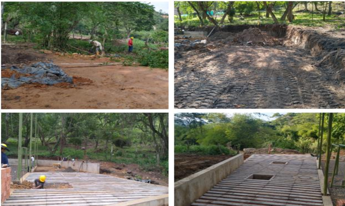
Ilustración 42 Construcción zona picnic cancha sintética
