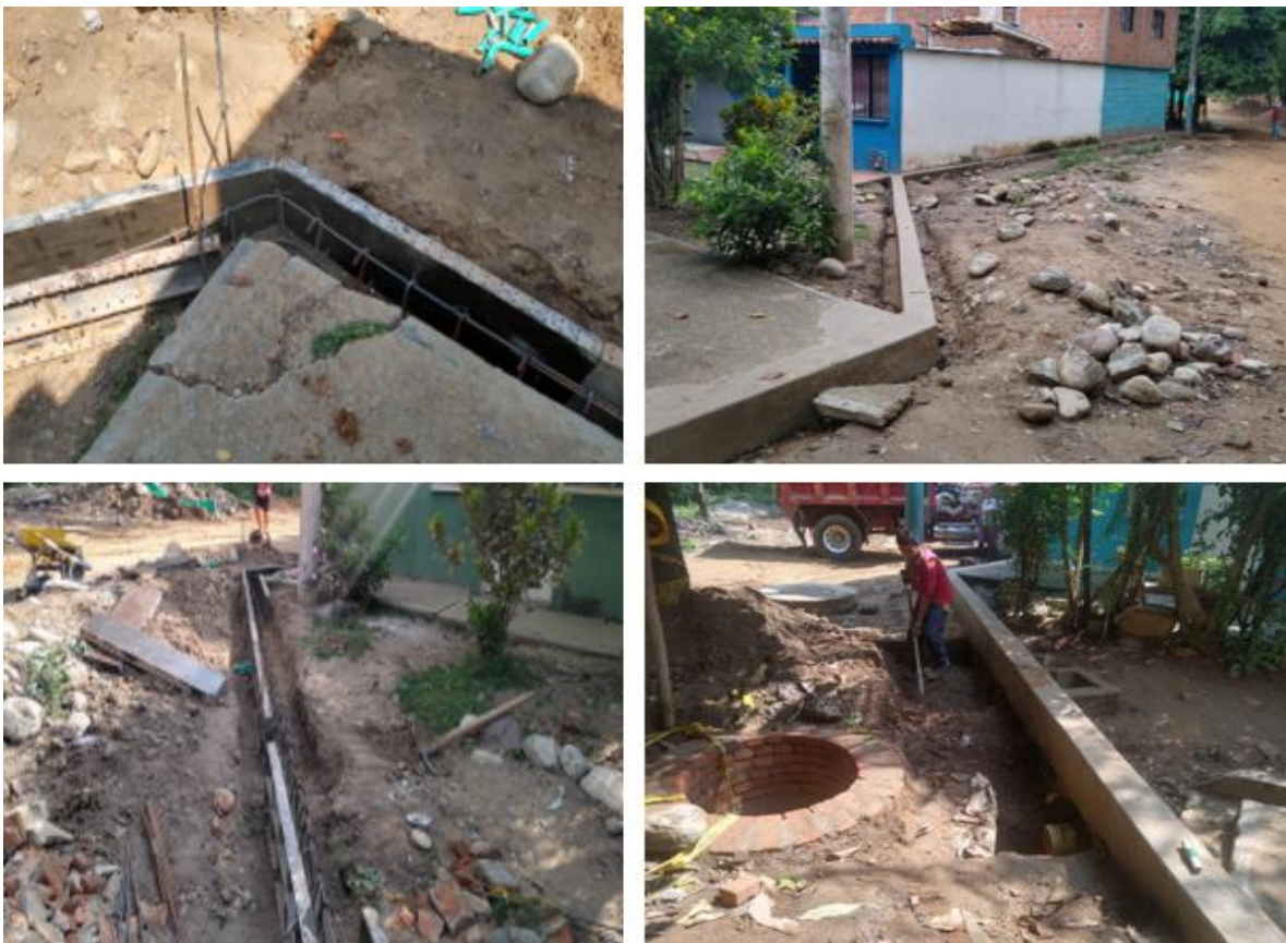
Ilustración 26 Vigas confinamiento zona 2
