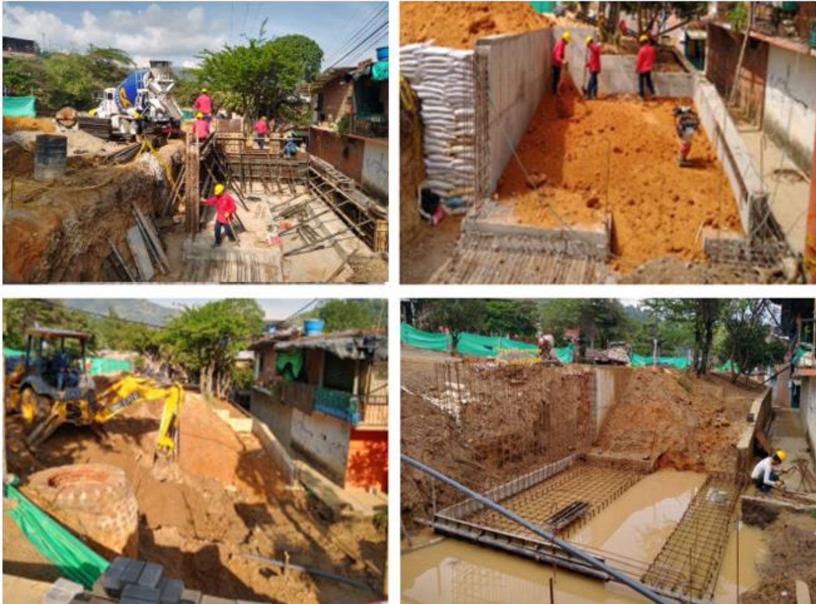
Ilustración 13. Construcción rampa de acceso al barrio plazoleta principal
