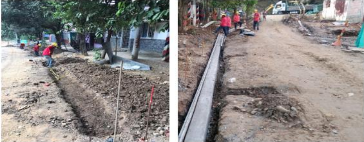
Ilustración 31 Vigas de confinamiento adoquín vehicular
