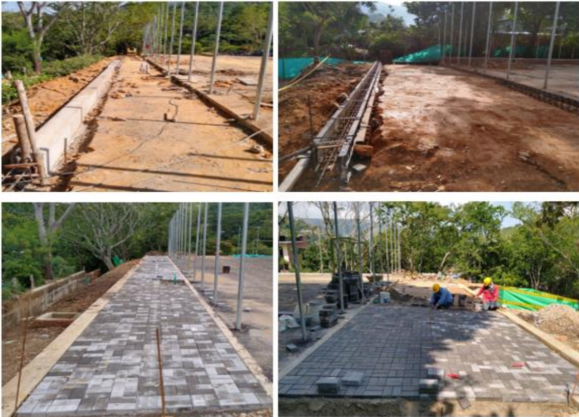
Ilustración 19 Instalación adoquín plazoleta cancha múltiple
