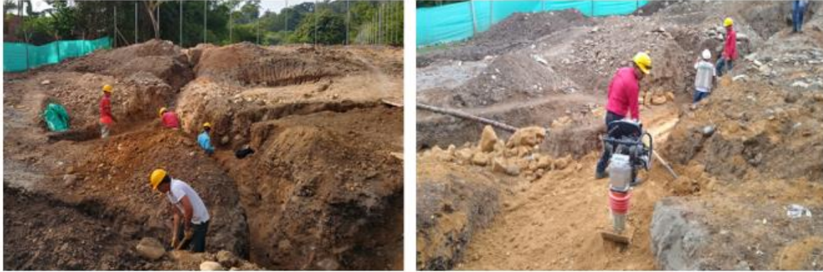
Ilustración 20 Instalación red pluvial rampas de acceso
