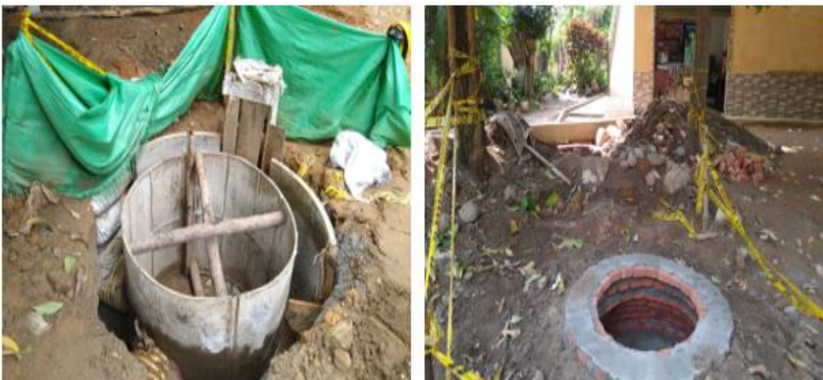
Ilustración 24 Construcción pozos zona 2
