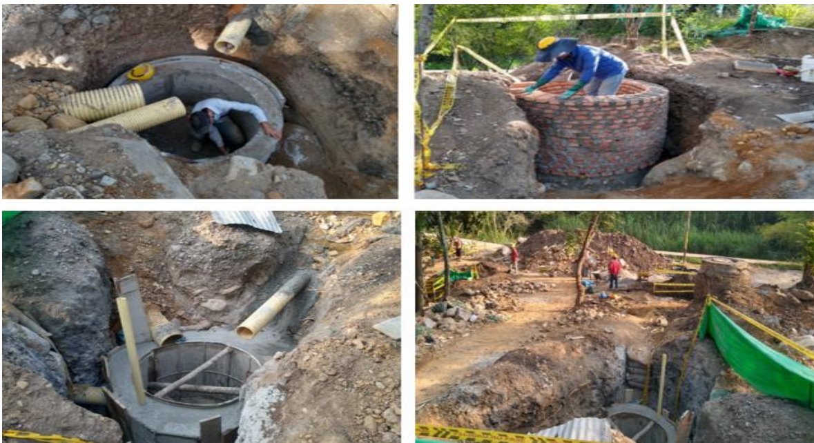
Ilustración 21 Construcción pozos sector rampa de acceso
