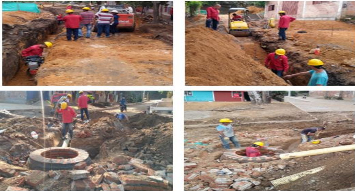
Ilustración 30 Instalación red pluvial
