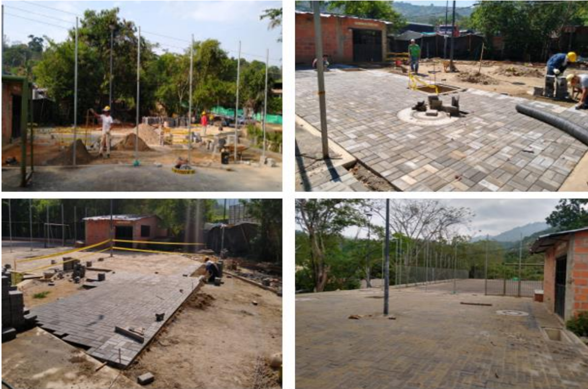
Ilustración 16 Instalación adoquín sector salón social
