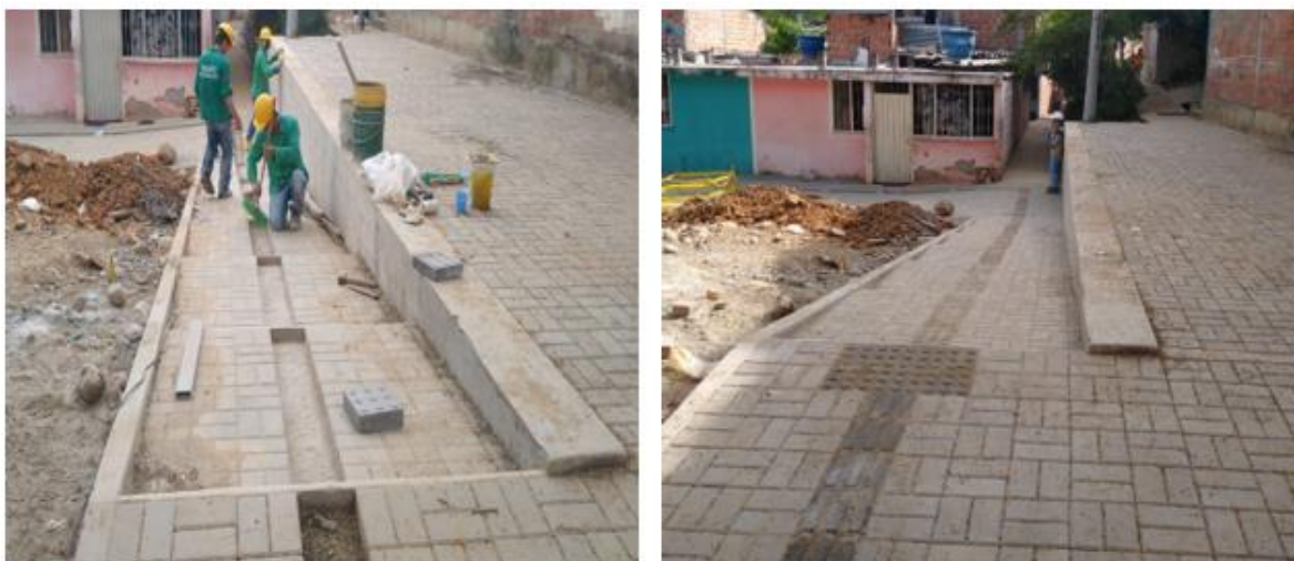
Ilustración 35 Línea táctil rampa caballera
