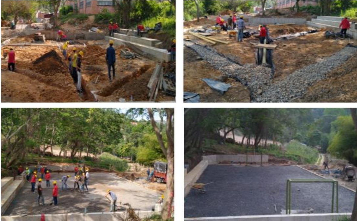
Ilustración 40 Drenaje cancha sintética
