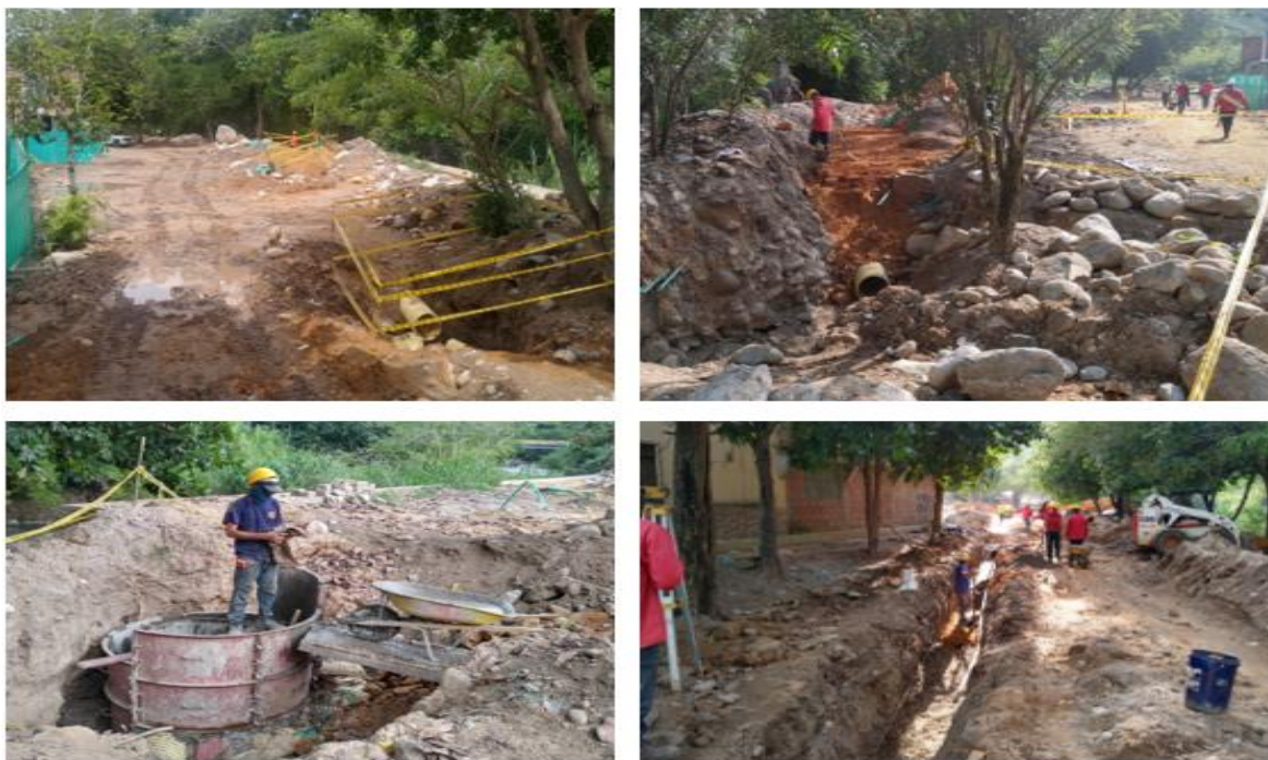
Ilustración 23 Instalación red pluvial zona 2
