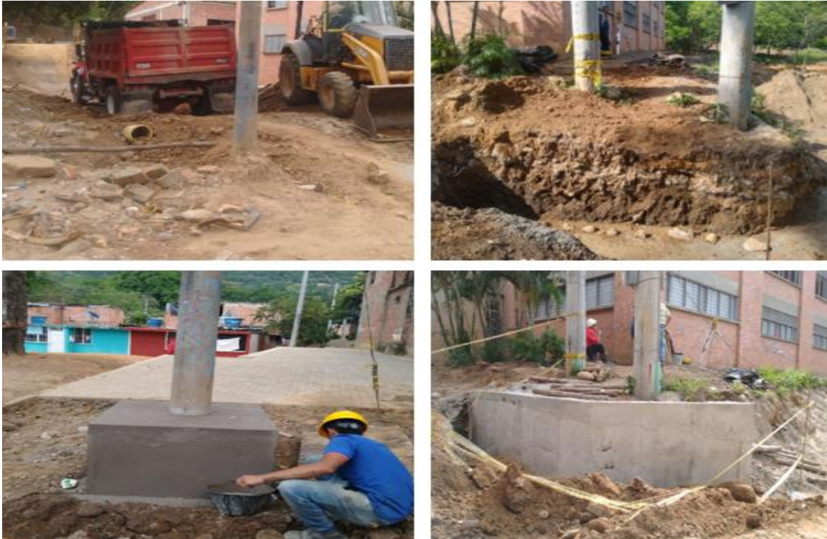
Ilustración 37 Contención postes eléctricos
