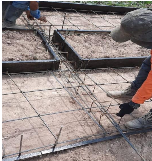
Figura 6. Supervisión de la construcción de la placa huella
