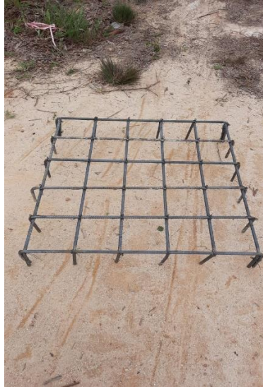
Figura 17. Emparrillado de la zapata
