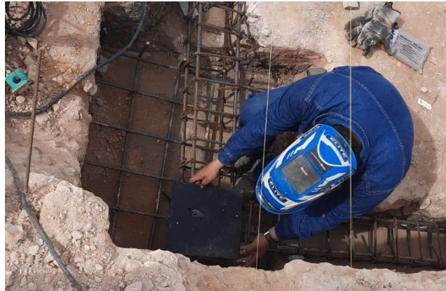
Figura 18. Soldadura de las platinas
