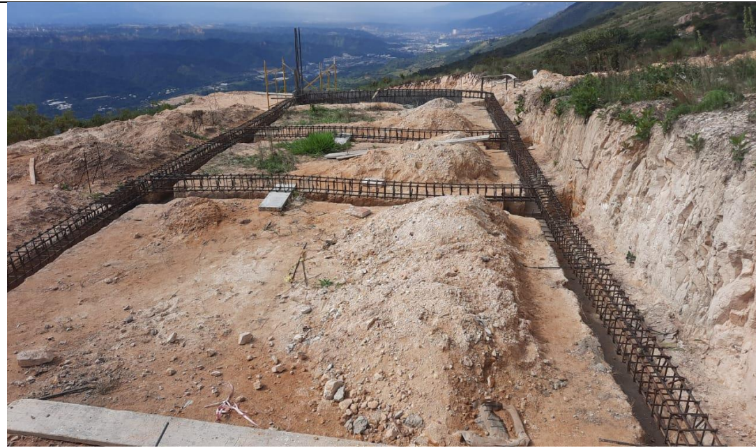
Figura 15. Armado de emparrillado
