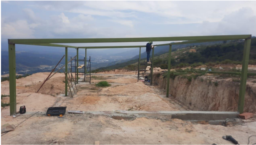
Figura 20. Instalación de las columnas en A500
