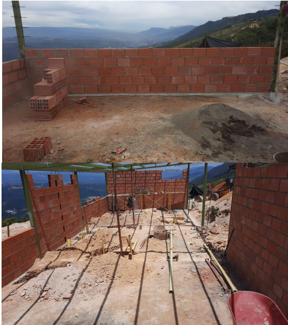
Figura 21. Mampostería zona social
