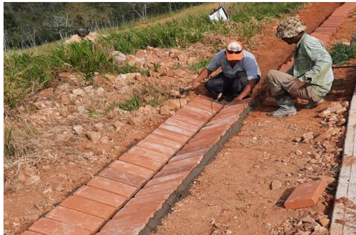
Figura 7. Supervisión de la construcción de la canaleta
