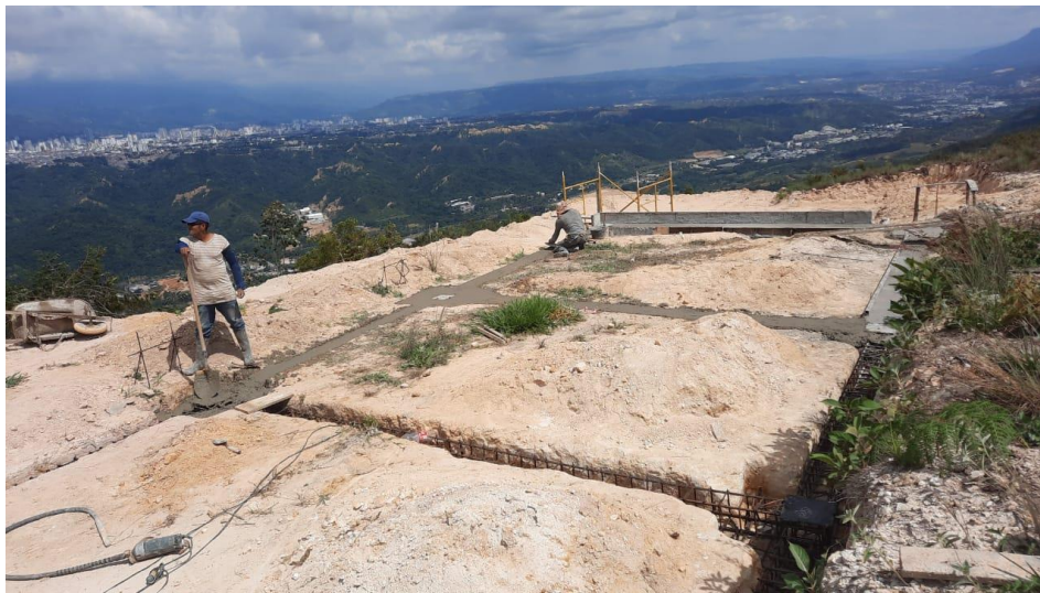
Figura 19. Fundida del concreto para la cimentación
