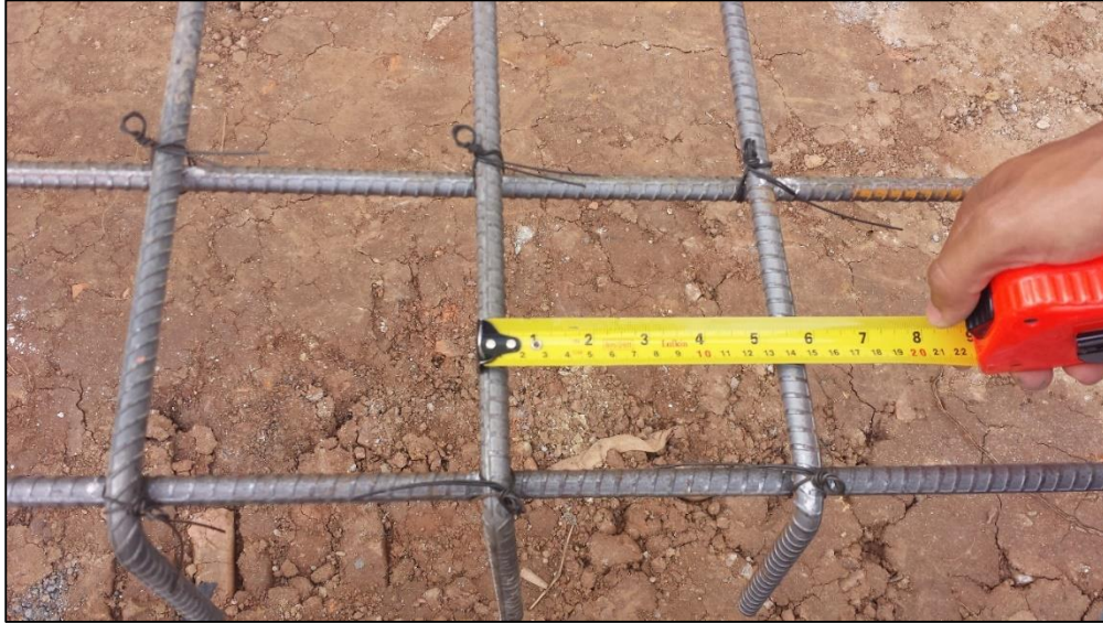
Figura 5. Verificación distanciamiento refuerzo
