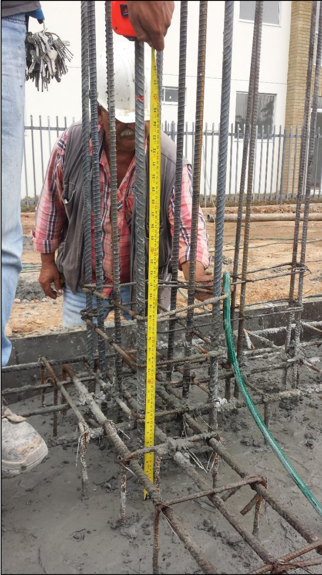
Figura 7. Verificación espesor cimentacion
