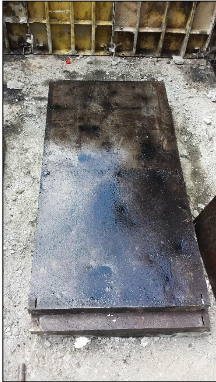
Figura 26. Formaleta con desencofrante
