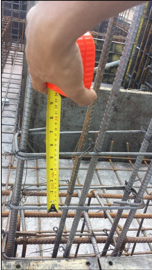
Figura 22. Verificación distancia flejes
