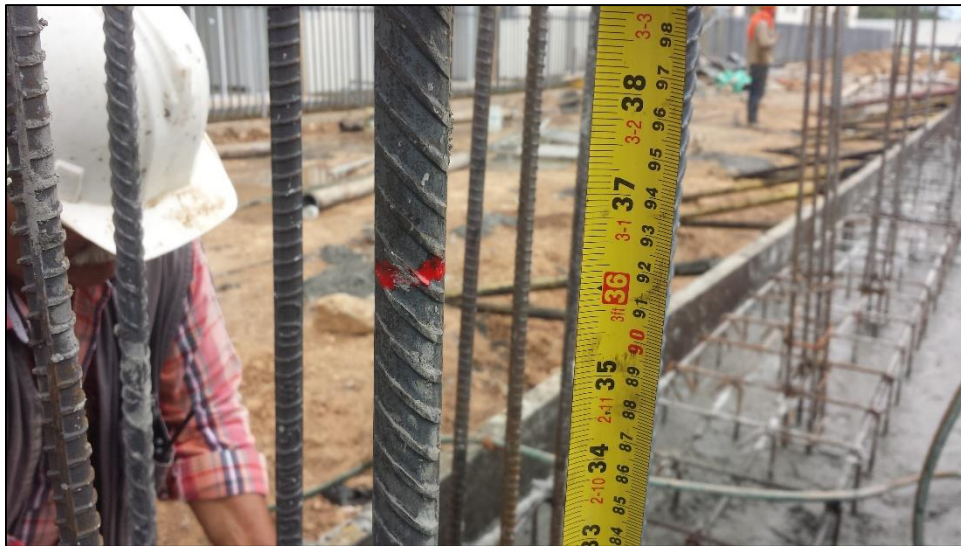
Figura 6. Verificación espesor cimentacion marca
