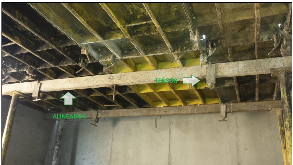
Figura 25. Formaleta con sus elementos de apoyo
