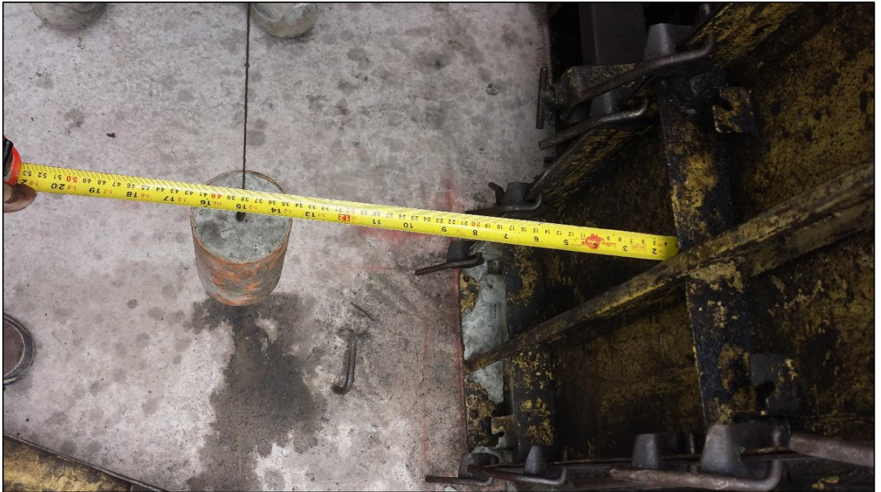
Figura 31. Verificación aplomada muros
