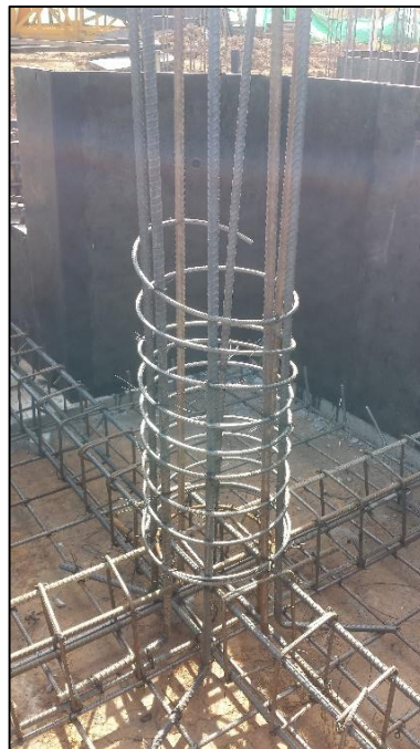
Figura 21. Refuerzo de Columna
