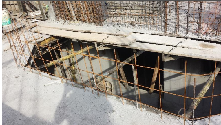
Figura 20. Refuerzo de antepecho, malla 0.24
