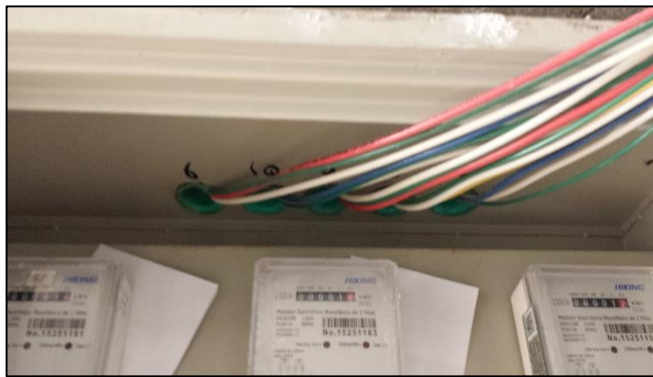
Tomadas en obra el día 1/11/2016
