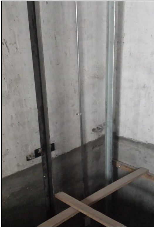
Figura 8. Instalación rieles
