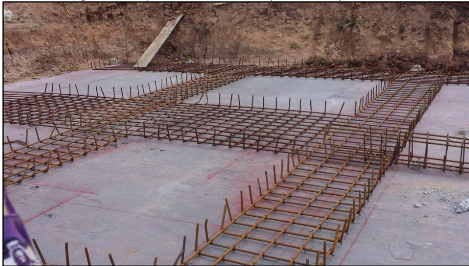
Figura 2. Óptima marcación (cimbrado) en el solado
