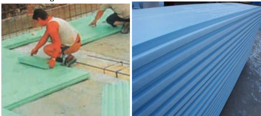
Figura 39: Instalación de Poliestireno Extruido
