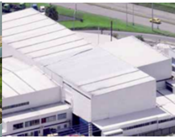
Tejado de membrana de PVC Sarnafi 1 S327-12L .
